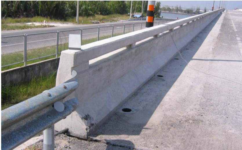
รูปที่ 2-18 แสดงตัวอย่างราวสะพานแบบที่ไม่มีทางเดินเท้า(ราวสะพานของกรมทางหลวง แบบที่ 1)
