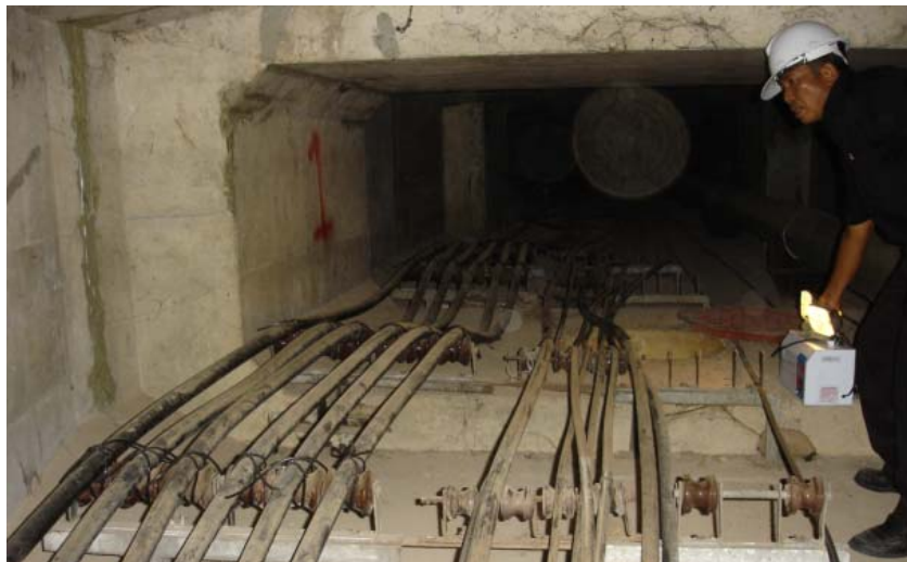
รูปที่ 2-38 แสดงตัวอย่างช่องว่างภายในโครงสร้างสะพานรูปกล่อง
