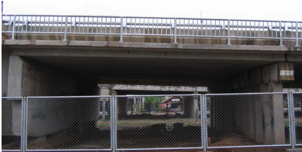
รูปที่ 2-30 แสดงด้านนอกราวสะพานแบบที่มีทางเดินเท้าติดอยู่กับผิวการจราจร ของกรมทางหลวงแบบที่ 5
