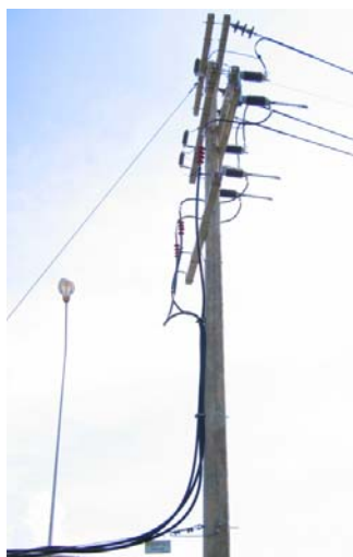
รูปที่ 3-27 การติดตั้งอุปกรณ์ที่เสาดันเข้าหัวสายเคเบิล(Cable Terminator Pole)
