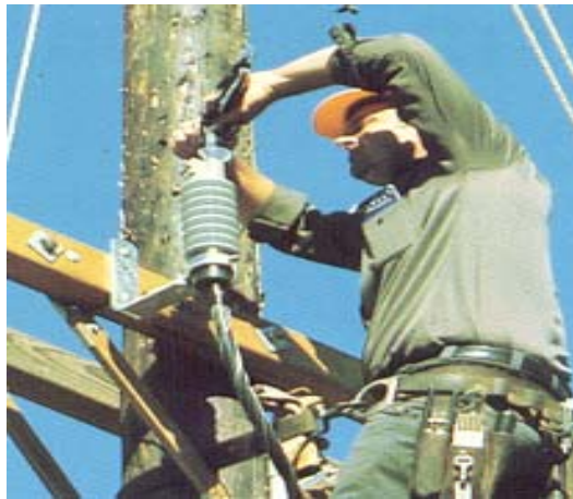
รูปที่ 4-8 แสดงตัวอย่างหัวสายเคเบิลใต้ดินแบบ Porcelain Type
