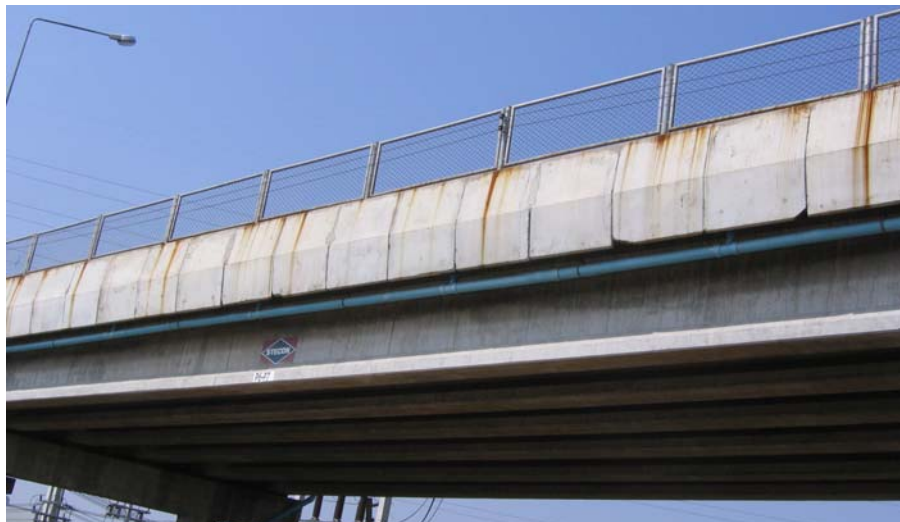
รูปที่ 2-32 แสดงราวสะพานแบบหล่อเป็นชิ้นสำเร็จนำมาประกอบ
