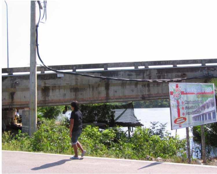
รูปที่ 1-2 การติดตั้งสายหุ้มฉนวนเต็มพิกัดดีเกลิยว(TAC) ดันก่อนเกาะสะพาน
