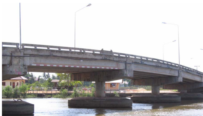
รูปที่ 3-23 การติดตั้งสายหุ้มฉนวนเต็มพิกัดดีเกิลยว(TAC) เกาะสะพาน
