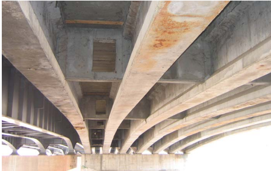
รูปที่ 2-36 แสดงตัวอย่างสะพานที่มีการทำช่องสำหรับเดินระบบสาธารณูปโภคไว้
