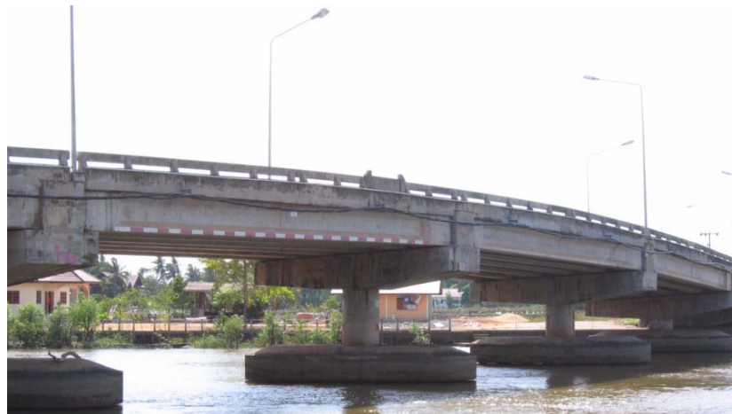
รูปที่ 1-3 การติดตั้งสายหุ้มฉนวนเต็มพิกัดดีเกลิยว(TAC) เกาะสะพาน
