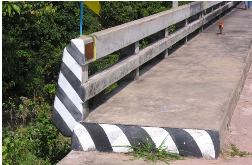
รูปที่ 2-25 แสดงราวสะพานแบบที่มีทางเดินเท้าติดอยู่กับผิวการจราจร ของกรมทางหลวงชนบท
