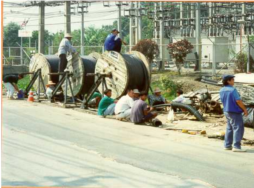
รูปที่ 4-30 แสดงการตั้ง REEL สายเคเบิลใต้ดินที่ปากบ่อ MANHOLE เพื่อดึงลากสายเคเบิลใต้ดิน
