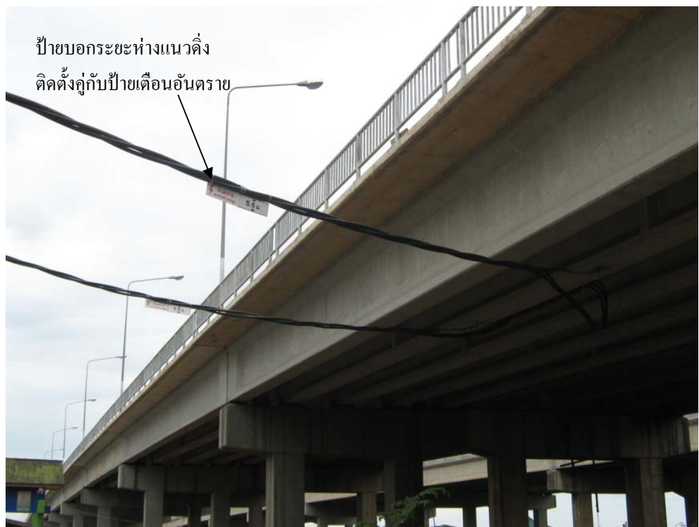
รูปที่ 3-26 แสดงตัวอย่างการติดตั้งป้ายบอกระยะห่างในแนวตั้งของสายไฟฟ้ากับพื้นถนน
