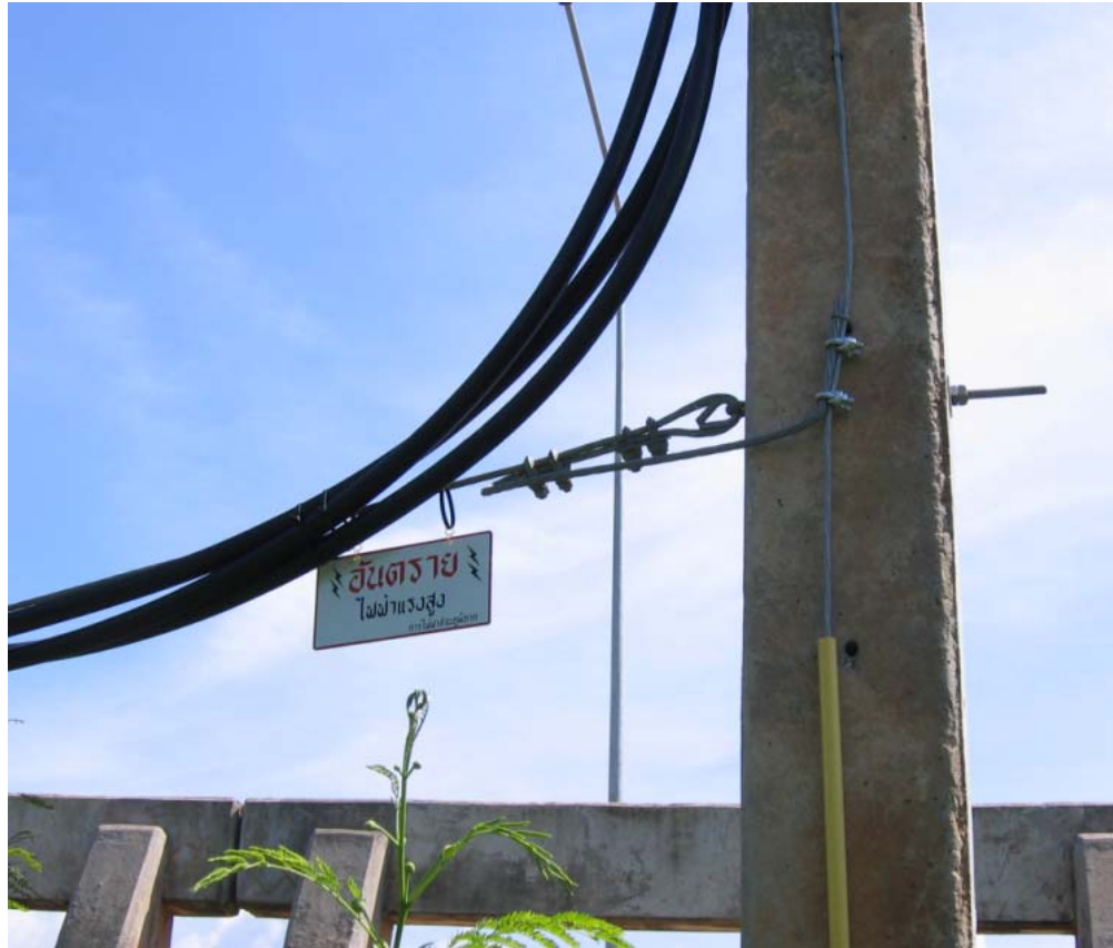
รูปที่ 3-25 แสดงตัวอย่างการติดตั้งป้ายเตือน
