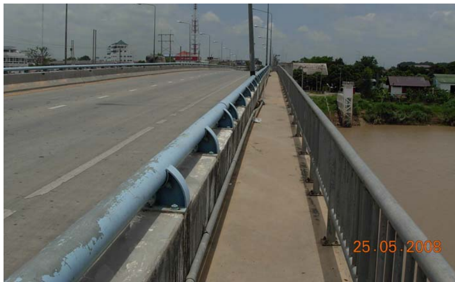
รูปที่ 2-29 แสดงราวสะพานแบบที่มีทางเดินเท้าแยกต่างหากจากผิวการจราจร ของกรมทางหลวงแบบที่ 5
