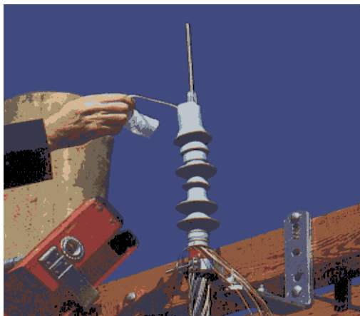
รูปที่ 4-10 แสดงตัวอย่างหัวสายเคเบิลใต้ดินแบบ Cold Shrink Type
