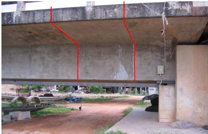
รูปที่ 2-15 แสดงตัวอย่างโครงสร้างรูปกล่องยาว 3 เมตร นำมาต่อกัน
