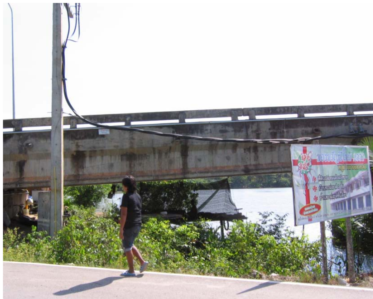
รูปที่ 3-22 การติดตั้งสายหุ้มฉนวนเต็มพิกัดดีเกิลยว(TAC) ต่อก่อนเกาะสะพาน
