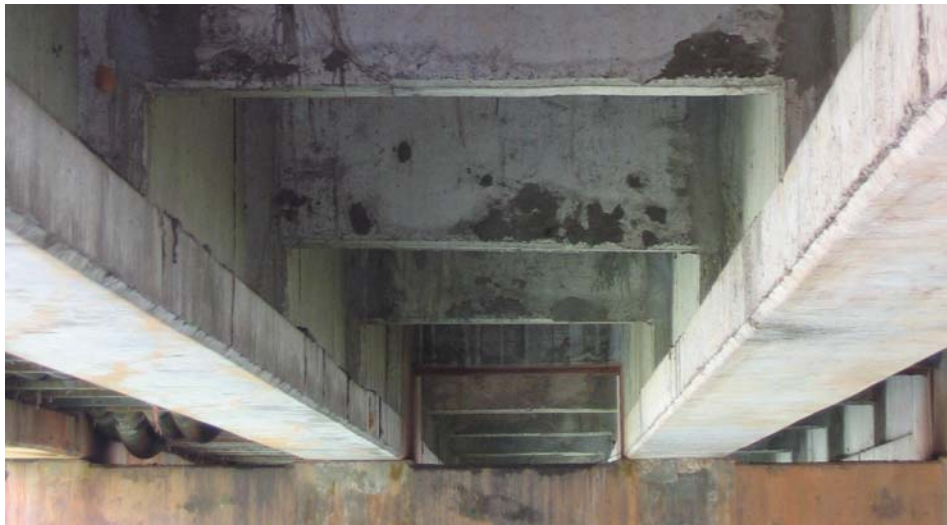
รูปที่ 2-36 แสดงตัวอย่างสะพานที่มีการทำช่องสำหรับเดินระบบสาธารณูปโภคไว้
