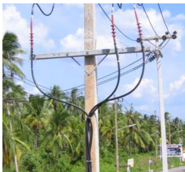
รูปที่ 3-9 ลักษณะการติดตั้งเข้าหัวเคเบิล
