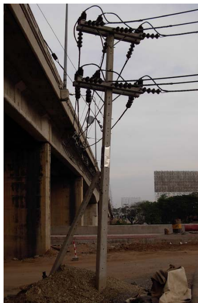
รูปที่ 3-21 แสดงเสาต้นติดตั้งเคเบิลอากาศ ก่อนเกะสะพาน
