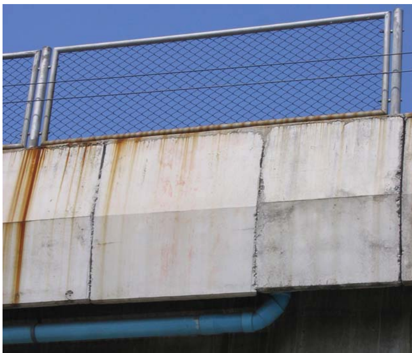
รูปที่ 2-33 แสดงราวสะพานแบบหล่อเป็นชิ้นสำเร็จเชื่อมต่อกัน
