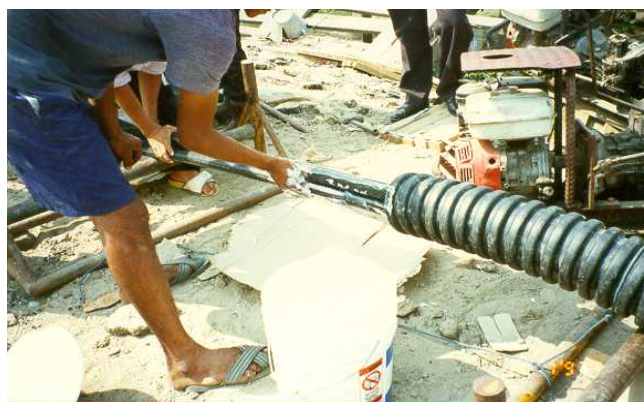
รูปที่ 4-31 แสดงการใช้สารหล่อลื่นช่วยในการดึงลากสายเคเบิลใต้ดิน
