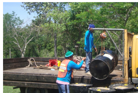
ใช้คานยีนดัดรอกโซ่ แรงงาน 2 คน
