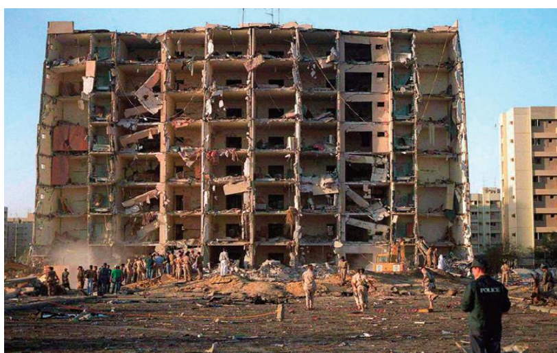
รูปที่ 7-12 ความเสียหายของอาคารทางทหาร Khobar Towers (ที่มา: FEMA-426/BIPS-06)
