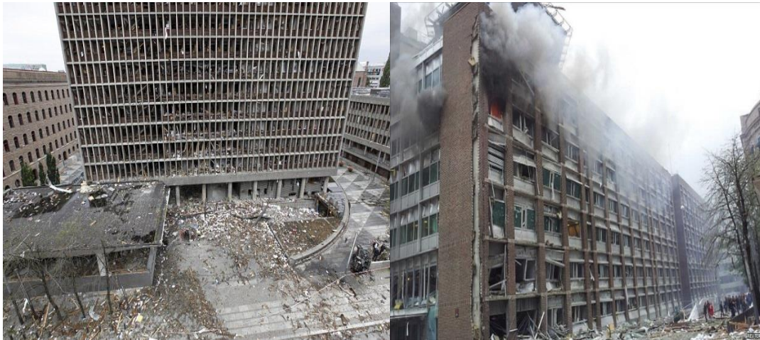
รูปที่ 2-8 สภาพความเสียหายของอาคารที่ตั้งอยู่โดยรอบอาคารที่ทำการรัฐบาล Regjeringskvartalet (ที่มา: https://en.wikipedia.org/wiki/2011_Norway_attacks )
