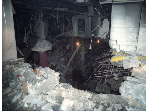
รูปที่ 2-4 ความเสียหายของพื้นที่ชั้นจอร์จไต้ดิน อาคารศูนย์กลางการค้าโลก (ที่มา: https://en.wikipedia.org/wiki/1993_World_Trade_Center_bombing )
