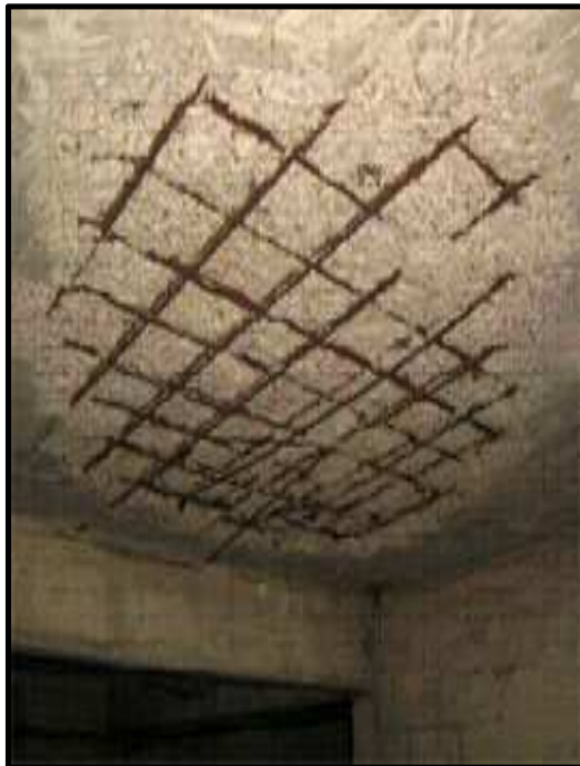
รอยร้าวหรือรอยสนิมเหล็กที่ใต้ท้องพื้นเป็นตาราง
