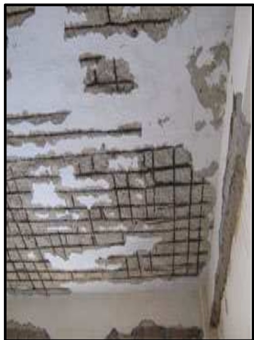
รอยร้าวหรือรอยสนิมเหล็กที่ใต้ท้องพื้นเป็นตาราง
