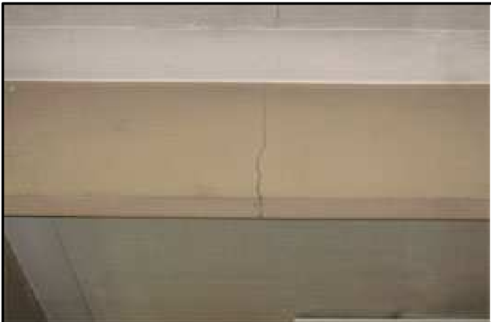
รอยร้าวเนื่องจากแรงดัดที่เกิดจากน้ำหนักบรรทุกทุกเกิน
