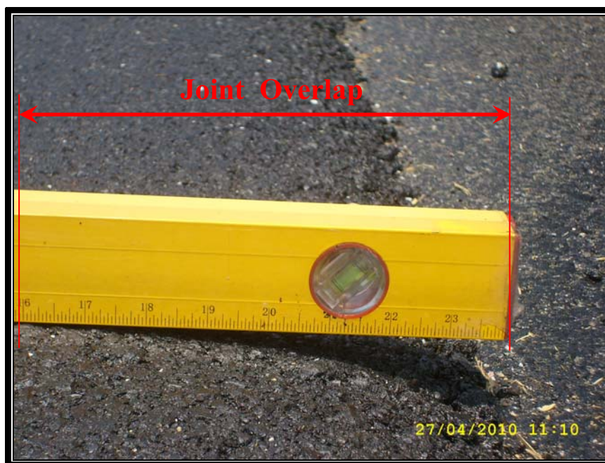
รูปที่ 5 : ตรวจสอบการล้มของรอยต่อ ควรจะมีระยะซ้อนทับ (Overlap) เข้าไปเท่าไร
