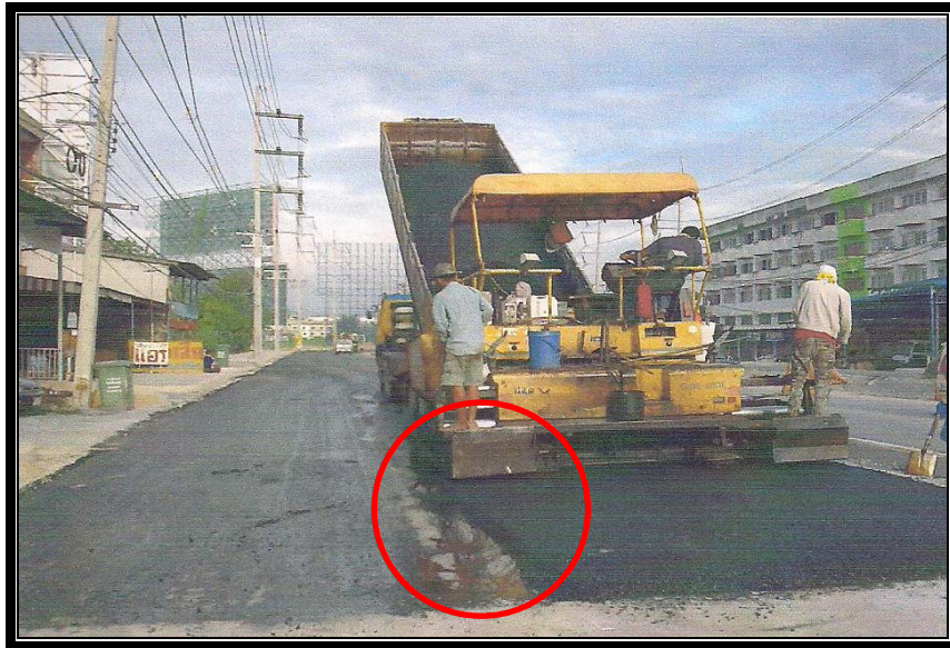
รูปที่ 3 : การจ่ายของแอสฟัลต์คอนกรีต ไม่เต็มส่วนของเตารีด (Screed)
