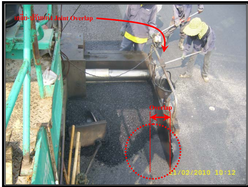
รูปที่ 6 : เกลี่ย-ปรับแต่ง ระยะซ้อนทับรอยต่อ (Joint Overlap)
