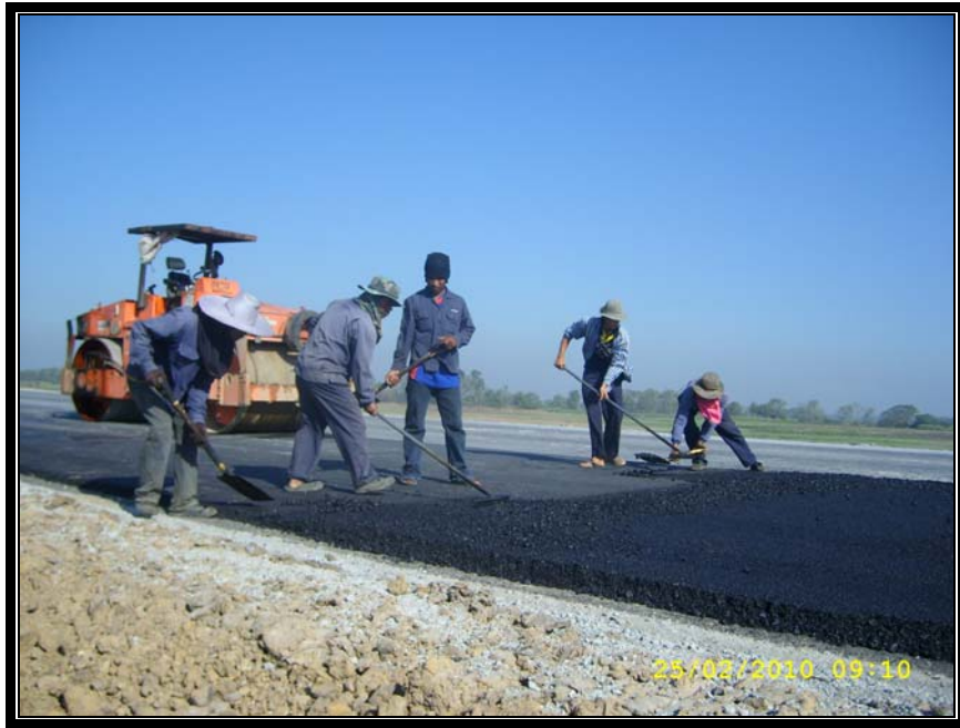
รูปที่ 7 : การเกลี่ย-ปรับแต่ง (ใช้แรงงานฝีมือ)
