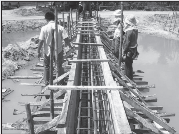
รูปที่ 3-33 การก่อสร้างคานหัวเสารับพื้นสะพาน (Cap Beam)
