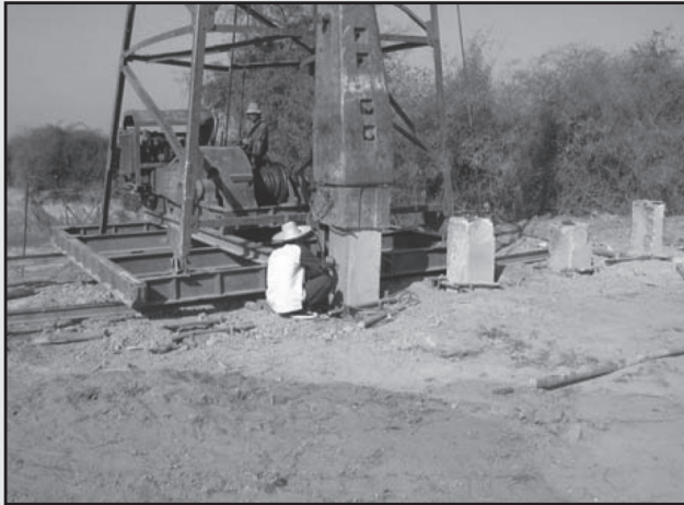
รูปที่ 3-25 การตอกเสาเข็มและการวัดระยะจมนของเสาเข็มเมื่อตอก 10 ครั้งสุดท้าย
