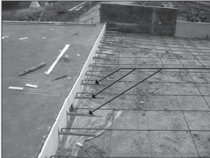
รูปที่ 5-10 การฝังเหล็กยึดรอยต่อตามขวาง (Dowel Bars)
