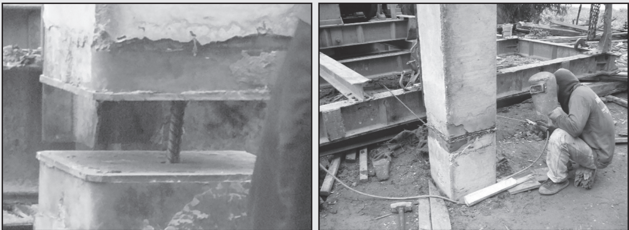
รูปที่ 3-26 แสดงขั้นตอนการเชื่อมต่อเสาคอนกรีต
