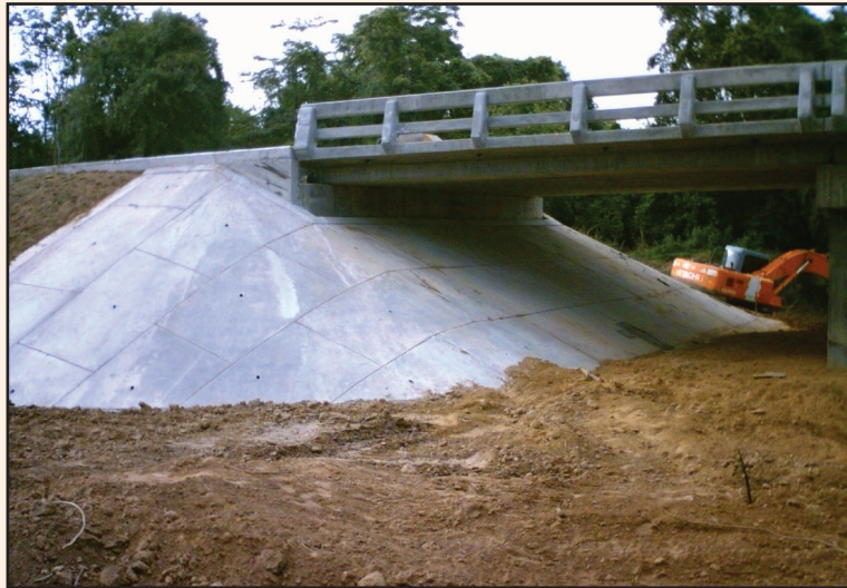
รูปที่ 5-4 งานดาดคอนกรีตที่ก่อสร้างแล้วเสร็จ
