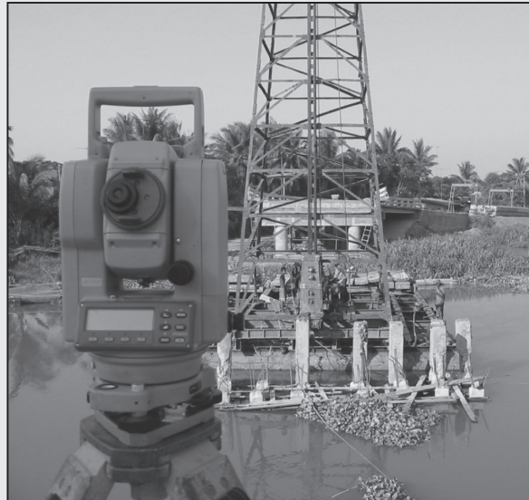
รูปที่ 3-23 การตรวจสอบแนวตั้งของเสาเข็มขณะตอก
