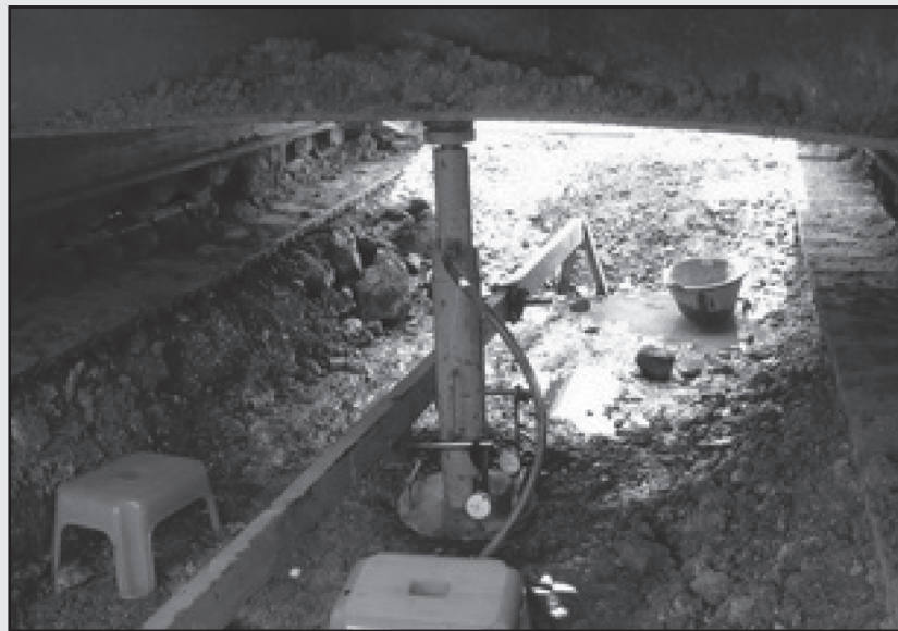
รูปที่ 2-13 การทดสอบกำลังรับน้ำหนักบรรทุกทุกปลอดภัยของดิน โดยวิธี Plate Bearing Test
