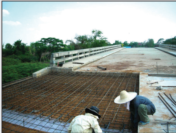
รูปที่ 5-8 เหล็กเสริม Approach Slab (ช่วงแรกที่พาดบนตอม่อ ตับริม) และการปูแผ่นพลาสติกใตร้อยต่อแผ่นพื้นคอนกรีต
