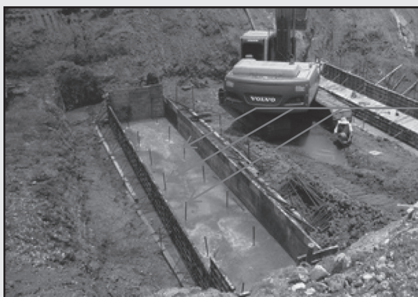
รูปที่ 2-1 แสดงรายละเอียดการฝังเหล็กเดือยของฐานแผ่ในชั้นหินแข็ง
