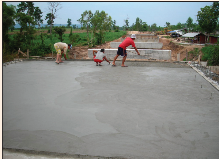
รูปที่ 4-19 การแต่งผิวหน้าคอนกรีตด้วยไม้กวาดลากผิวพื้น
