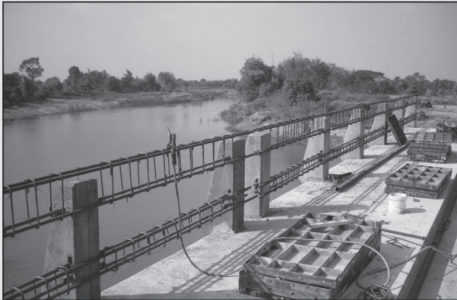
รูปที่ 4-25 การติดตั้งเหล็กเสริมวางสะพานบนเสาราวสะพาน
