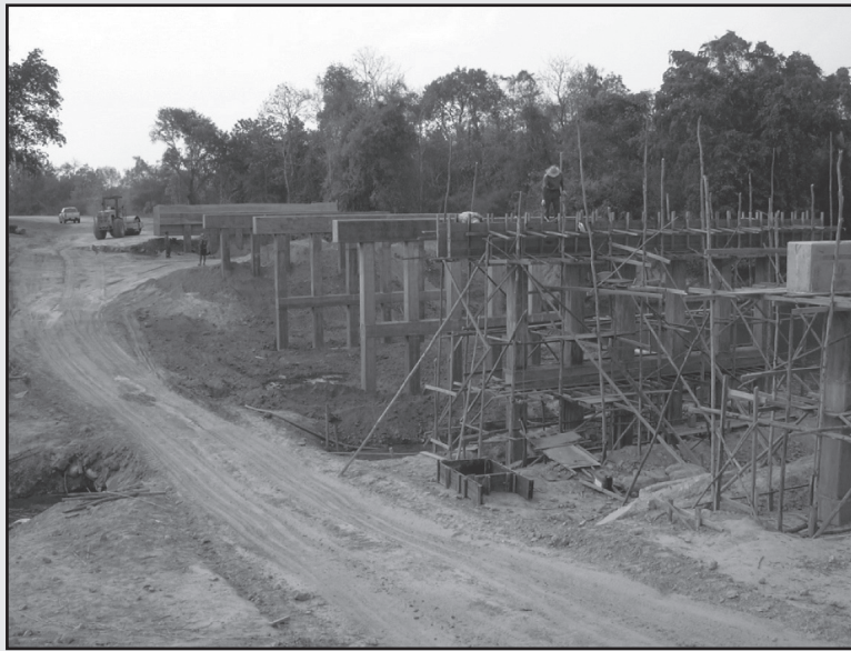
รูปที่ 3-31 การก่อสร้างเสาตอม่อสะพาน
