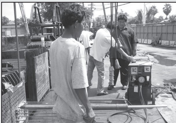
รูปที่ 3-12 การดึงลวดอัดแรง
