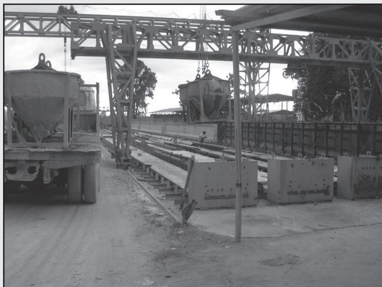
รูปที่ 4-5 ตรวจสอบแท่นรับแรง (Bed)
