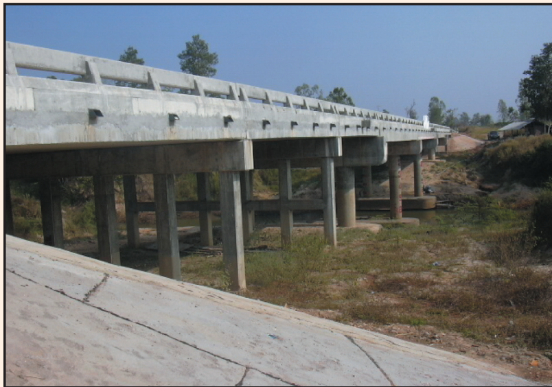
รูปที่ 1-5 สะพานคอนกรีตเสริมเหล็ก
