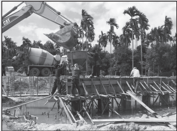
รูปที่ 3-33 การก่อสร้างคานหัวเสารับพื้นสะพาน (Cap Beam)
