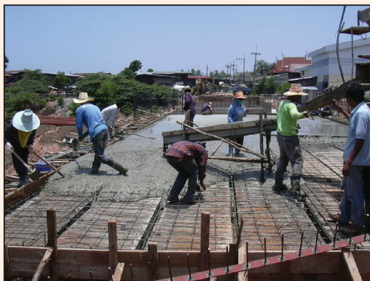
รูปที่ 4-18 การเทคอนกรีตทับหน้าพื้นสะพาน (Concrete Topping)
