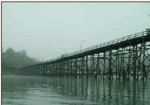
รูปที่ 1-3 สะพานไม้
