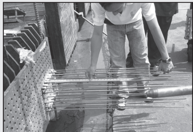
รูปที่ 3-13 ตรวจสอบระยะยืดของลวดอัดแรง
