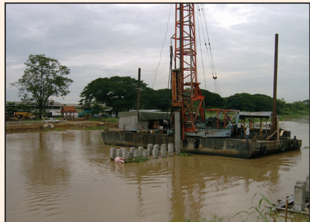
รูปที่ 3-18 การตอกเสาเข็มโดยใช้โป๊ะแทนนั่งร้าน
