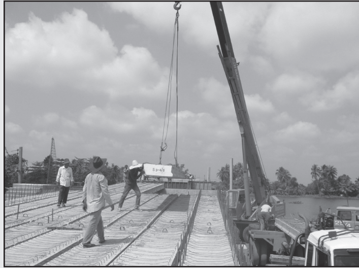
รูปที่ 4-15 การติดตั้งคานคอนกรีตอัดแรงแบบแผ่นพื้น (Plank Girder)
