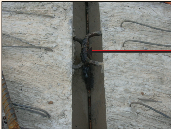
รูปที่ 4-17 การเชื่อมเหล็กรับแรงเฉือน (Shear Connector) ที่ข้างคัน
