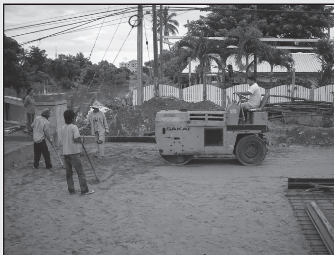
รูปที่ 5-7 การบดอัดทรายรองใต้พื้น Approach Slab
