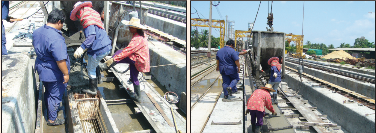
รูปที่ 3-15 การควบคุมการเทคอนกรีตเสาเข็ม
