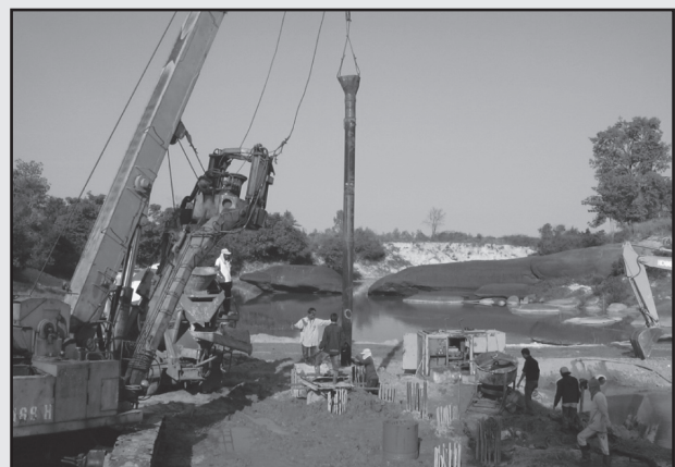
รูปที่ 3-3 การก่อสร้างเสาเข็มเจาะ (Bored Pile)
