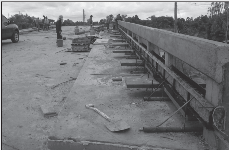
รูปที่ 4-26 การประกอบแบบและเทคอนกรีตวางสะพาน
