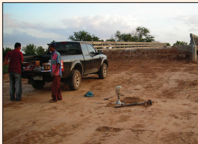
รูปที่ 5-5 การทดสอบความแน่นชั้นโครงสร้างทางที่รองรับ Approach Slab โดยการทำ Sand Cone Test
