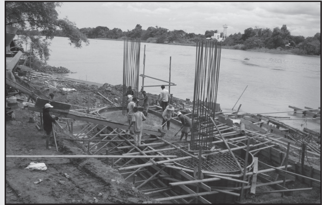
รูปที่ 3-29 คันกันน้ำรอบพื้นที่ก่อสร้างฐานรากสะพานแบบฐานแผ่ (Coffer Dam)
