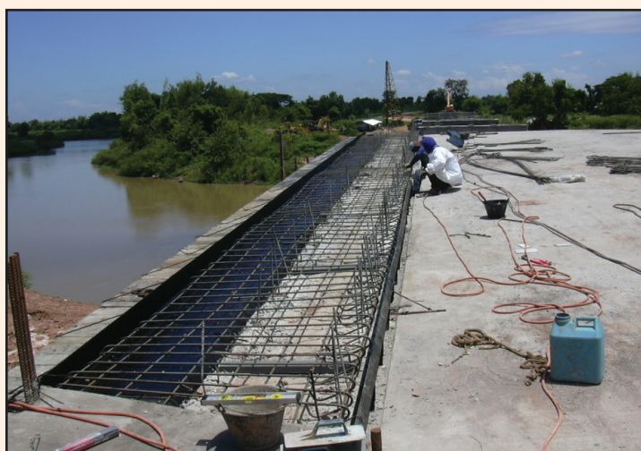
รูปที่ 4-20 การผูกเหล็กเสริมทางเท้าสะพาน
