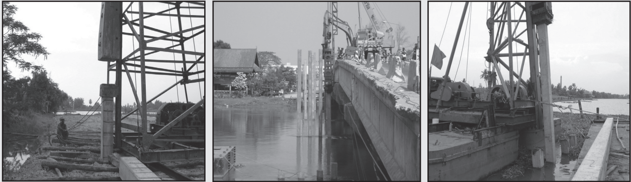
รูปที่ 3-19 ปั่นจั่นตอกเสาเข็ม (แบบโครงเหล็ก แบบรถตอกเคลื่อนที่ และแบบโป๊ะ)
