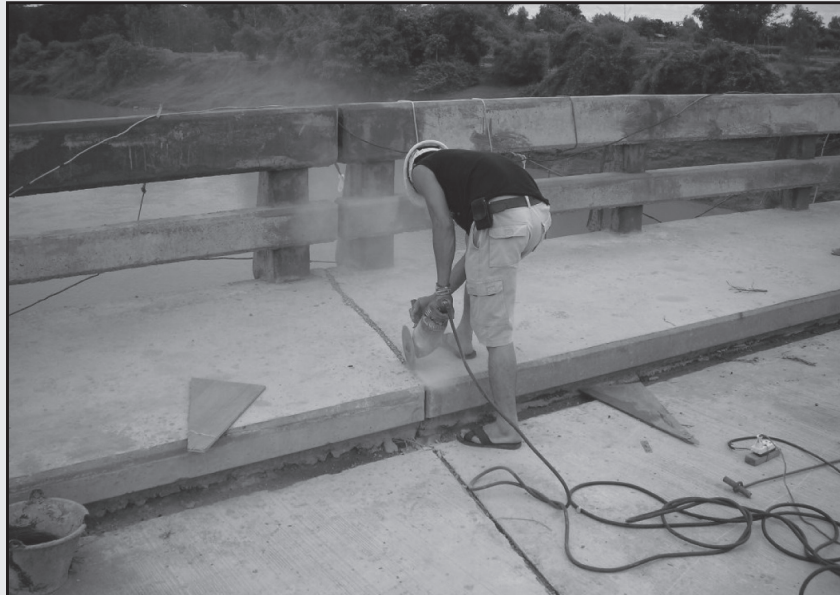
รูปที่ 4-23 การตัดแต่งรอยต่อและเจาะร่องรอยต่อระหว่างพื้นทางเท้าสะพาน
