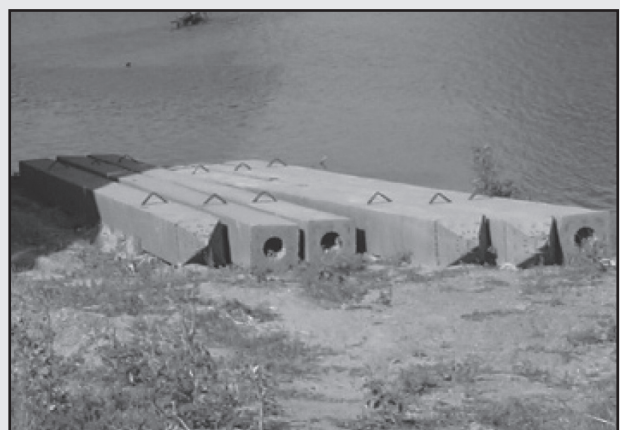
รูปที่ 3-2 เสาเข็มหน้าตัดสี่เหลี่ยมกลวง เสริมเหล็กหล่อปลายหล่อเสาเข็ม
