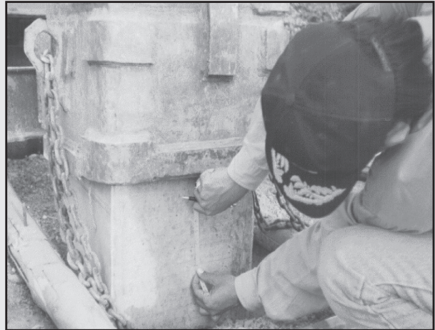
รูปที่ 3-25 การตอกเสาเข็มและการวัดระยะจมนของเสาเข็มเมื่อตอก 10 ครั้งสุดท้าย
