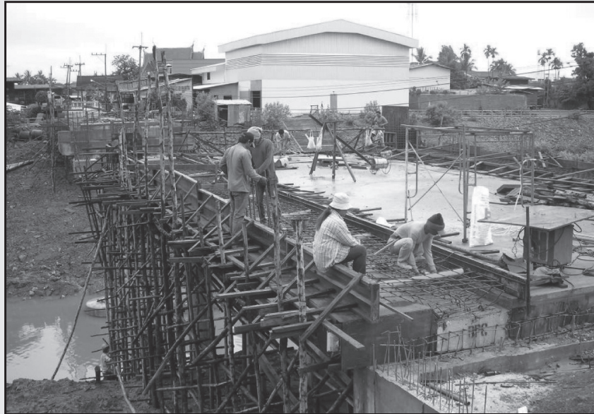
รูปที่ 4-21 การติดตั้งท่อระบายน้ำใต้ทางเท้าสะพาน
