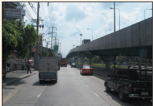
รูปที่ 1-4 สะพานเหล็ก
