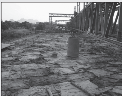
รูปที่ 5-11 การบ่มคอนกรีต (กระสอบคลุม พ่นน้ำยา และคลุมพลาสติก)
