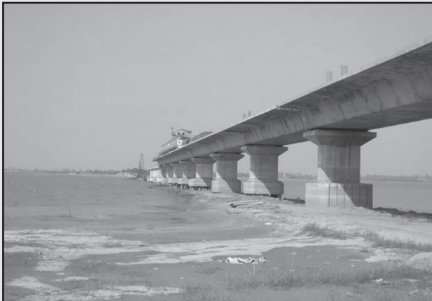
รูปที่ 1-11 คานคอนกรีตรูปกล่องหล่อสำเร็จรูปเป็น ท่อนๆ (Prestress Segmental Box Girder) ก่อสร้างโดยวิธีนำมาประกอบติดตั้งและอัดแรงในที่
