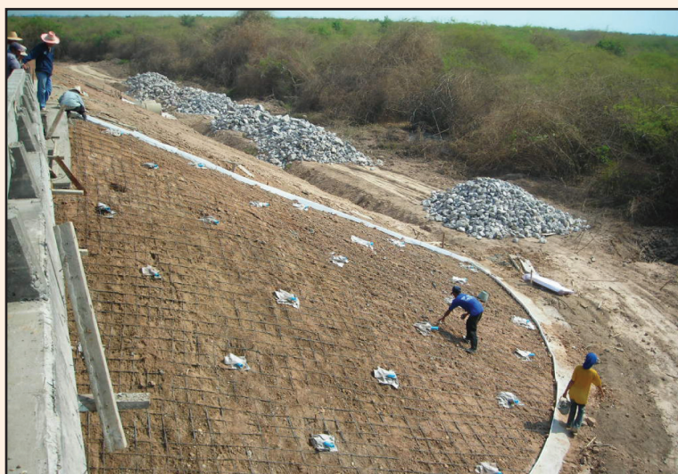
รูปที่ 5-3 งานติดตั้งท่อระบายน้ำและตะแกรงเหล็กเสริมตาดคอนกรีต
