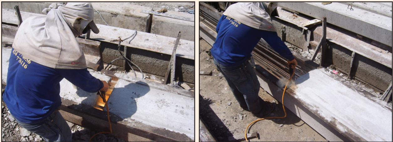
รูปที่ 3-16 การตัดลวดอัดแรงเสาเข็ม
