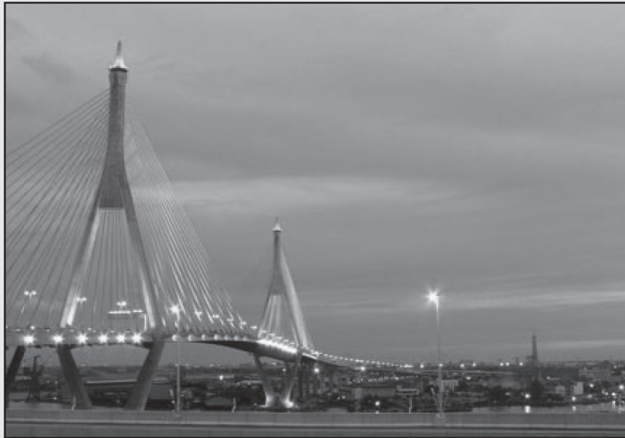
รูปที่ 1-16 สะพานซิง (Cable Stayed Bridge)
