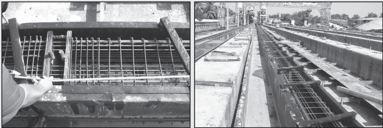
รูปที่ 3-14 ตรวจสอบเหล็กเสริมและระยะหุ้มคอนกรีตก่อนทำการเทคอนกรีตเสาเข็ม
