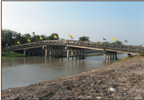
รูปที่ 1-1 สะพานข้ามลำน้ำ
