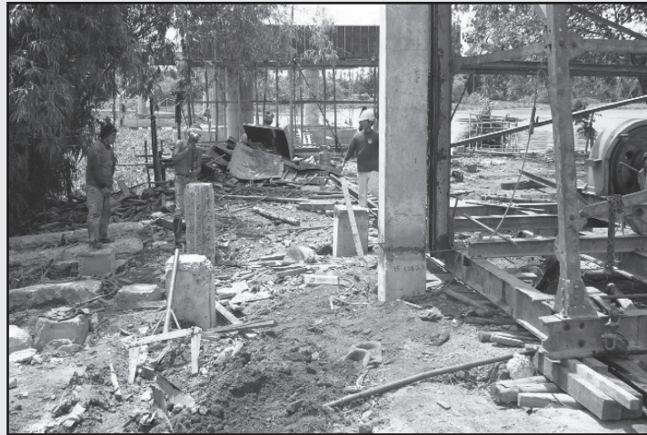
รูปที่ 3-27 แสดงการเชื่อมต่อเสาเข็มแล้วเสร็จ
