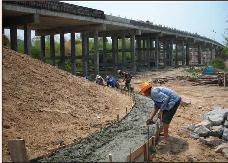
รูปที่ 5-2 งานเทคอนกรีตหล่อคานขอบ (Shear Key)
