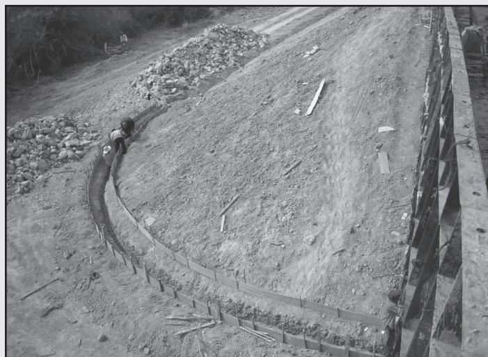
รูปที่ 5-1 งานดินถมรองรับดาดคอนกรีตป้องกันคอสะพาน และการเตรียมพื้นที่ก่อสร้างคานขอบ (Shear Key)
