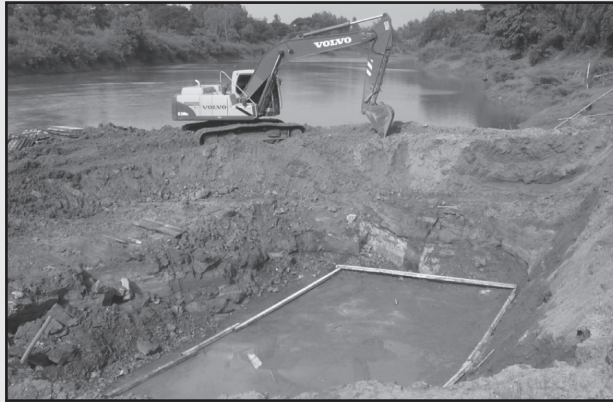
รูปที่ 3-29 คันกันน้ำรอบพื้นที่ก่อสร้างฐานรากสะพานแบบฐานแผ่ (Coffer Dam)
