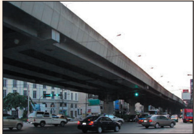
รูปที่ 1-2 สะพานบก
