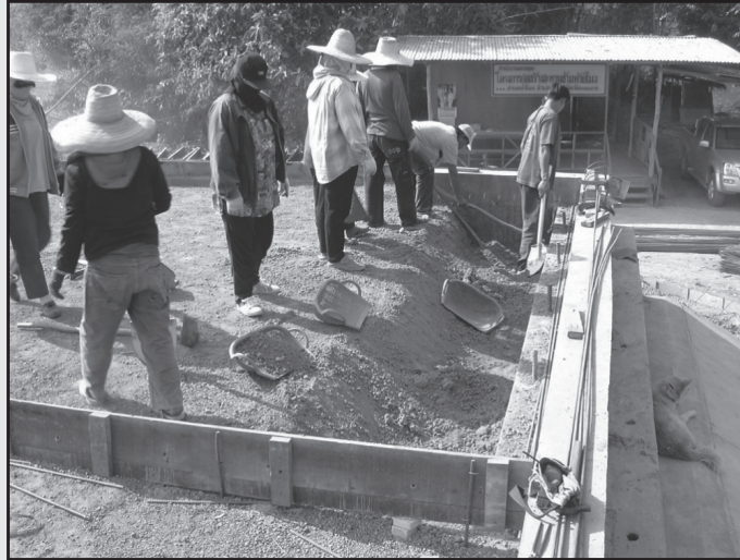
รูปที่ 5-6 การถมทรายชั้นน้ำใต้พื้น Approach Slab
