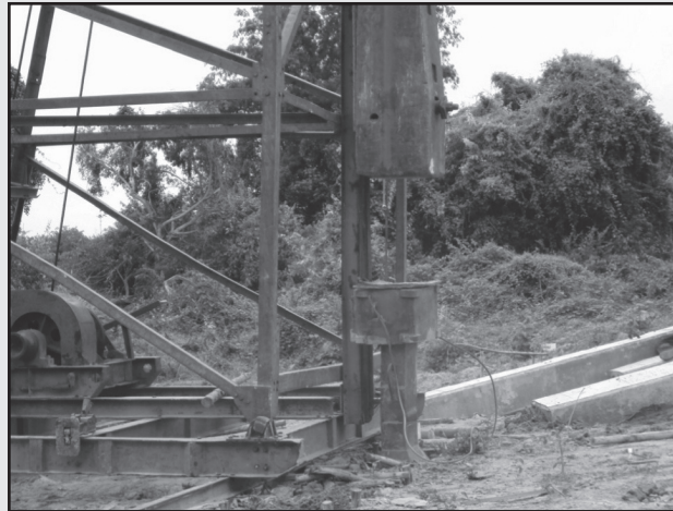
รูปที่ 3-28 การใช้เสาส่งตอกส่งเสาเข็มจนถึงระดับที่ต้องการ
