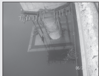
รูปที่ 5-11 การบ่มคอนกรีต (กระสอบคลุม พ่นน้ำยา และคลุมพลาสติก)
