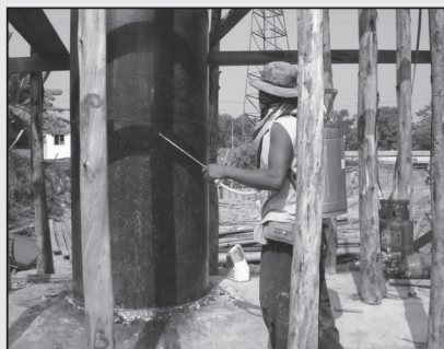
รูปที่ 5-11 การบ่มคอนกรีต (กระสอบคลุม พ่นน้ำยา และคลุมพลาสติก)
