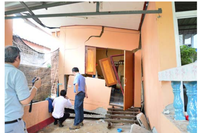
อาคารที่มีสภาพภายในบิดตัว เช่น ผนังบิดตัวไม่ได้แนว พื้น เอียงลาด หรือเสาโก่ง
