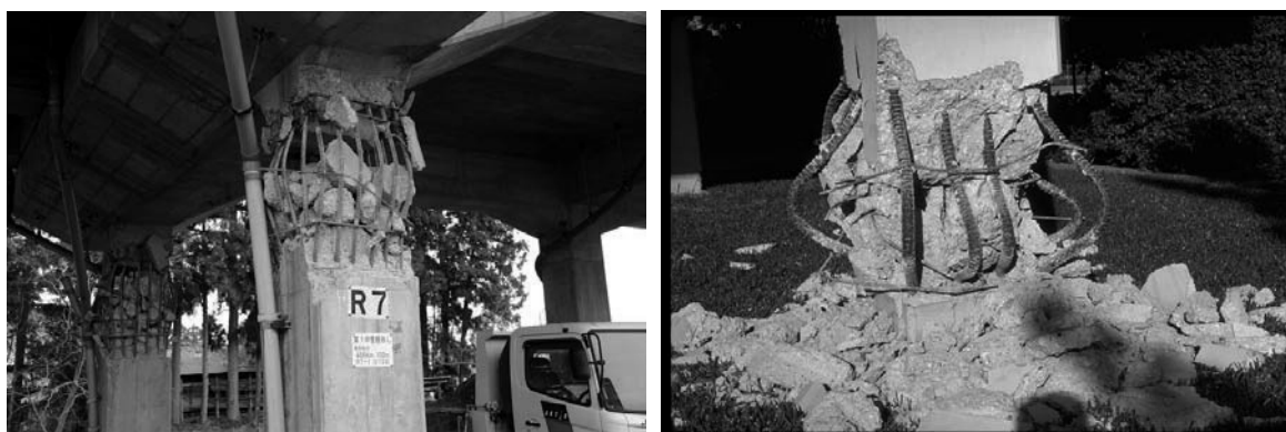
รูปที่ 3.2-2 ตัวอย่างการวิบัติแบบแรงดัดที่ปลายบนและปลายล่างของเสา
