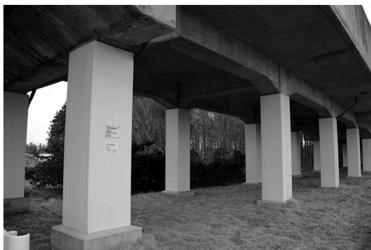
รูปที่ 3.2-4 การหุ้มเสาด้วยแผ่นเหล็ก
