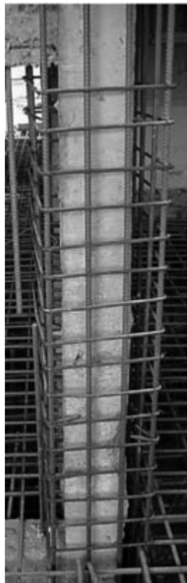
รูปที่ 3.2-3 การหุ้มหน้าตัดด้วยคอนกรีตเสริมเหล็ก
