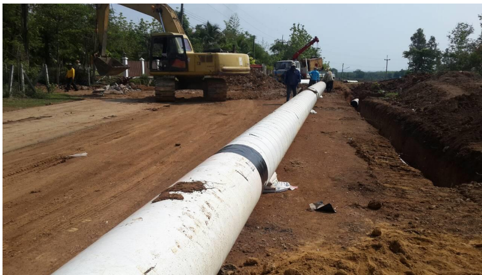
รูปที่ 4.2.1 ท่อส่งน้ำใต้ดิน AWWA C214 (เชื่อมต่อก่อนวางท่อ)
