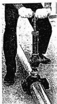
รูปที่ 2.1.3 การเจาะท่อพีวีซี (PVC)
