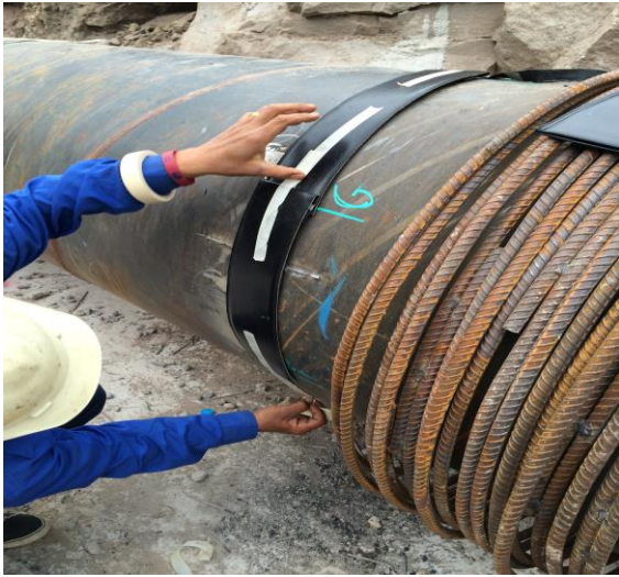
ติดฟิล์มรอบแนวเชื่อมต่อที่ต้องการตรวจสอบ
