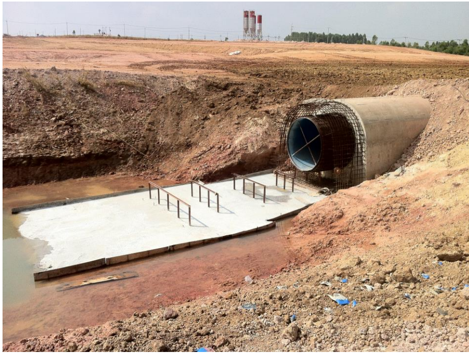
รูปที่ 4.1.2 ท่อส่งน้ำ Steel Liner (หุ้มคอนกรีต)
