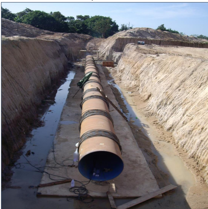
รูปที่ 4.1.1 ท่อส่งน้ำ Steel Liner (เริ่มติดตั้ง)
