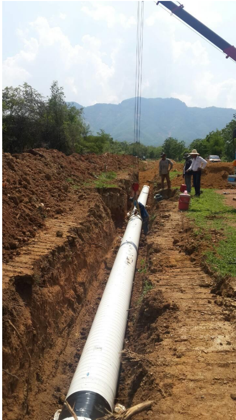
รูปที่ 4.2.2 ท่อส่งน้ำใต้ดิน AWWA C214 (วางท่อเพื่อเชื่อมต่อระหว่างช่วง)
