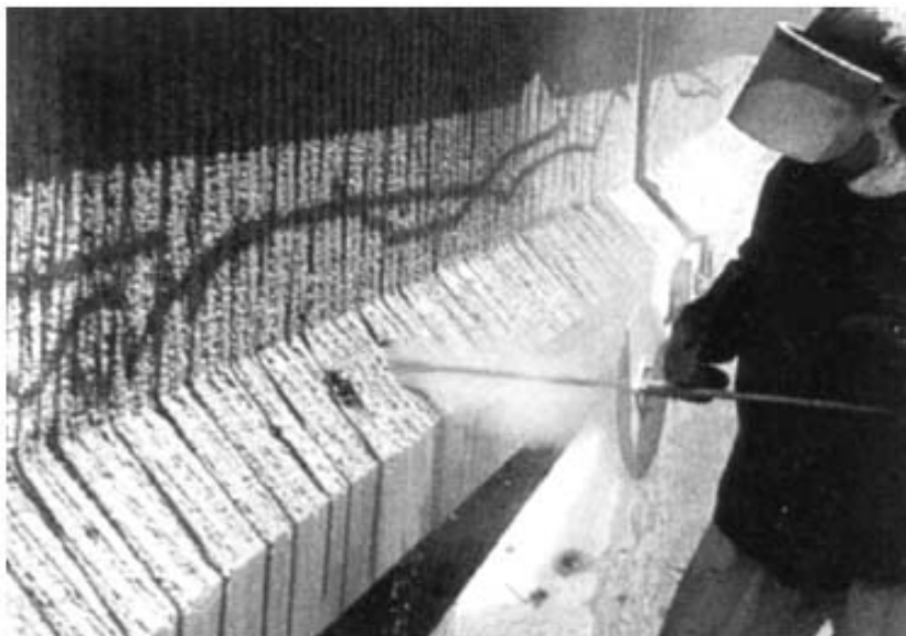
รูปที่ 5 การสกัดโดยวิธีใช้แรงดันน้ำ (ต่อ) (ที่มา: ACI 555) (ข้อ 5.2.2.1)
