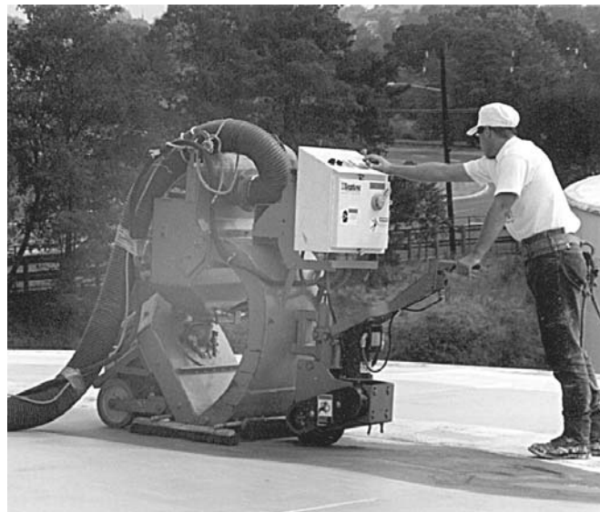
รูปที่ 11 การสกัดด้วยการพ่นอนุภาคโลหะ (Shotblasting) (ที่มา: ICRI 03732) (ข้อ 5.2.2.4)
