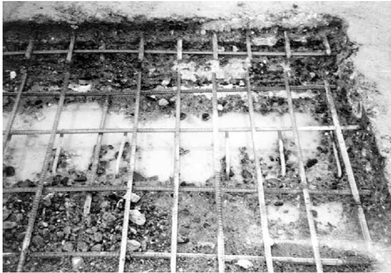
รูปที่ 7 สภาพของคอนกรีตหลังจากการสกัดโดยใช้แรงดันน้ำ (ที่มา: ACI 555) (ข้อ 5.2.2.1)
