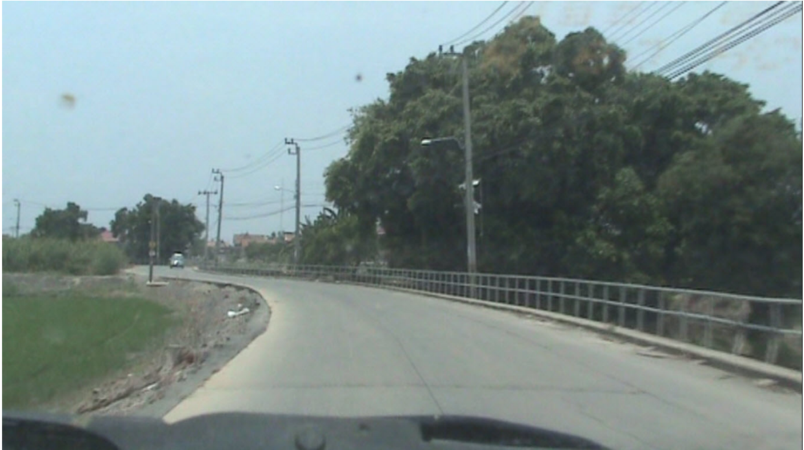
รูปที่ 6 ตัวอย่างการประเมินสายทางช่วง กม. 0+400 – กม. 0+600
