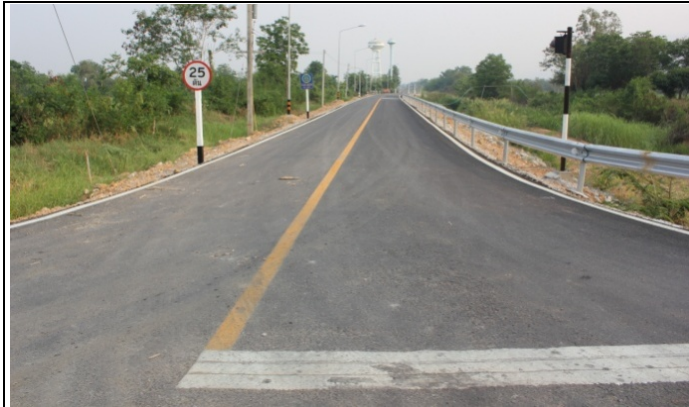
กรณีมีราวกันอันตรายด้านขวามือ เพื่อป้องกันการตกข้างทาง
