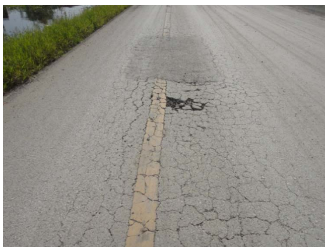
รูปที่ ๑๒ รอยแตกแบบหนังจระเข้
