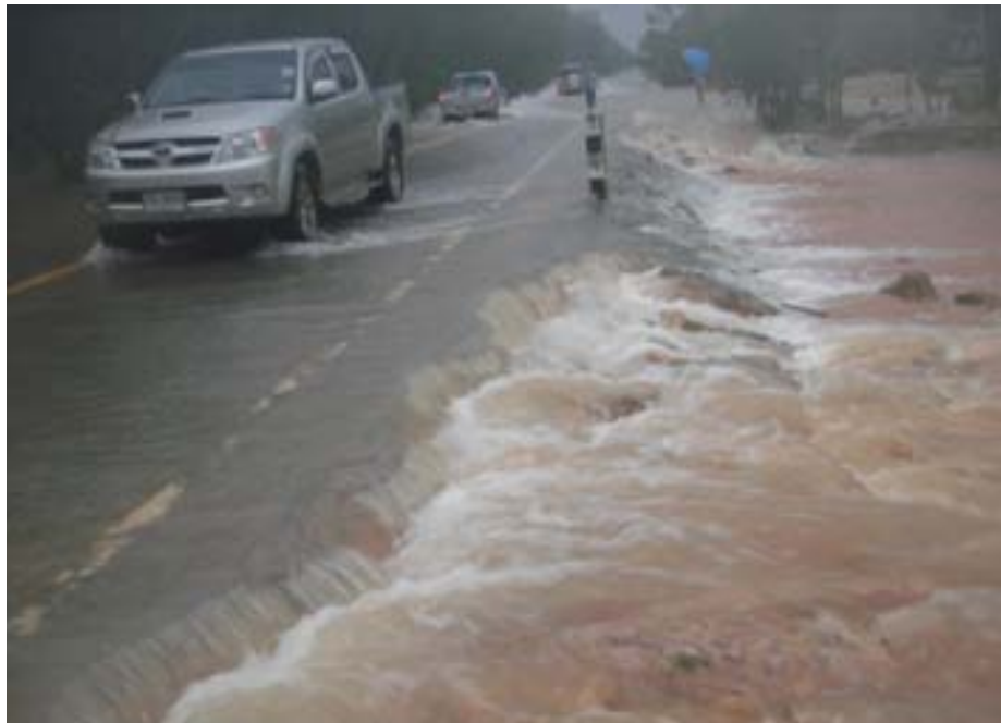
รูปที่ ๑๘ น้ำหลากไหลล้นข้ามคันทางทำให้เกิดการกัดเซาะ
