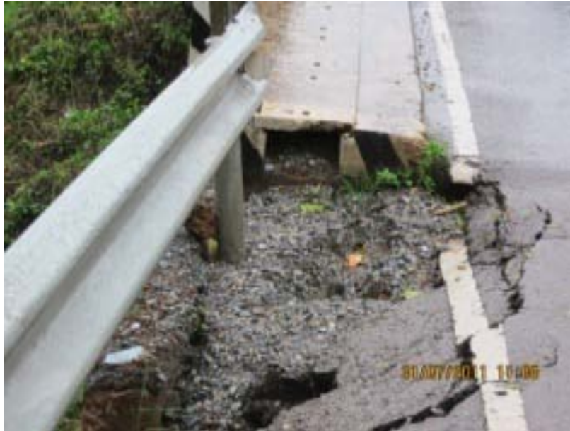
รูปที่ ๘ ฐานราวกันอันตรายถูกกัดเซาะ
