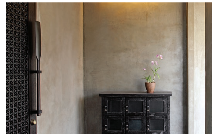
ฉาบปูนแต่งผิวบางสีเทาให้ดูเหมือนผนังปูนเปลือย
