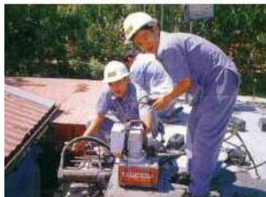
รูปที่ 4.127 ทำการดึงสลิ่งด้วยเครื่องไฮโดร ลิกส์ให้ได้กำลังตามที่กำหนด
