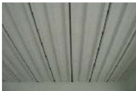
รูปที่ 4.105 หลังจากการวางพื้นสำเร็จรูปแบบสามขาเรียบร้อยแล้ว
