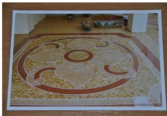
รูปที่ 7.10 การปูหินขัดภายในอาคารแบบตกแต่งลวดลาย
