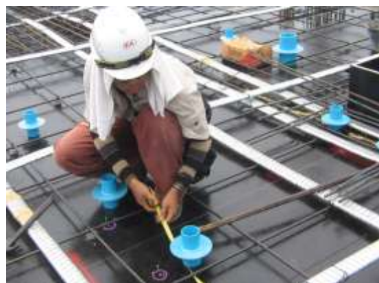
รูปที่ 4.119 การวางสลีปและช่องเปิดต่างๆ
