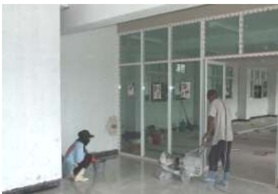
รูปที่ 7.7 การขัดหินด้วยเครื่องขัด
