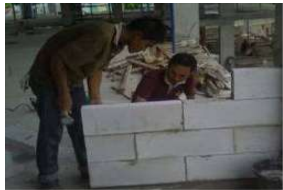
รูปที่ 7.42 การก่ออิฐมวลเบา ซึ่งจะต้องใช้ปูนก่อเฉพาะ
