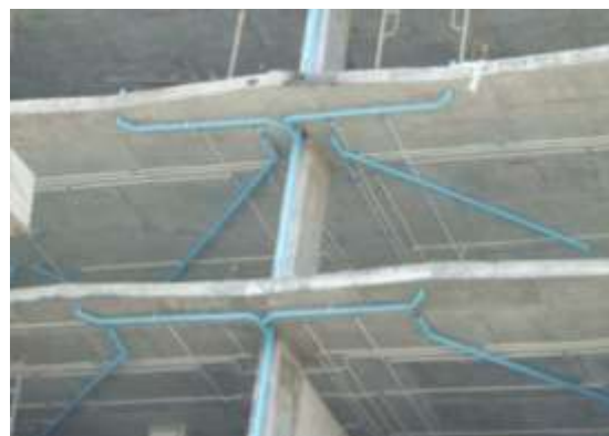
รูปที่ 5.20 ท่อระบายน้ำฝนจากกระเบื้องที่เตรียมจะเชื่อมต่อจากท่อเมน
