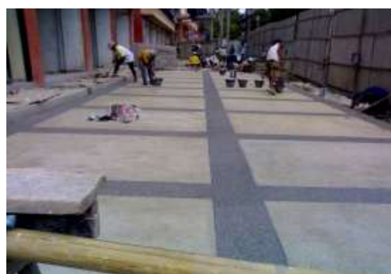
รูปที่ 7.24 การปูบล็อกจัดวางลายสีลานหน้าอาคาร
