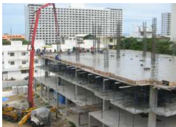
รูปที่ 4.61 การเทคอนกรีตพื้นด้วยระบบปั๊มส่งคอนกรีต (PUMPING CONCRETE) ซึ่งสามารถส่งคอนกรีตไปยังที่เทได้อย่างรวดเร็ว ลดการเสื่อมคุณภาพการก่อตัวของปูนซีเมนต์
