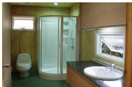
รูปที่ 7.124 การติดตั้งตู้อาบน้ำ กระดาษต้องเป็น กระดาษนิรภัย
