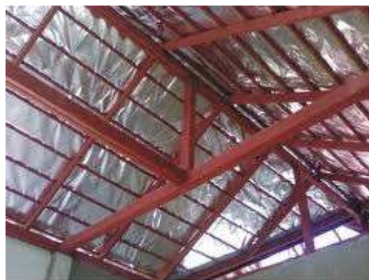
รูปที่ 4.41 โครงหลังคาเหล็กรูปพรรณ รองด้วยโฟมกรุด้วยฟอยกันความร้อน
