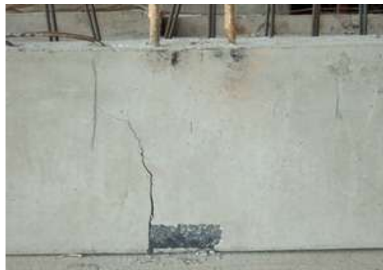
รูปที่ 4.111 คานคอนกรีตสำเร็จรูปที่มีรอยแตกร้าวไม่สามารถใช้งานได้
