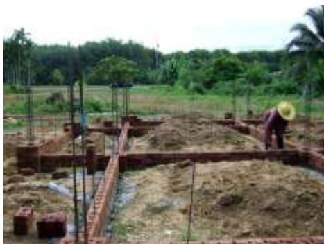
รูปที่ 3.8 แสดงอิฐรับแรงบนฐานรากได้กำแพง
