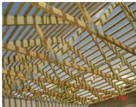
รูปที่ 4.25 แสดงจันทัน แปร ออกไก่ ค้ำยันไม้ ในโครงสร้าง Truss
