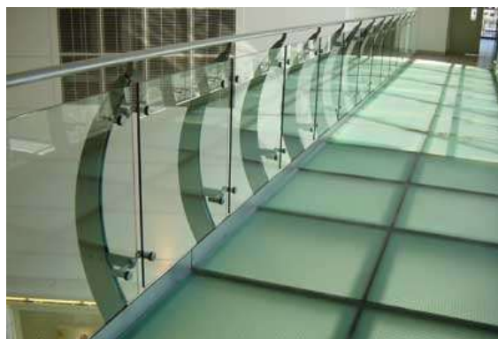
รูปที่ 7.94 การติดตั้งกระจกเป็นผนังกันตก ซึ่งต้องมีความหนาเป็นพิเศษและเป็นกระจกนิรภัย มีการยึดติดอย่างมั่นคง
