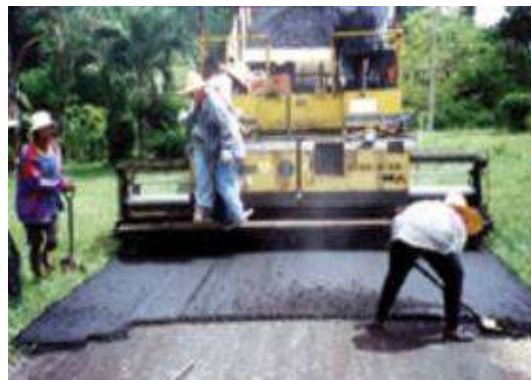
รูปที่ 6.47 การเกลี่ยผิวแอสฟัลต์ด้วย เครื่องจักร
