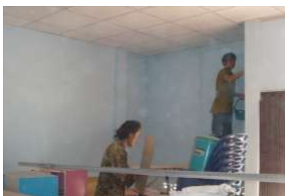
รูปที่ 7.103 การทาสีรองพื้นผนังจะเห็นว่าสียัง ปีดรอยโป้วแต่งผิวพื้นไม่สนิท
