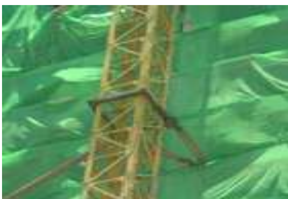
รูปที่ 8.5 สแตนกันฝุ่นและเศษวัสดุที่ลอยออกไปทำความเดือดร้อนแก่บริเวณใกล้เคียงหน่วยงานก่อสร้าง
