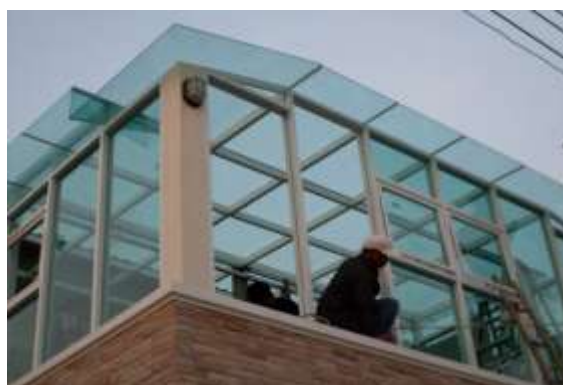
รูปที่ 7.92 การติดตั้งกระจกกรงแสงใช้เป็นหลังคา
