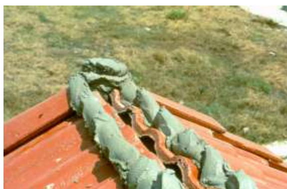
รูปที่ 7.139 การวางปูนทรายเพื่อวางกรอบสันหลังคา
