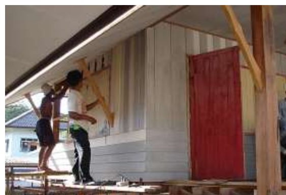
รูปที่ 7.52 การตีฝาด้านล่างเป็นแบบซ้อนเกร็ด ด้านบนเป็นแบบทับแนว ที่ทำเสร็จเรียบร้อยแล้ว
