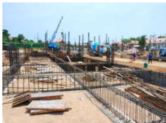
รูปที่ 4.85 การเทคอนกรีตดิน เป็นแบบรอง ท่อน้ำ สำหรับคานท้าวอยู่บนดิน
