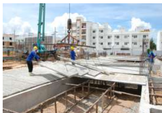
รูปที่ 4.103 การยกพื้นสำเร็จรูปแบบตันเพื่อติดตั้งโดยรถเครน
