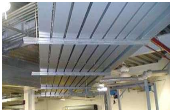
รูปที่ 5.71 การติดตั้งรางเดินสาย (Wireways) ในแนวนอนใต้หลังคาหรือใต้ท้องพื้น
