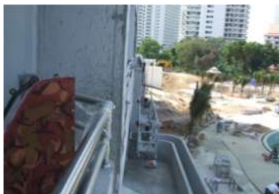
รูปที่ 2.26 นั่งร้านแบบแขน ซึ่งใช้กับอาคารสูงที่ตั้งนั่งร้านไม่สะดวก
