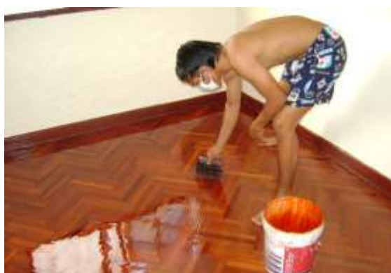
รูปที่ 7.15 การซ่อมสีผิวไม้และเคลือบเงา
