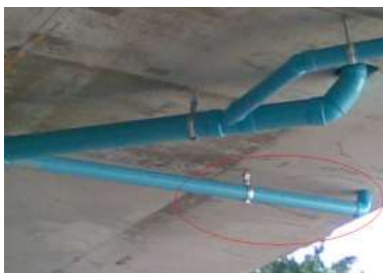
รูปที่ 5.22 การเชื่อมต่อท่อระบายน้ำฝนจากกระเบื้องไปยังท่อเมนก่อนลงท่อระบายน้ำในอาคาร
