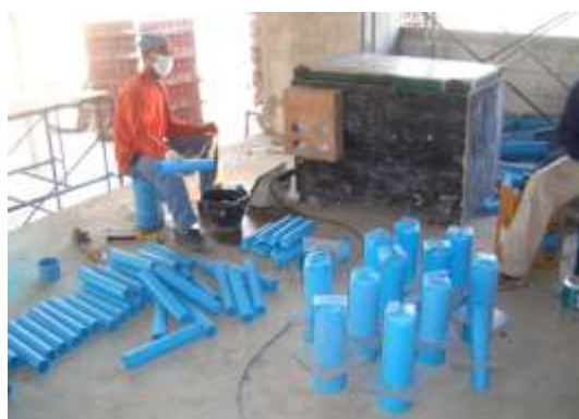
รูปที่ 5.13 การทำหัวอุดท่อเพื่อป้องกันเศษวัสดุและสิ่งสกปรกลงไปในท่อนก่อนการเชื่อมประสาน
