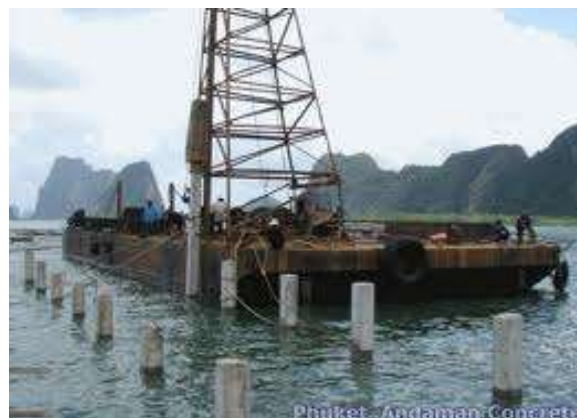
รูปที่ 3.35 แสดงการตอกเสาเข็มโดยปั้นจั่นในน้ำ
