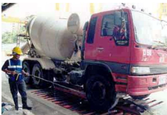
รูปที่ 8.17 ต้องมีการทำความสะอาดล้อยานพาหนะ ก่อนออกจากหน่วยงานเพื่อไม่ให้เกิดความสกปรก ในที่สาธารณะ
