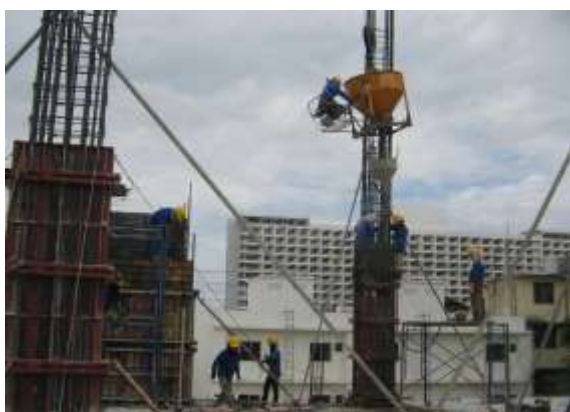
รูปที่ 4.60 การเทคอนกรีตเสาโดยใช้บั๊กเก็ต (BUCKETS) และมีกรวยรับคอนกรีตพร้อมท่อผ้าใบส่งคอนกรีตไปยังแบบหล่อเสาเพื่อลดการกระแทกของคอนกรีตกับเหล็กเสริม
