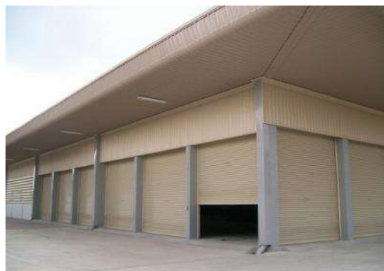
รูปที่ 7.78 ประตูบานม้วน มีประโยชน์ทำให้ ไม่เปลืองเนื้อที่ใส่สอยเวลาเปิด-ปิด
