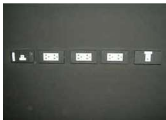
รูปที่ 5.80 การติดตั้งอุปกรณ์ระบบที่ผนัง ยิปซัมฉาบเรียบทาสี
