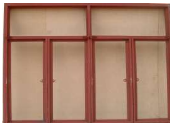
รูปที่ 7.76 หน้าต่างเหล็กพร้อมวงกบจากโรงงานผู้ผลิตจะทาสีกันสนิมมาให้เรียบร้อยแล้ว
