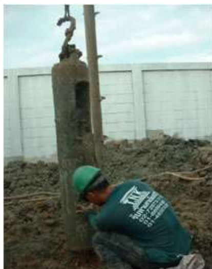
รูปที่ 3.40 แสดงการย้ายเครื่องมือเข้าสู่ตำแหน่งเข็ม
