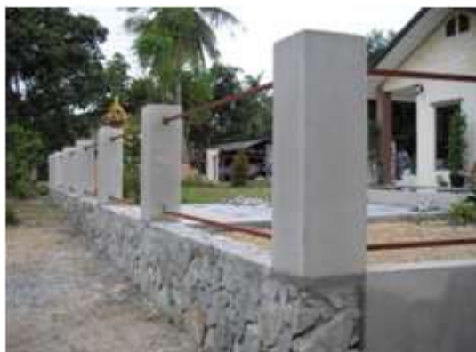
รูปที่ 6.1 เสารั้วที่มีการฉาบหรือตกแต่งและวางโครงสำหรับรับแผงรั้ว
