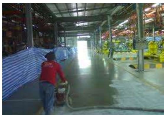
รูปที่ 7.30 การขัดมันผิวฟลอร์ฮาร์ดดินเดอร์
