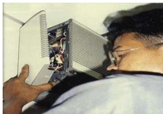
รูปที่ 5.100 ต้องตรวจสอบการต่อไฟฟ้าของระบบแอร์ให้ถูกต้องการใช้งาน
