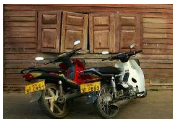
รูปที่ 7.54 ฝาไม้จริง ซึ่งในปัจจุบันไม่เป็นที่นิยมแล้ว เนื่องจากหาไม้ซอมแซมปรับปรุงยากเพราะราคาสูงและยังต้องมีการบำรุงรักษาเพื่อป้องกันแมลงกัดกิน เช่น การทาน้ำมันหรือสีเคลือบผิวหากไม่ทำจะมีสภาพทรุดโทรม
