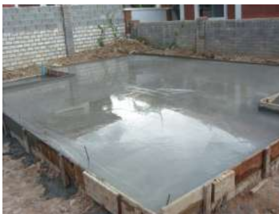
รูปที่ 4.55 พื้นคอนกรีตเสริมเหล็กหลัง เทเสร็จแล้ว ผิวหน้าต้องได้ระดับ
