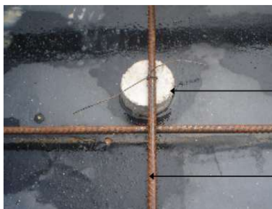
รูปที่ 4.57 การหุ้มลูกปูนก่อนเทคอนกรีต ให้ได้ระยะ Covering ถูกต้องตามแบบ
