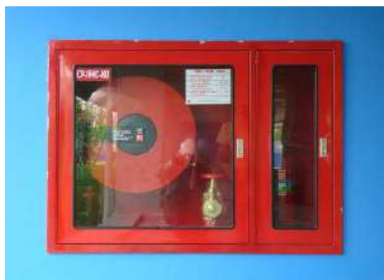
รูปที่ 5.108 การติดตั้งตู้สายฉีดน้ำดับเพลิงต้องตรงตามตำแหน่งและหีบใช้ได้สะดวก
