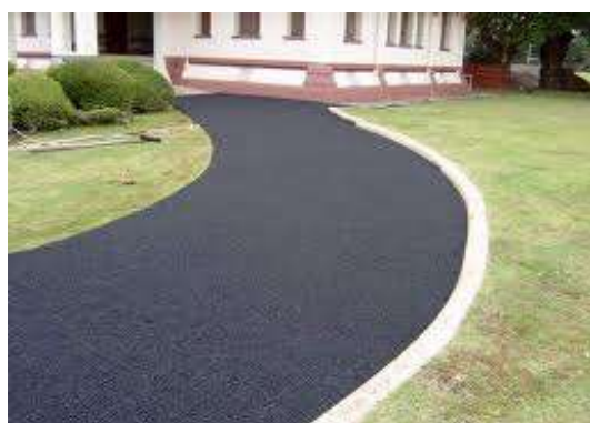
รูปที่ 6.49 หลังจากบดผิวให้เรียบพร้อมส่ง งาน
