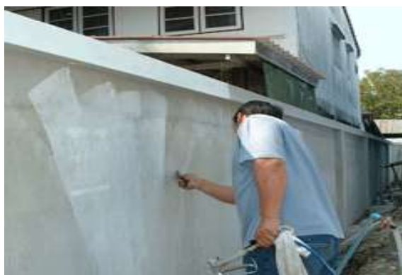
รูปที่ 7.101 ก่อนลงมือทาสีหรือพ่นสีต้องใช้ เกียงโป้วสีชุดแต่งผิวพื้นที่จะทำให้เรียบ
