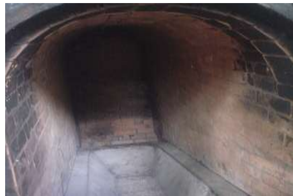
รูปที่ 7.44 การก่ออิฐทนไฟในเมรุเผาศพ
