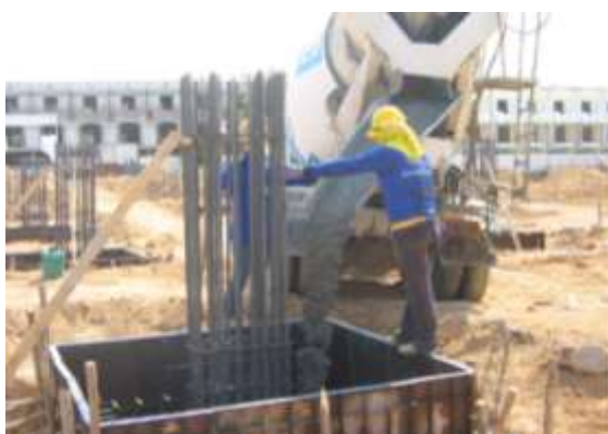
รูปที่ 3.18 แสดงการเทคอนกรีต ก่อนการเทคอนกรีตต้องมั่นใจว่าเสาเข็มยังอยู่ในแนวศูนย์กลาง
