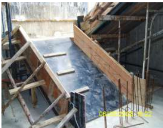
รูปที่ 4.88 การเข้าแบบท้องบันได คสล.
