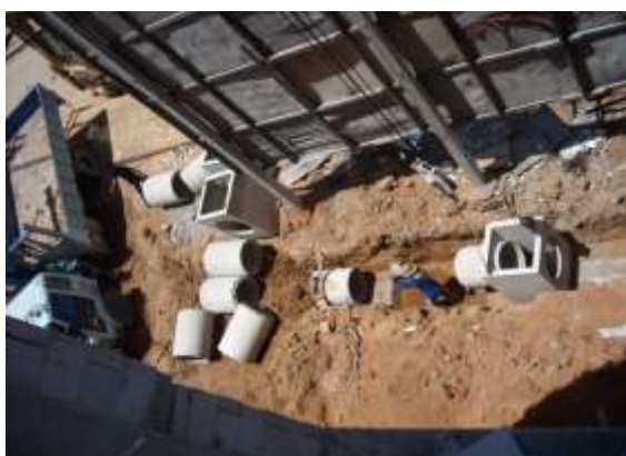
รูปที่ 5.27 การวางท่อและบ่อพักให้ไ้ระดับและถูกตำแหน่งบนคอนกรีตดิน
