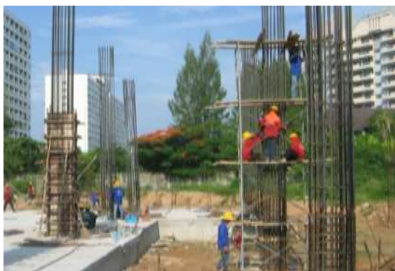
รูปที่ 4.78 การผูกเหล็กปลอกเสาคอนกรีต
