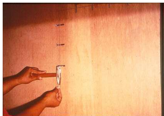
รูปที่ 5.60 การหาแนวสายไฟฟ้าและตีเข็มขัดรัดสายให้ห่างเท่ากันเพื่อความสวยงาม
