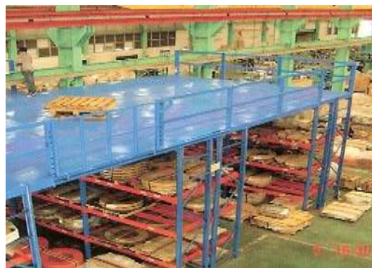
รูปที่ 4.39 พื้นเหล็กตะแกรง ในโรงงาน อุตสาหกรรม
