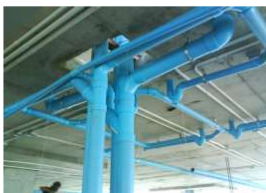
รูปที่ 5.16 ท่อโสโครก ท่อใหญ่จะเป็นท่อจากโถส้วมและโถปัสสาวะ ท่อเล็กจะเป็นท่อน้ำทิ้ง ซึ่งต้องแยกออกจากกันเพื่อป้องกันกลิ่นจากท่อส้วมเข้ามาในระบบน้ำทิ้ง
