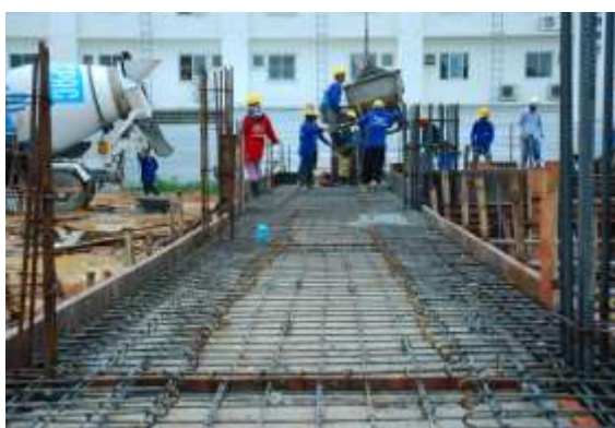
รูปที่ 4.80 การผูกเหล็กเสริมในพื้นคอนกรีต เสริมเหล็ก
