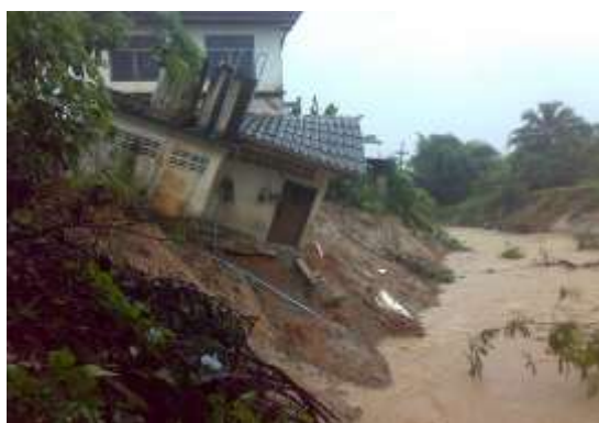
รูปที่ 6.58 การที่ไม่มีเขื่อนกันดินอาจเกิด เหตุการณ์เช่นในภาพนี้
