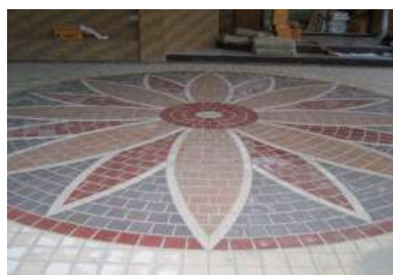
รูปที่ 7.4 การจัดลวดลายปูกระเบื้องที่สลับซับซ้อน ต้องควบคุมและตรวจให้ถูกต้องตาม Shop Drowning ที่ได้รับอนุมัติไว้
