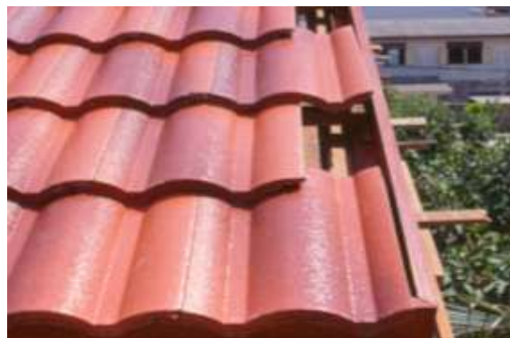
รูปที่ 7.136 การวางวัสดุคลุมหลังคาที่ถูก ต้องวางสลับกันสังเกตได้จากรอยต่อวัสดุคลุมต้องสลับกัน
