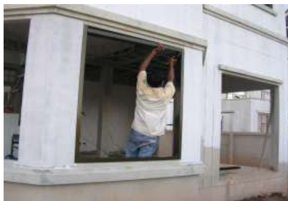
รูปที่ 7.74 การจับขอบปูนสำหรับการติดตั้งวงกบและบานอลูมิเนียม
