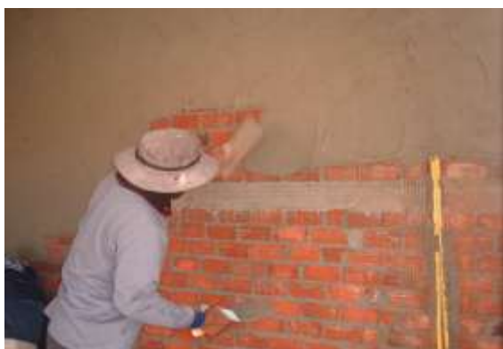
รูปที่ 7.63 การฉาบปูนผนังก่ออิฐมวล
