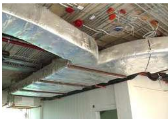
รูปที่ 5.103 การติดตั้งท่อดักแอร์ ในระบบแอร์ขนาดใหญ่ ต้องตรวจสอบการหุ้มฉนวนให้ถูกต้องตามแบบ
