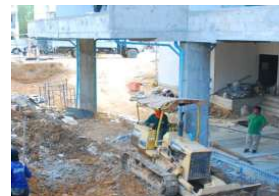
รูปที่ 5.24 ท่อระบายน้ำฝนจากกระเบื้องไหลลงสู่บ่อพักคอนกรีต
