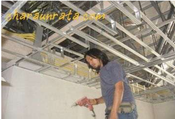
รูปที่ 7.83 การวางโครงคร่าวลูมิเนียมเพื่อติดตั้งฝ้าประเภทบอร์ดซึ่งเป็นวัสดุเบา
