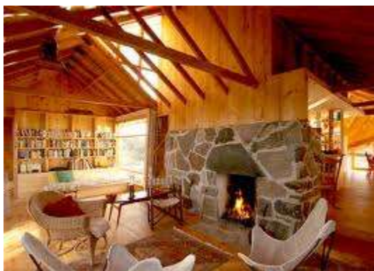
รูปที่ 4.22 การโชว์โครงสร้างหลังคาไม้ เพื่อความสวยงามในอาคาร
