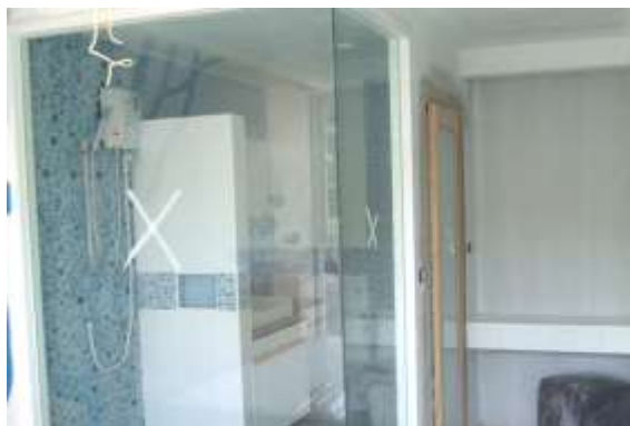
รูปที่ 7.95 การติดตั้งกระจก Laminated กันห้องอาบน้ำซึ่งต้องกันความปลอดภัยหากหกหล่น ก่อนการใช้งานเมื่อติดตั้งเสร็จต้องมีการทำสัญลักษณ์เพื่อป้องกันการกระแทก
