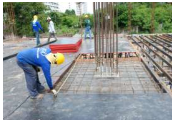
รูปที่ 4.117 การผูกเหล็กเสริม R.C. ในพื้น โปสเทนชั่น
