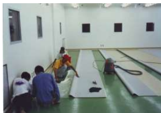
รูปที่ 7.18 การปูพื้นยางแบบแผ่นใหญ่ (Duraflor)
