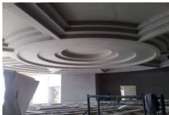
รูปที่ 7.90 การตกแต่งฝ้าเพดานเล่นระดับเป็น ลวดลาย ซับซ้อนหลายชั้น ด้วยวัสดุประเภทบอร์ด ที่สามารถดัดโค้งได้
