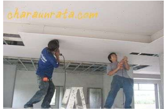
รูปที่ 7.84 การติดตั้งฝ้าแบบไถ่ระดับภายในอาคาร
