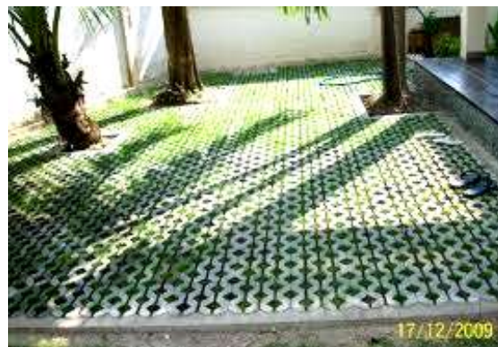
รูปที่ 7.22 บล็อกปลูกหญ้าที่ปูเสร็จเรียบร้อยแล้ว
