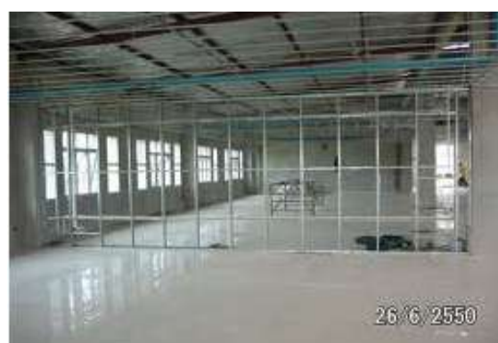
รูปที่ 7.46 การวางโครงเหล็กชีลย สำหรับเป็นโครงยึดผนัง มีการควบคุมและตรวจสอบหลักการเดียวกับโครงไม้
