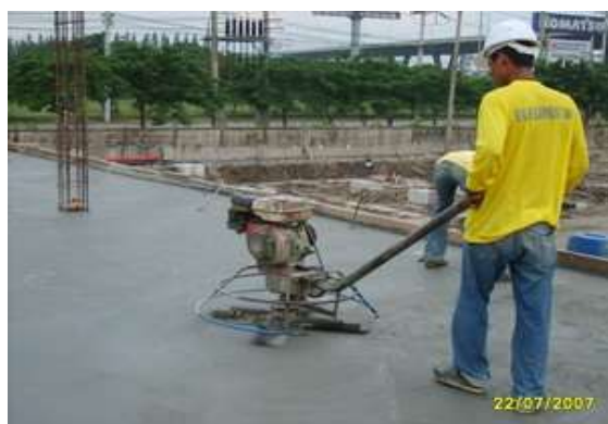
รูปที่ 7.29 หลังจากทิ้งระยะเวลาให้ผิวสามารถ ชัดมันได้ใช้เครื่องขัดมัน โดยเปลี่ยนใบเป็น แบบใบพัด
