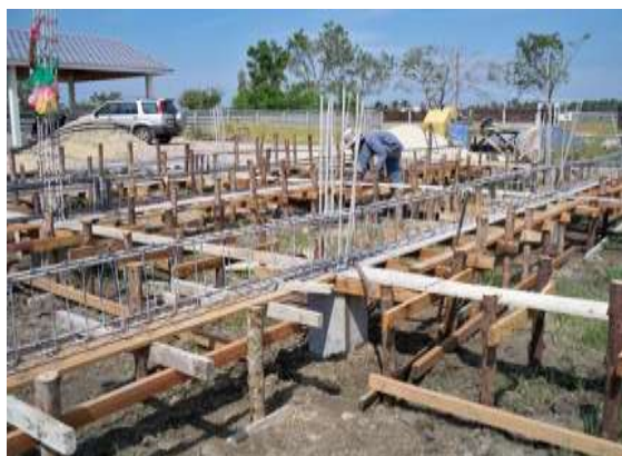
รูปที่ 4.84 การตีแบบท่อน้ำด้วยไม้
