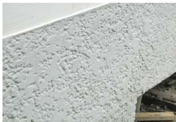
รูปที่ 7.68 การฉาบปูนสลัดดอก
