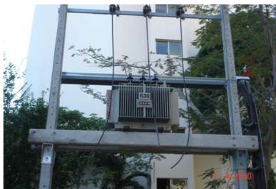
รูปที่ 5.47 หลังจากการติดตั้งหม้อแปลงไฟฟ้าแล้วต้องดูระยะห่างของหม้อแปลงกับรั้วบ้านให้มีระยะห่างที่ปลอดภัย
