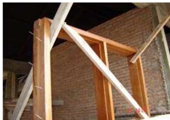
รูปที่ 7.72 การติดตั้งวงกบหน้าต่างยึดไว้ให้มั่นคงก่อนการเทเอ็นคอนกรีตยัดข้างวงกบ
