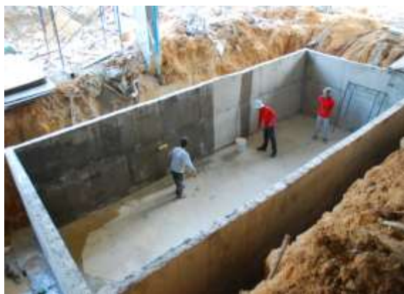
รูปที่ 5.5 ระบบบ่อสำรองน้ำประปา สำหรับใช้ สอยและดับเพลิง ขณะกำลังเคลือบผิวภายใน ซีเมนต์
