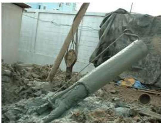
รูปที่ 3.42 แสดงการตักดินออกจากรูเจาะที่จะทำเข็มเจาะ
