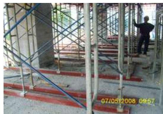
รูปที่ 2.23 การตั้งนั่งร้านหรือค้ำยันจะต้องมี plate รองรับเพื่อให้เกิดความมั่นคง
