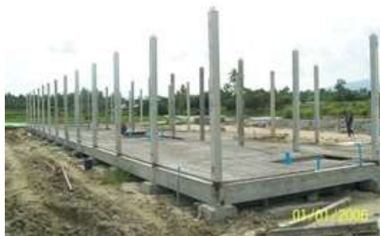
รูปที่ 4.49 ภาพแนวเสาต้องตรงกันตลอดแนวและไม่ลึ้มคิง
