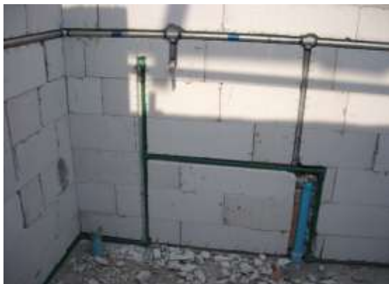
รูปที่ 5.3 การเดินท่อน้ำฝั่งในผนัง ต้องใช้ท่อ ให้ถูกประเภทตามที่ระบุไว้ในแบบ
