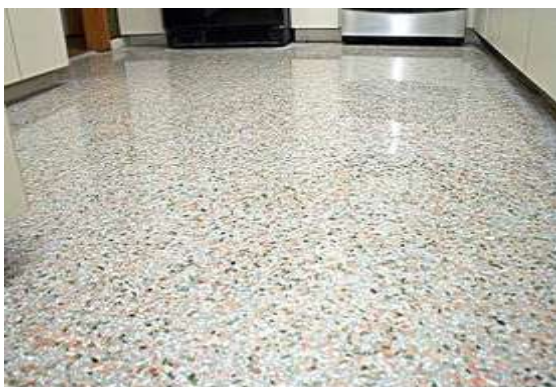
รูปที่ 7.9 การปูหินขัดภายในอาคารแบบลวดลายแบบเดือยตลอดทั้งห้อง
