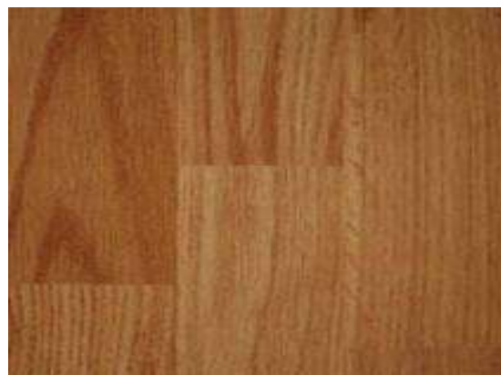
รูปที่ 4.14 พื้นไม้ที่อัดสนิทต้องมีการแต่งโดยใช้กบพิวไลหรือกระดาษทรายขัดบริเวณรอยต่อให้เสมอกัน
