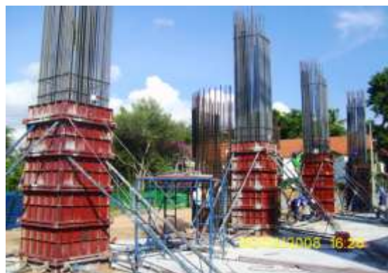
รูปที่ 4.83 การเข้าแบบเสาด้วยแบบเหล็ก
