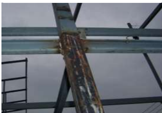
รูปที่ 4.28 ต้องตรวจเช็ครอบเชื่อมให้เต็มและ สีกันสนิมก่อนทาสีจริง
