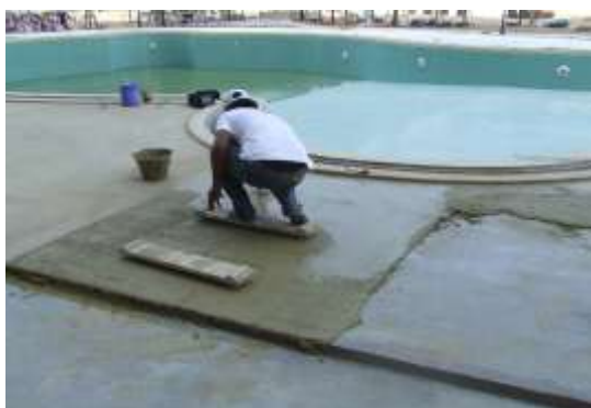
รูปที่ 6.32 การทำทรายล้างตรงลานขอบสระ
