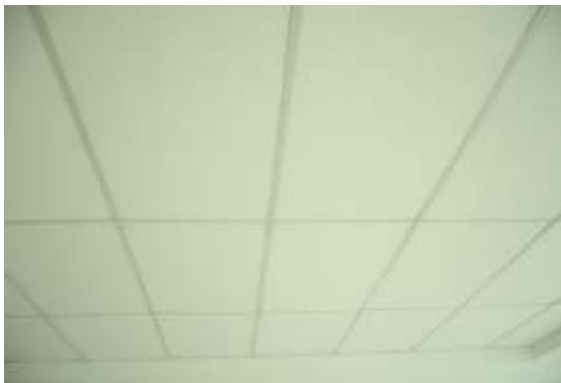
รูปที่ 7.85 การติดตั้งฝ้าแบบทีบาร์
