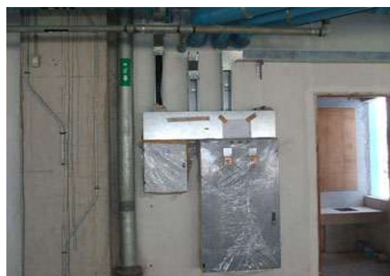
รูปที่ 5.52 แผงเมนบอร์ดควบคุมแต่ละชั้นต้องอยู่บริเวณที่สะดวกต่อการบำรุงรักษา
