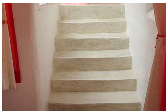
รูปที่ 7.112 บันไดคอนกรีตลูกนอนและลูกตั้งปูกระเบื้อง
