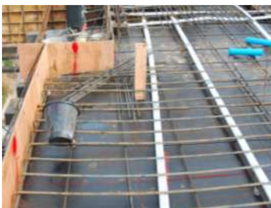
รูปที่ 4.56 แบบเทคอนกรีตต้องมีระดับอ้างอิง (สีแดง) ก่อนเทคอนกรีต
