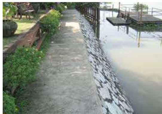
รูปที่ 6.61 เขื่อนคาดด้วยหินทำมุมเอียงเพื่อ ถ่าน้ำหนักของแรงดันดิน
