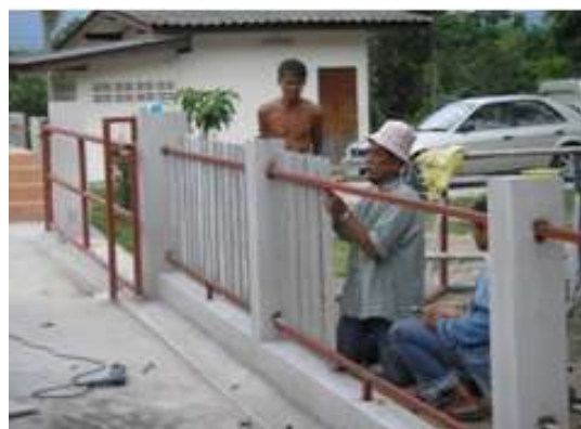
รูปที่ 6.2 แสดงการยึดแผ่นรั้วติดกับโครง ต้องควบคุมให้เว้นระยะห่างเท่ากัน ต้องได้คิงและระดับ
