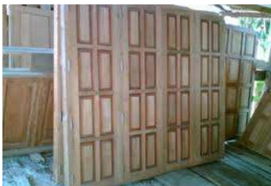
รูปที่ 7.82 บานเฟี้ยมเป็นที่นิยมใช้มานานจนถูก แทนที่ด้วยประตูเหล็กม้วน ปัจจุบันบานเฟี้ยมจะถูก ใช้เป็นฉากกั้นห้องประชุมและวัสดุที่ทำจะมีน้ำหนัก ไม่มาก เช่น อลูมิเนียม
