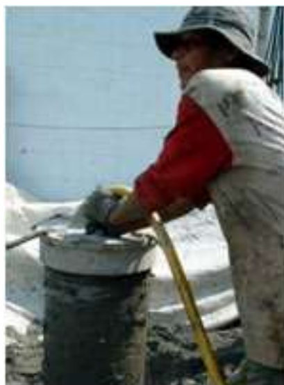
รูปที่ 3.45 แสดงการถอนปลอกเหล็ก
