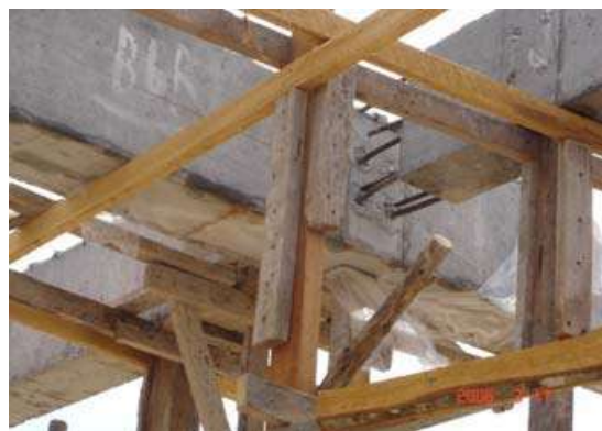
รูปที่ 4.97 การเชื่อมต่อกันสำเร็จรูปที่เป็นคานขอยกับคานสำเร็จรูปที่เป็นคานหลัก
