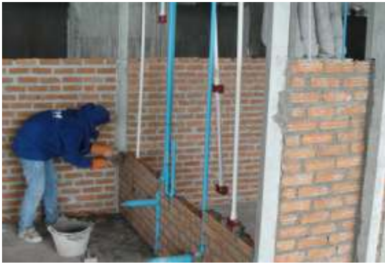
รูปที่ 7.39 การเดินท่อน้ำและก่ออิฐปิดทับท่อน้ำ
