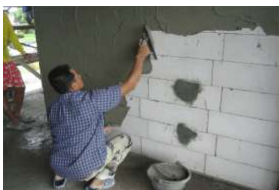
รูปที่ 7.61 การตีปุมสำหรับทำแนวปูน
