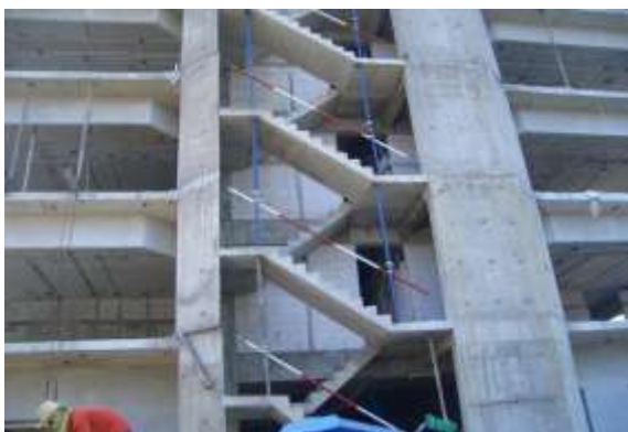
รูปที่ 8.9 ราวกันตกบริเวณบันไดที่ยังไม่ได้ทำ ราวบันไดวางภายนอกอาคาร เพื่อมิให้พนักงานตกลงไป
