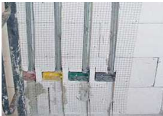
รูปที่ 5.73 การติดตั้งท่อร้อยสายไฟฟ้าแบบ ฝังผนังก่อนฉาบ
