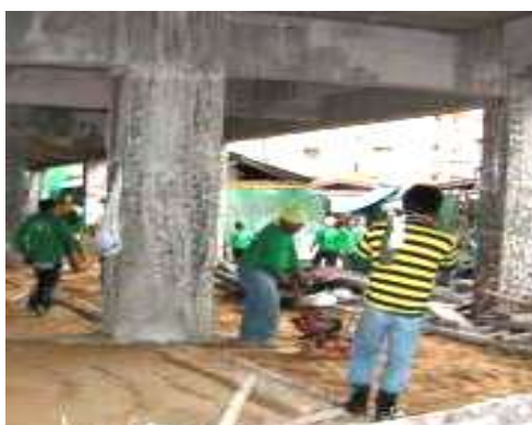
รูปที่ 2.10 การบดอัดดินด้วยเครื่องจักรขนาดเล็ก
