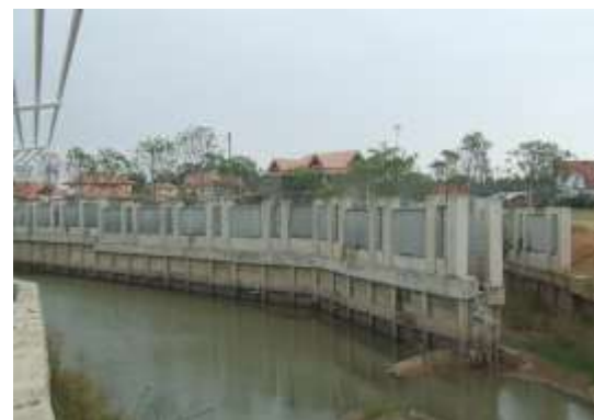
รูปที่ 6.63 เขื่อนกันดินรึมน้ำที่มีรั้วตั้งอยู่บน หลังเขื่อน
