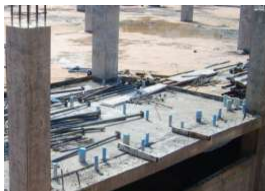
รูปที่ 5.14 แสดงการนำหัวอุดกันสิ่งสกปรกลงไปในท่อไปใช้งาน
