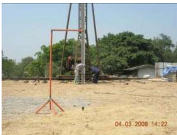
รูปที่ 3.34 แสดงการหาแนวตั้งเสาเข็ม เมื่อ แนวตั้งเสาได้ตั้งแล้วจึงสามารถตอกได้
