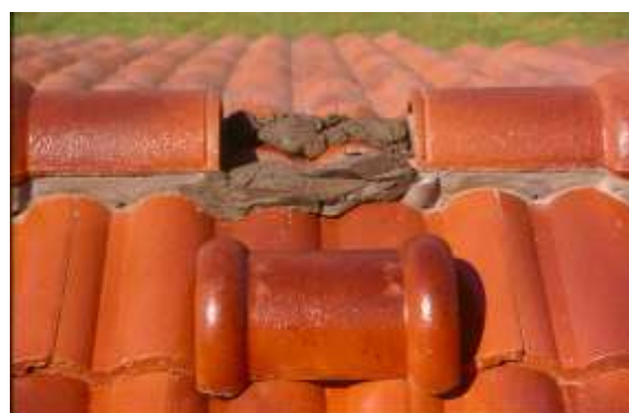
รูปที่ 7.140 การวางกรอบสันหลังคาประเภทสองทาง
