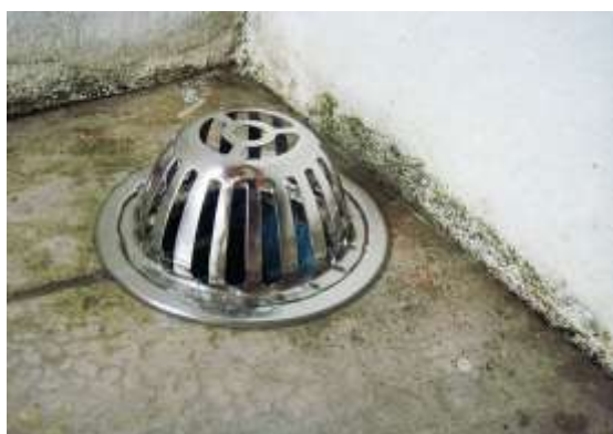
รูปที่ 5.21 การติดตั้งตะแกรงกรองผงท่อระบายน้ำฝนบนชั้นคานาฝ้าหรือบริเวณระเบียง ต้องไล่ระดับน้ำให้ลงท่อไม่ให้มีน้ำขัง
