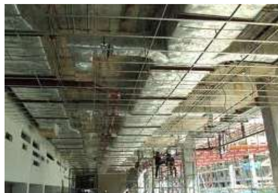
รูปที่ 5.102 การเดินท่อแอร์สำหรับแอร์ขนาดใหญ่ ต้องตรวจเช็คว่ามีรอยรั่วหรือไม่
