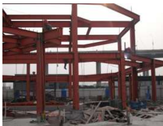
รูปที่ 4.27 แบบโครงเหล็กรูปพรรณ เสา คาน โครงหลังคา
