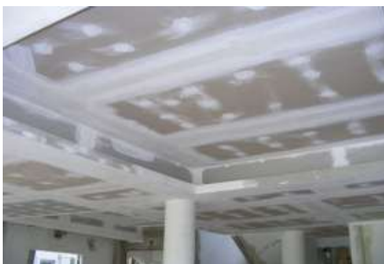
รูปที่ 7.87 การอุดและโป๊เพื่อปิดรอยต่อและรอยขีดข่วน
