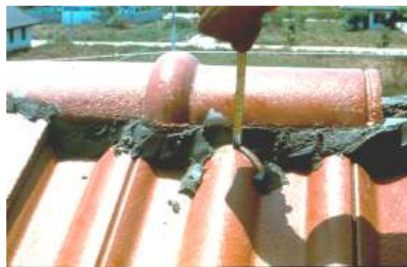
รูปที่ 7.138 ต้องมีการใช้ระดับหังกรอบสันหลังคาต้องได้ระดับเท่ากันทุกอัน
