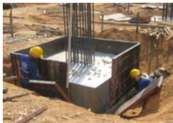
รูปที่ 3.19 แสดงการแกะแบบหล่อคอนกรีตฐานรากและตรวจสอบคอนกรีตว่ามีโพรงอากาศหรือไม่ถ้ามีโพรงอากาศต้องรีบแก้ไข
