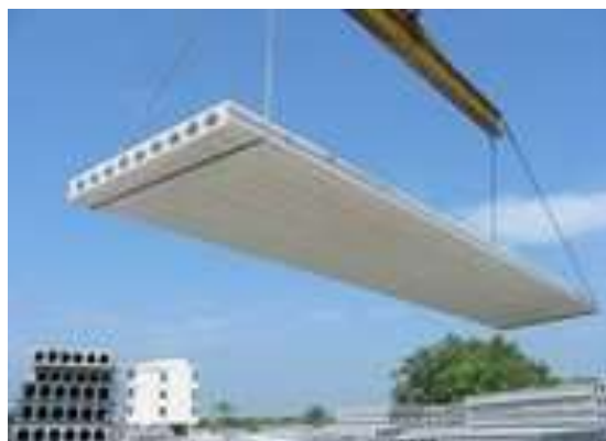
รูปที่ 4.107 การยกพื้นสำเร็จแบบกลวงเพื่อติดตั้ง
