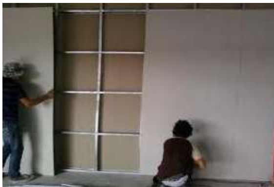
รูปที่ 7.47 การติดตั้งผนังวัสดุบอร์ดที่ใช้ทำผนังยึดติดกับโครงซี่ลาย
