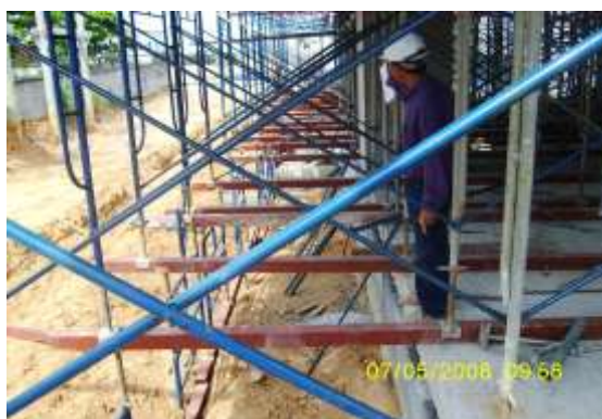
รูปที่ 2.22 รูปแสดงการตั้งค้ำยันรองรับแบบทอพื้น
