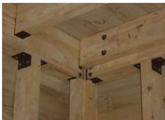
รูปที่ 4.17 แสดงโครงสร้าง เสา คาน ตงไม้ โดยใช้เหล็กฉากเป็นตัวยึดและรับกำลัง
