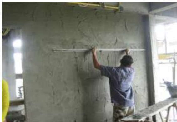
รูปที่ 7.65 การเดินเกลียงบรรทัดปรับผิวไม้ให้เป็นลูกคลื่น
