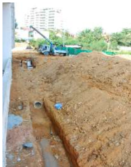
รูปที่ 5.26 การเทคอนกรีตดินให้ไ้ระดับเพื่อรองรับท้องท่อและบ่อพัก
