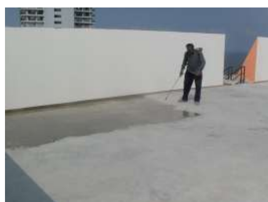
รูปที่ 4.67 การใช้น้ำยาพ่นเคลือบผิวหน้าเพื่อ กันความชื้นระเหยตัวเป็นการบ่มคอนกรีต อีกวิธีหนึ่ง
