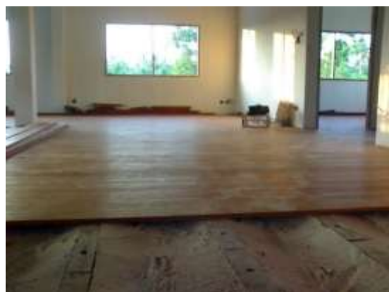
รูปที่ 4.16 การปูพื้นไม้บนตงที่ยึดกับพื้นคอนกรีต
