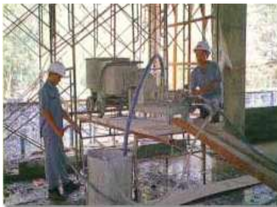
รูปที่ 4.128 Grouting ด้วยน้ำปูนระบบ Bonded System เข้าไปในท่อร้อยสลิ่ง
