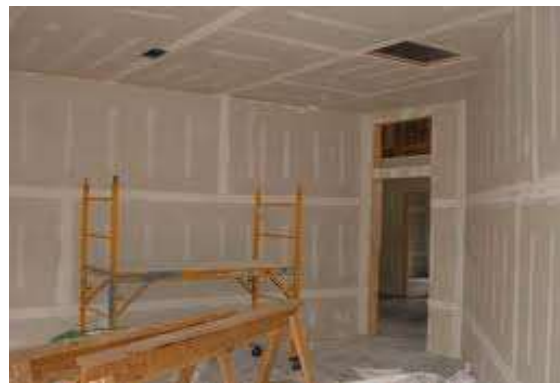
รูปที่ 7.48 การตกแต่งรอยต่อและรอยตำหนิหรือรอยขีดข่วนของแผ่นบอร์ดที่นำมาทำผนัง
