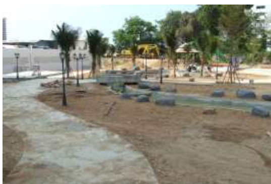
รูปที่ 6.28 การทำทางเดินรอบสวน จัดตำแหน่งหินเทียมข้างลำธารและปลูกต้นไม้ยืนต้นที่ระบุไว้ในแบบ
