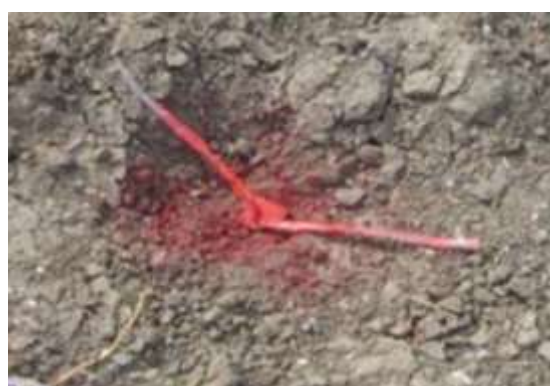
รูปที่ 2.17 แสดงมุมเขตที่ดินที่จะทำการ ก่อสร้าง จะต้องให้เห็นได้ชัดเจนโดยใช้สี พ่นไว้ บนมุมเขตที่ดิน
