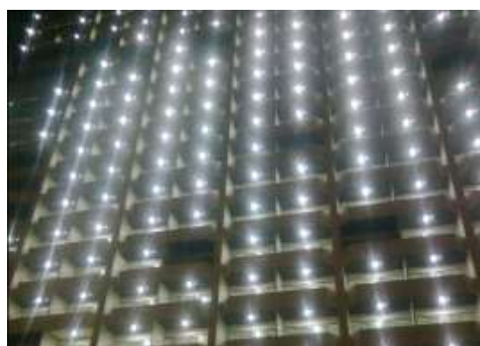
รูปที่ 5.86 เปิดไฟฟ้าแสงสว่างในอาคารทุกดวงจะพบจุดบกพร่องที่ไฟฟ้าไม่ติด
