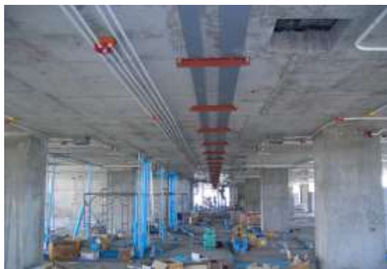
รูปที่ 5.69 รางและท่อร้อยสายไฟ
