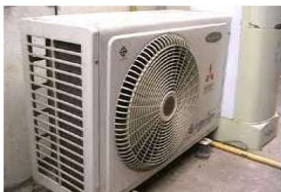
รูปที่ 5.101 คอมเพรสเซอร์แอร์ต้องติดตั้งในบริเวณที่มีอากาศถ่ายเทสะดวก
