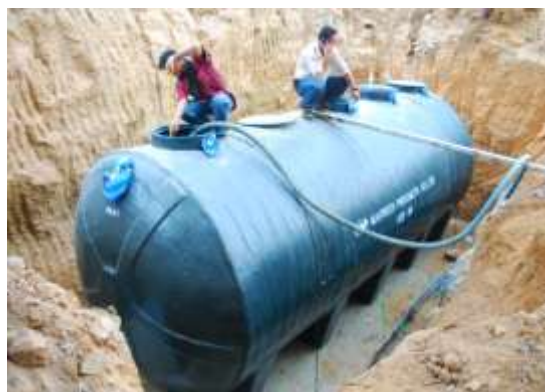
รูปที่ 5.18 การวางถังบำบัดบนคอนกรีตดินก่อนเชื่อมต่อท่อน้ำไฮดรอลิกเข้าถังบำบัดและส่งออกไปยังท่อบำบัดรวมของท้องถิ่น
