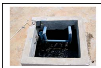
รูปที่ 47 สวิทช์ลากลอยในถังน้ำใส
