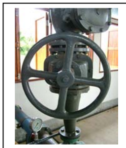
รูปที่ 79 ปิดประตูน้ำท่อทางส่งของเครื่องสูบน้ำดี
