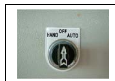
รูปที่ 29 สวิตช์ลูกศรที่ตำแหน่ง “OFF”
