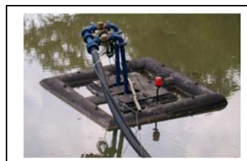
รูปที่ 4 เครื่องสูบน้ำดิบติดตั้งอยู่บนแพลอย
