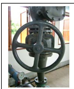
รูปที่ 60 ปิดประตูน้ำด้านท่อจ่ายน้ำของเครื่องสูบน้ำดิบ
