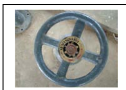
รูปที่ 74 เปิดประตูน้ำกรองทิ้ง (ประตูน้ำหมายเลข 4)
