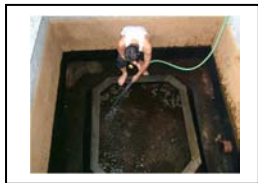
รูปที่ 72 การใช้น้ำฉีดล้างหน้าทรายกรอง
