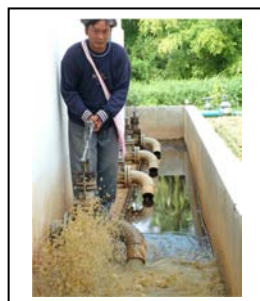
รูปที่ 84 เปิดประตูน้ำระบายตะกอน ข้างถังตกตะกอน(ประตูน้ำหมายเลข 6)
