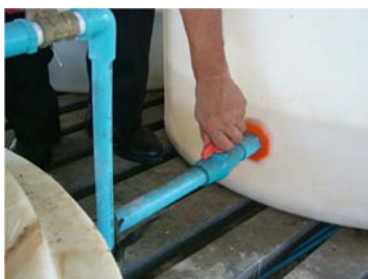
(5) เปิดสารละลายคลอรีนลงถังจ่ายสารละลายคลอรีน
