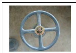
รูปที่ 64 เปิดประตูน้ำเข้ากรอง (ประตูน้ำหมายเลข 9)
