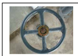
รูปที่ 71 เปิดประตูน้ำล้างทิ้ง (ประตูน้ำหมายเลข 5)
