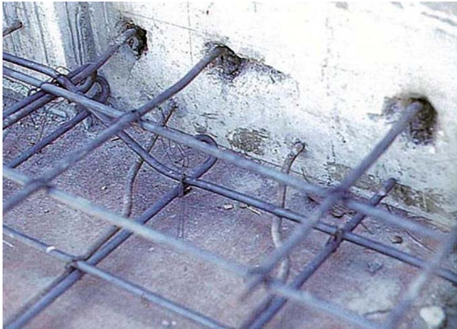
ภาพแสดง การต่อเหล็กคาน ที่จุดเดียวกัน
