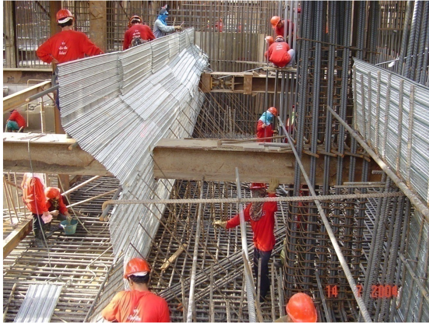
ภาพแสดง ตัวอย่างการใช้แบบหล่อ ตะแกรงพิเศษชนิด Hi-rib
