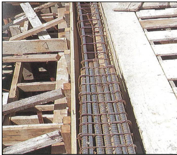
ภาพแสดง การต่อเหล็กคาน ที่จุดเดียวกัน
