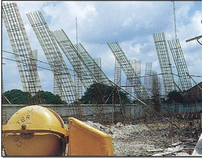
ภาพแสดง เหล็กเสาที่เอียงเนื่องจากการไม่มีการค้ำยันชั่วคราว
