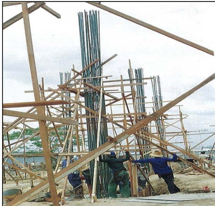
ภาพแสดง การค้ำยันชั่วคราวสำหรับเหล็กเสา
