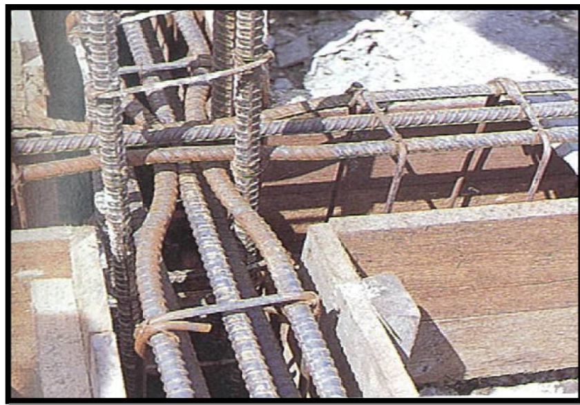
ภาพแสดง การวางเหล็กคานผ่านเสาที่ผิดวิธี
