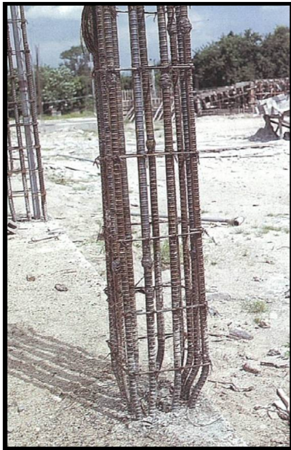
ภาพแสดง ตัวอย่างการดัดเหล็กคาน และเหล็กเสาที่ผิดวิธี
