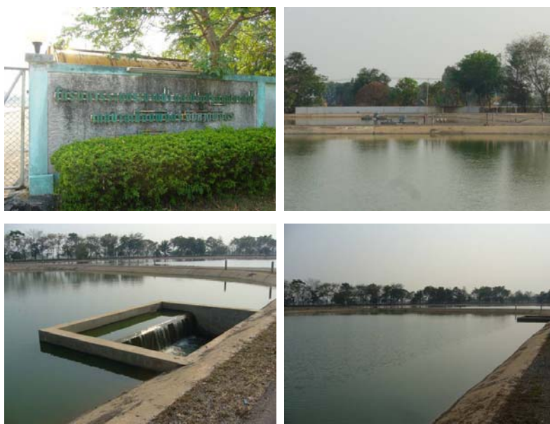
ภาพที่ 5.7 ระบบบำบัดน้ำเสียของเทศบาลเมืองพิจิตร
