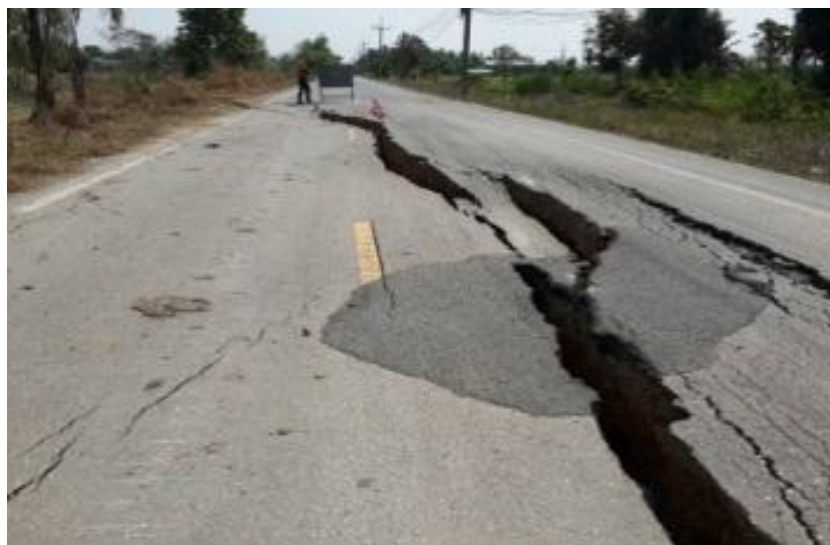
รูปที่ 13 สภาพสายทางระดับ C
