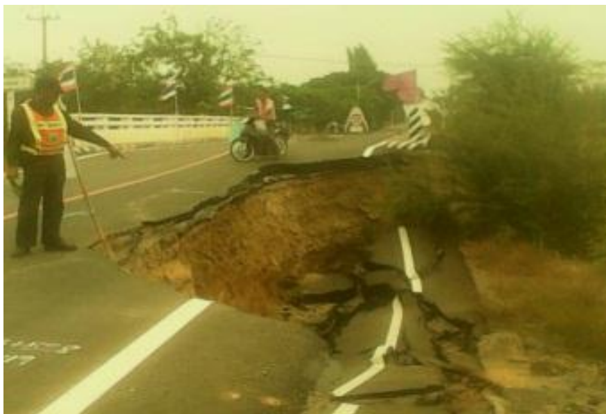
รูปที่ 10 ความเสียหายในลักษณะการทรุดตัวและการเคลื่อนพังของคันทาง
