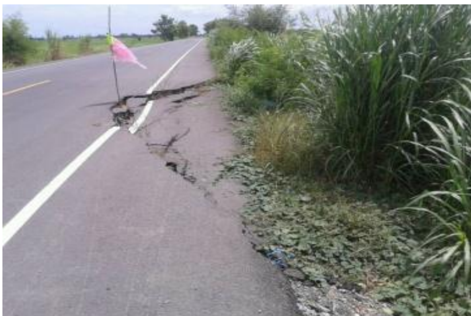
รูปที่ 7 ความเสียหายในลักษณะของการทรุดตัวของคันทาง
