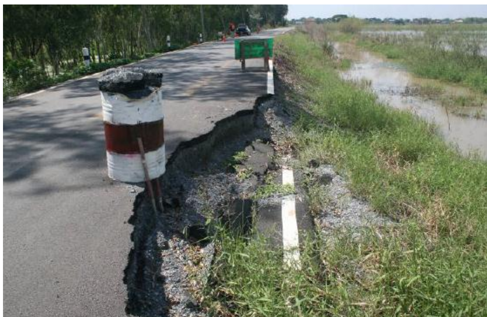
รูปที่ 9 ความเสียหายในลักษณะการเคลื่อนพังของคันทาง
