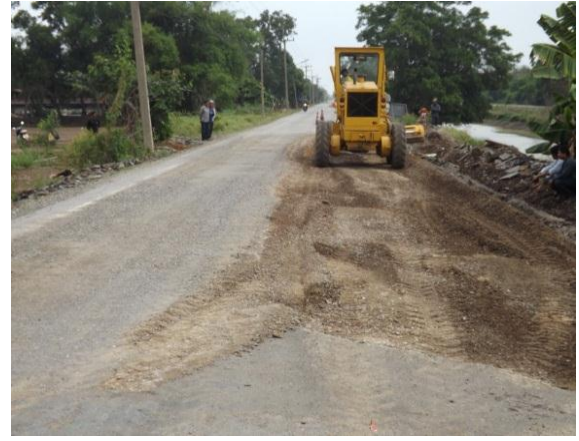
รูปที่ 5 นำเครื่องจักรเข้าซ่อมแซมถนนที่ได้รับความเสียหายเบื้องต้น (ที่มา : ภาพประกอบจากแขวงทางหลวงชนบทปทุมธานี สทช.ที่ 1 (ปทุมธานี))
