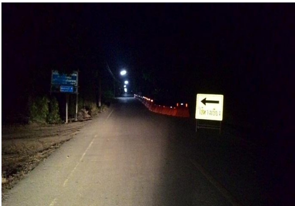
รูปที่ 3 ติดตั้งป้ายเตือน และอุปกรณ์บริเวณพื้นที่เกิดเหตุให้ชัดเจนทั้งเวลากลางวันและกลางคืน (ที่มา : ภาพประกอบจากแขวงทางหลวงชนบทปทุมธานี สทช.ที่ 1 (ปทุมธานี))
