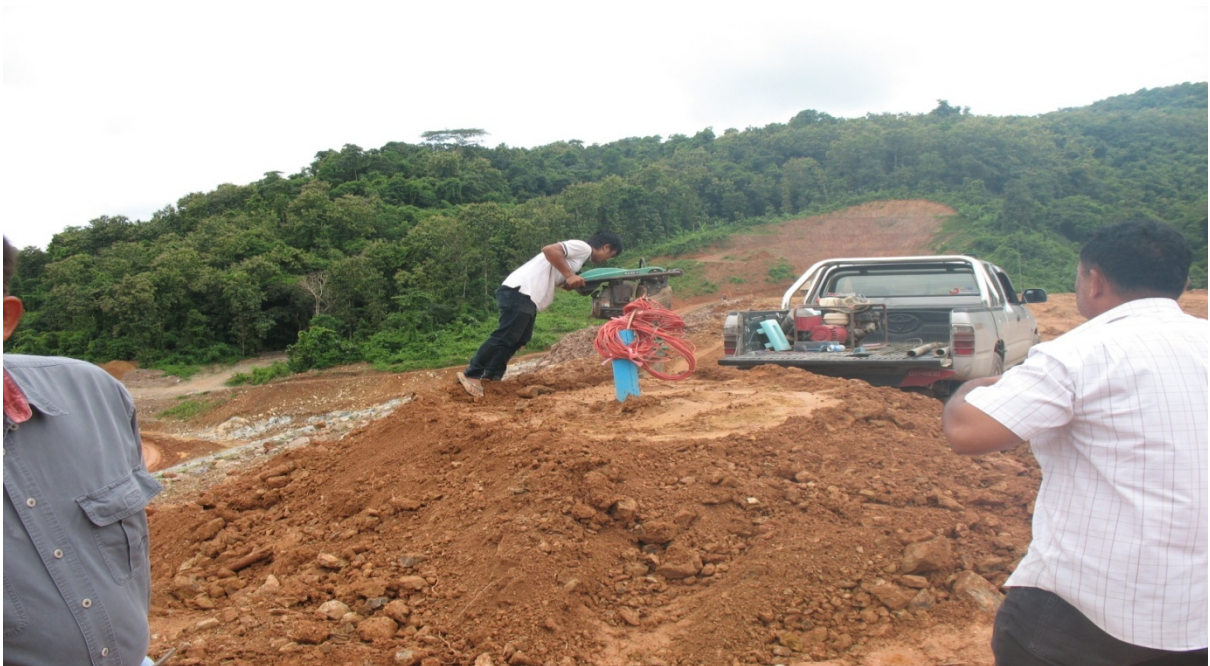
รูปที่ ๓๘ การรวมสาย Cable จาก Piezometer ทั้งหมดไว้ในท่อ แล้วบดอัดดินรอบๆ
