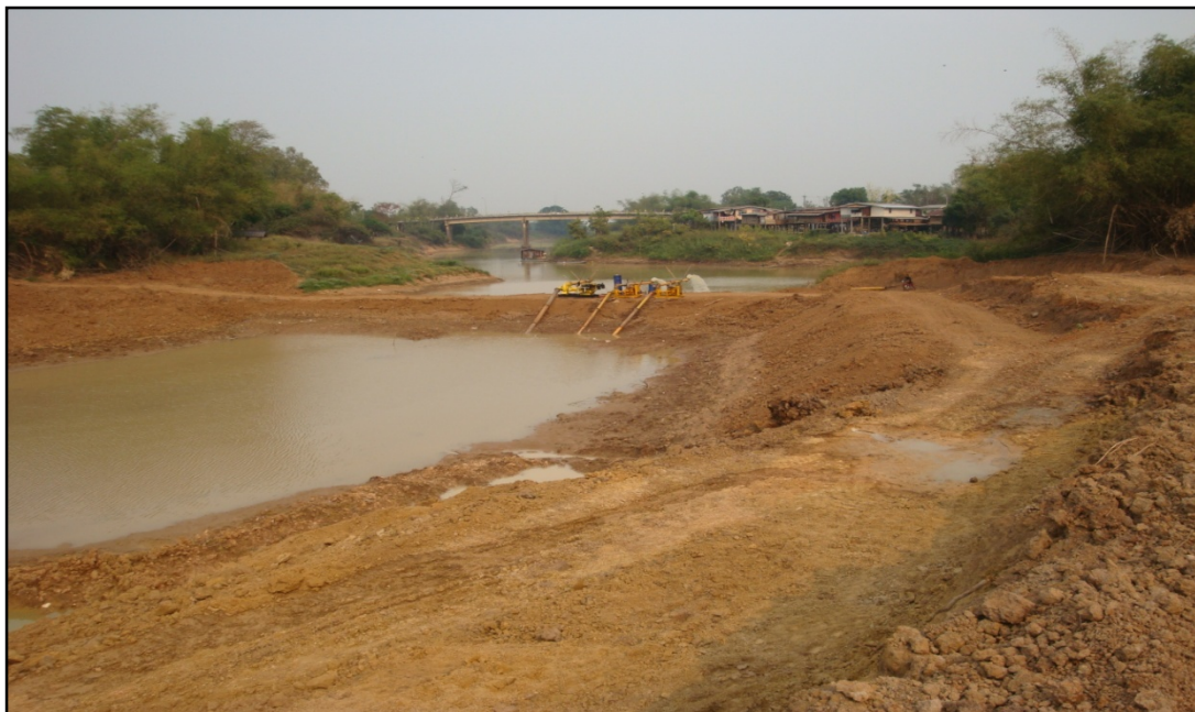
รูปที่ ๒๐ แสดงทำนบกั้นน้ำชั่วคราวและจุดที่ตั้งเครื่องสูบน้ำ
