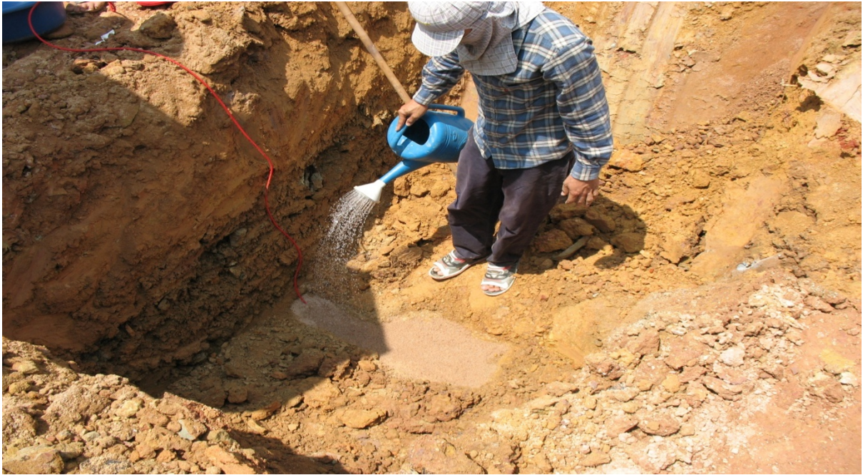
รูปที่ ๓๗ การทำให้ Pocket ที่ฝัง Piezometer Tip ไว้มีความชื้น
