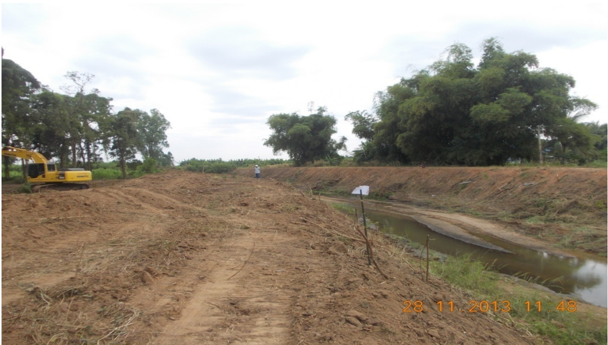
รูปที่ ๑๑ งานถางป่า ขุดต่อ ปรับพื้นที่
