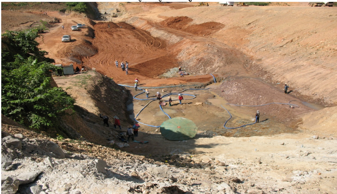
รูปที่ ๑๙ ตัวอย่างการรวมน้ำที่ไหลซึมเข้ามาในบ่อก่อสร้างไว้ในบ่อดักน้ำแล้วสูบออก
