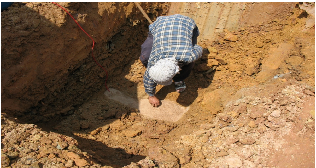
รูปที่ ๓๖ การฝัง Piezometer Tip ไว้ได้ทราย
