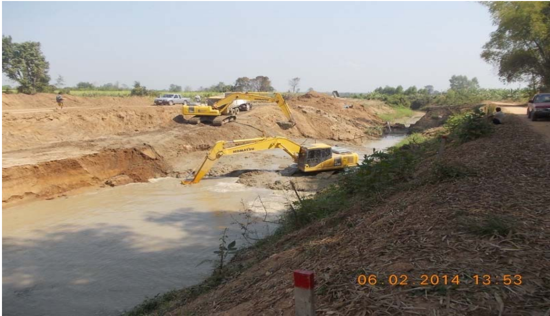
รูปที่ ๑๖ การขุดดินบ่อก่อสร้าง
