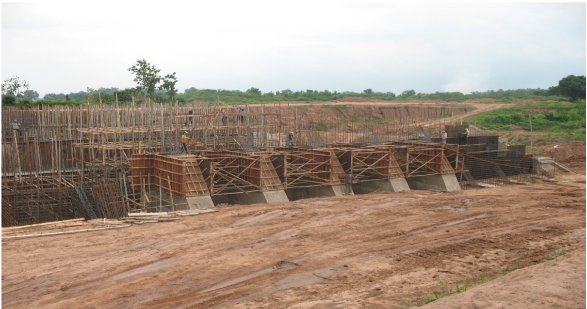
รูปที่ ๒๔ การตั้งแบบเพื่อจะเทคอนกรีตต่อเนื่อง
