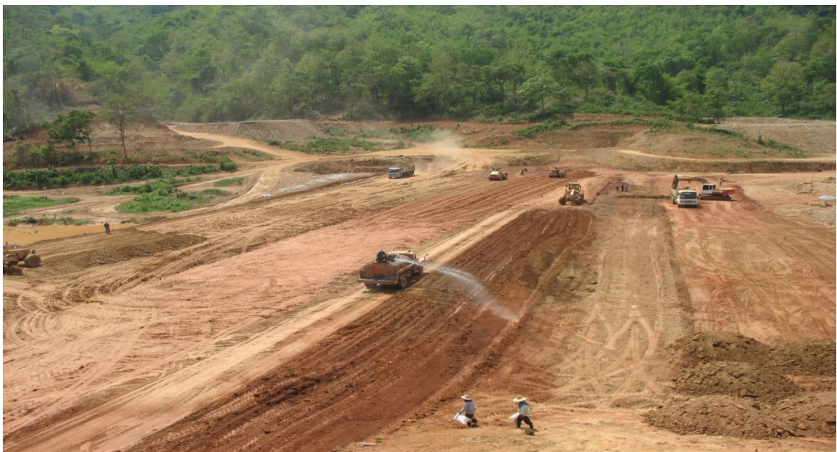
รูปที่ ๒๗ ตัวอย่างการถมดินบดอัดแน่นทำนบดินอ่างเก็บน้ำ
