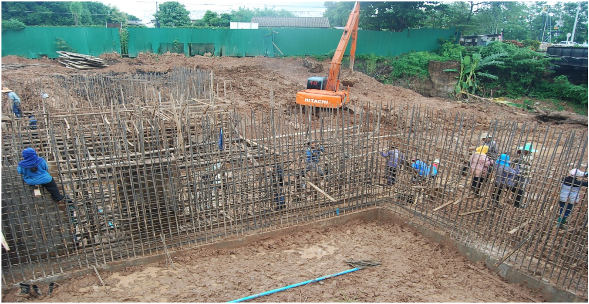
รูปที่ ๒๓ ตัวอย่างคอนกรีตที่เทเสร็จแล้วชั้นแรก หลังจากนั้นจึงเตรียมตั้งแบบเพื่อเทชั้นต่อไป
