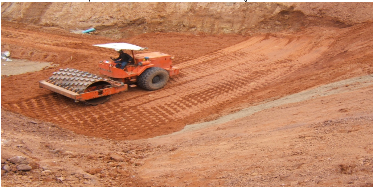
รูปที่ ๒๕ รถบดสั่นสะเทือนแบบตีนแกะ
