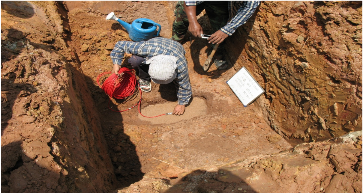
รูปที่ ๓๕ การฝัง Piezometer Tip ไว้ได้ทราย
