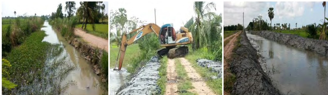
แสดงลักษณะการขุดวางดินแนวไหล่คันคลอง
