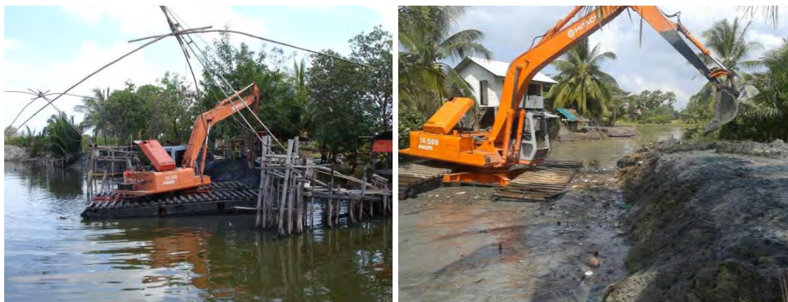
แสดงลักษณะงานขุดลอกคลองที่มีสิ่งกีดขวาง เครื่องมือการประมง
