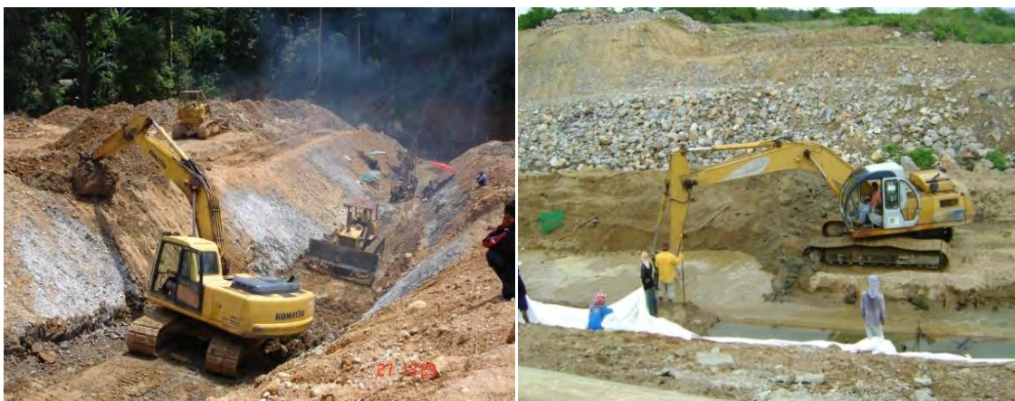
แสดงลักษณะงานขุดร่องแกน (งานสร้างเขื่อน) งานเรียงหิน(งานก่อสร้าง)
