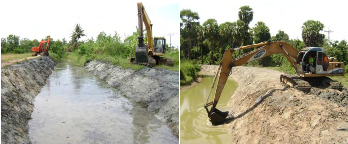
แสดงลักษณะงานขุดลอกคลองส่งน้ำ
