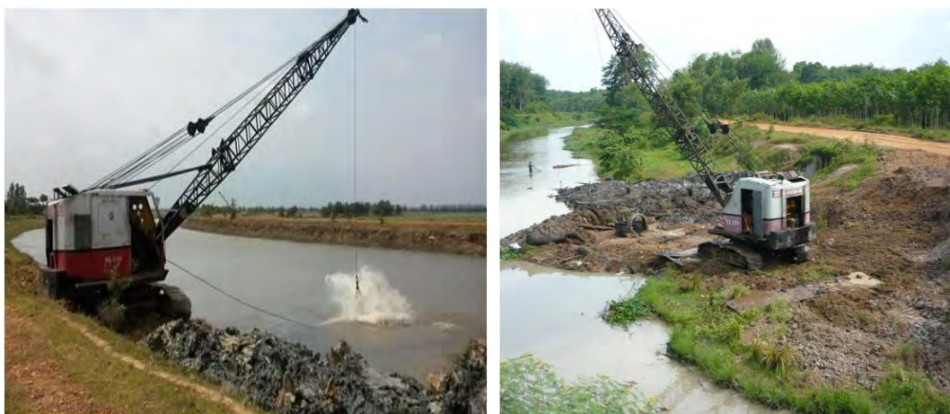
แสดงลักษณะงานขุดคลองระบายน้ำ
