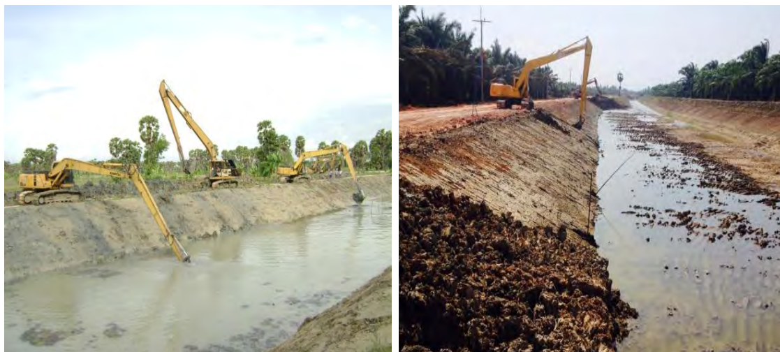
แสดงลักษณะงานขุดลอกคลองระบายน้ำ
