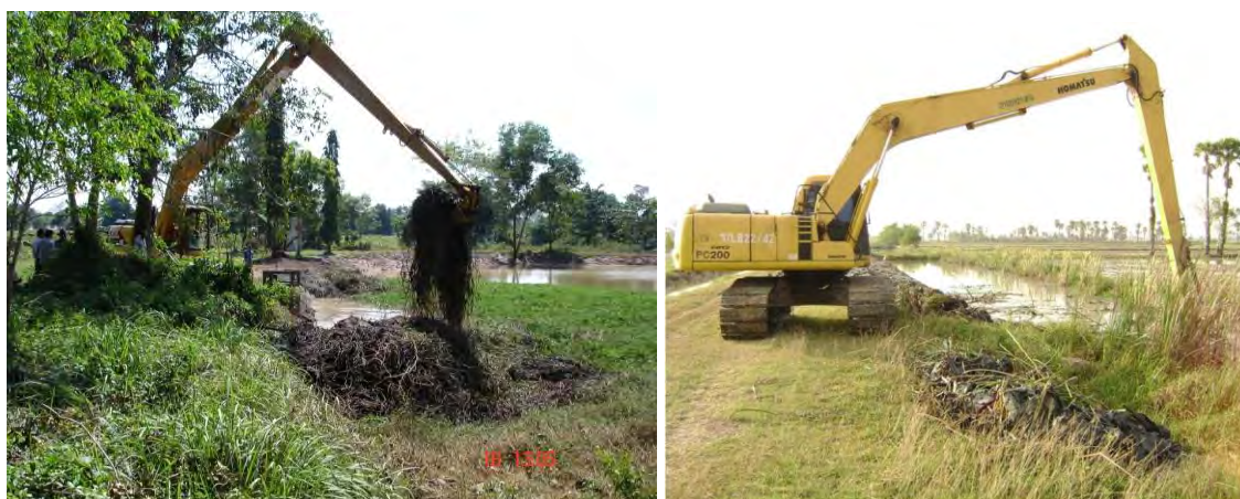
แสดงลักษณะงานขุดลอกแหล่งน้ำที่มีวัชพืชรากหยั่งลึก
