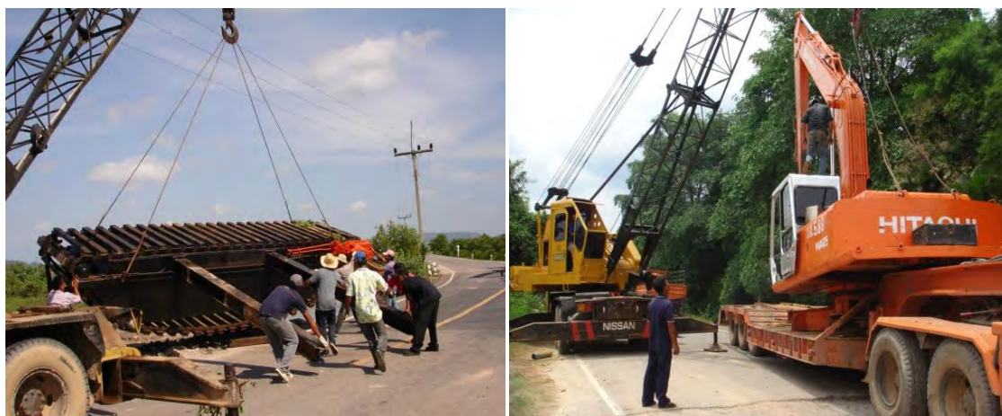
แสดงลักษณะการยกชิ้นส่วนและอุปกรณ์ของรถชุดชนิด โป๊ะเหล็ก [MB] เพื่อประกอบตัวรถชุด
