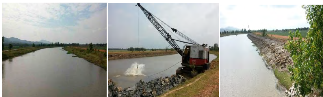
แสดงลักษณะการขุดวางดินแนวไหล่คันคลอง
