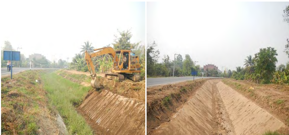
แสดงลักษณะใช้รถขุดไฮดรอลิกชนิดดินตะขাপุ้งกึ่งตักเข้า [HB-CM] กับงานขุดลอกคลองส่งน้ำ
