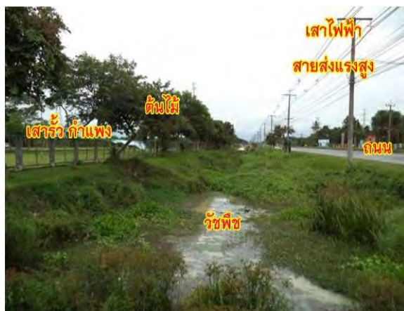
ภาพก่อนขุดลอก
