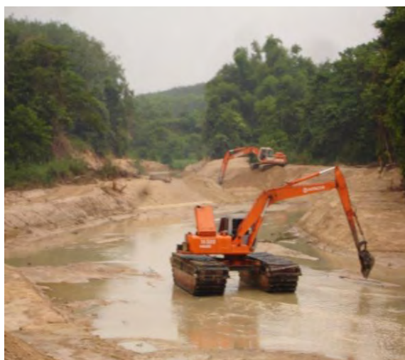
แสดงลักษณะงานขุดลอกตะกอนทรายท้องคลอง ของรถขุดไฮดรอลิกชนิดโป๊ะเหล็ก Marsh Backhoe
