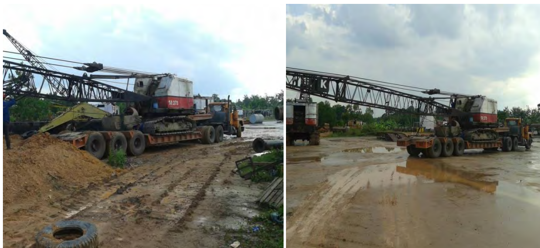
แสดงลักษณะขนย้ายรถชนิด Dragline [DL-CM] ด้วยรถบรรทุกลากจูง
