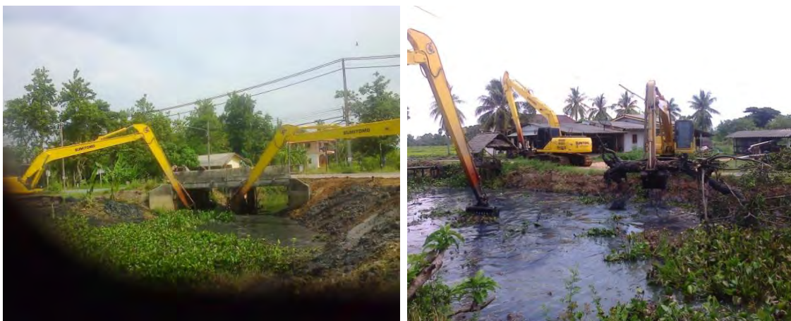
แสดงลักษณะงานขุดลอกคลองธรรมชาติที่คันคลองมีสิ่งกีดขวางทาง
