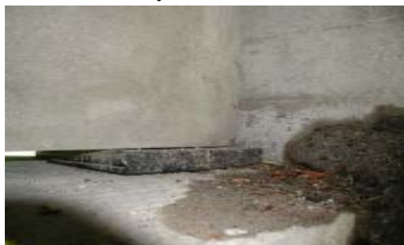
รูปที่ 6 รูปตัวอย่างจุตรองรับสะพาน (Bearing)
