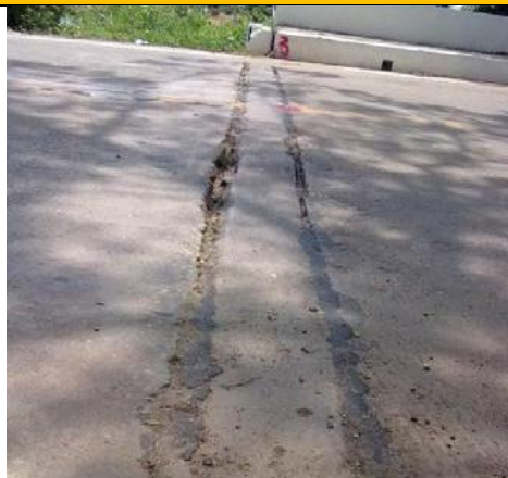
ยางรอยต่อหลุดล่อนออกเป็นหลุมใหญ่
