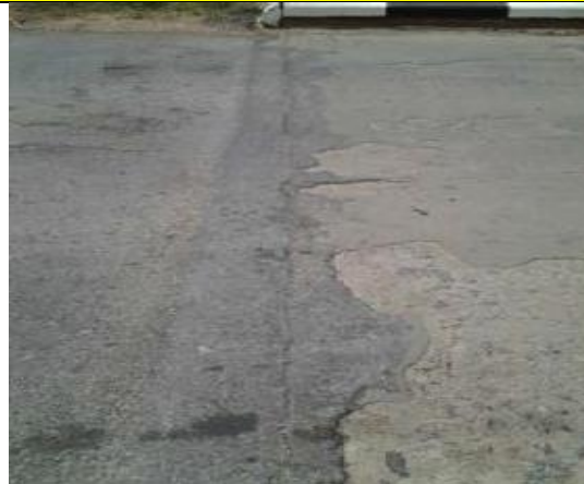
มีความต่างระดับของคอสะพานกับสะพานเล็กน้อย
