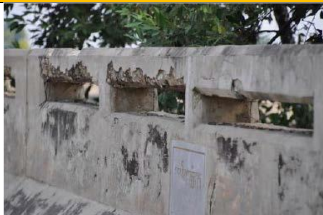
คอนกรีตหลุดล่อนเป็นแผ่น มีคราบสกปรก
