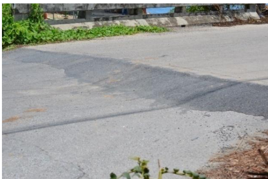
คอสะพานมีความต่างระดับมาก
