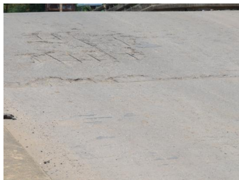
ผิวทางหลุดล่อน จนเหล็กเสริมโผล่
