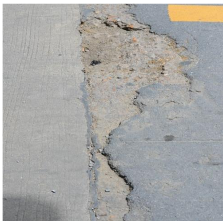
รอยต่อหลุดล่อนออกเป็นแผ่น
