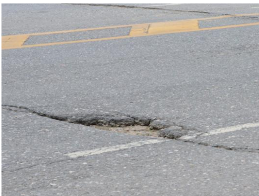
ผิวทางหลุดล่อนเป็นหลุมขนาดใหญ่
