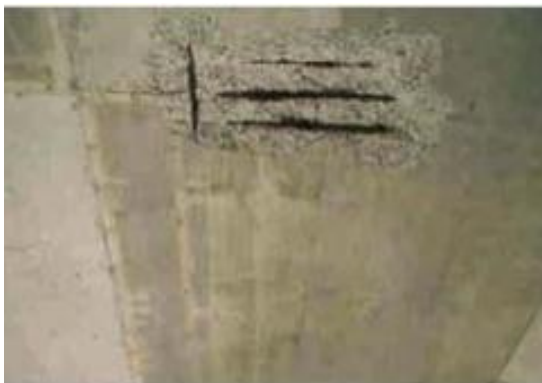
เหล็กเสริมขึ้นสนิมบางแห่ง
