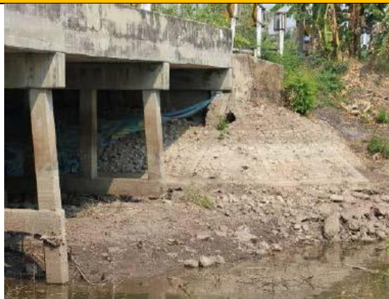
มีการแตกออกเป็นแผ่นของคอนกรีต
