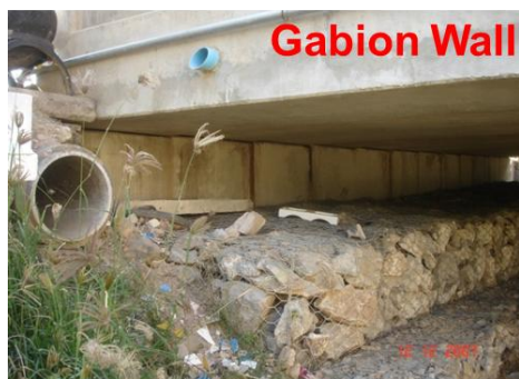
รูปที่ 7 ตัวอย่างโครงสร้างป้องกันตลิ่ง
