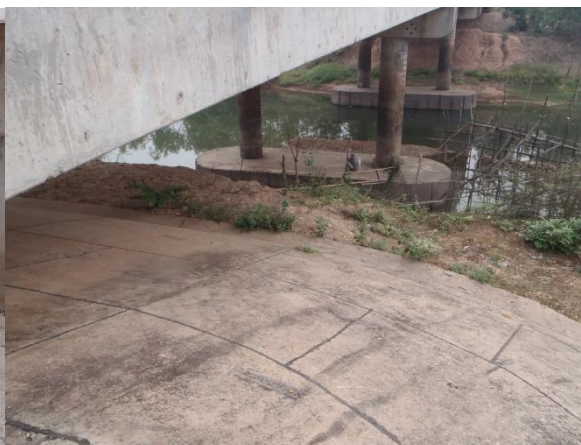
โครงสร้างอยู่ในสภาพดี
