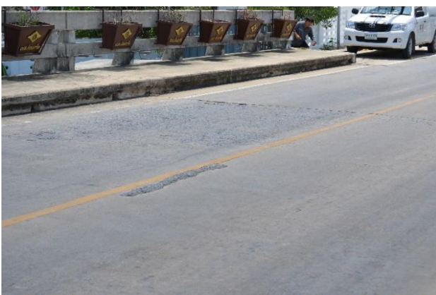
ผิวทางหลุดล่อน มีรอยปะนูนขึ้นมา
