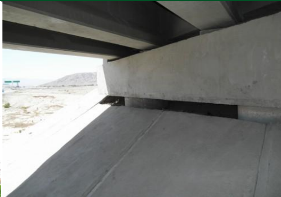
โครงสร้างอยู่ในสภาพดี
