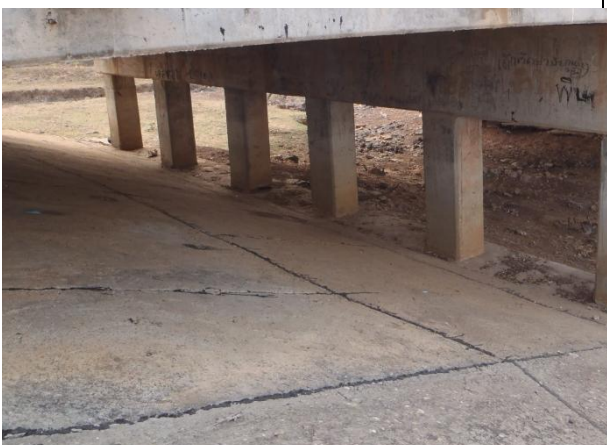
โครงสร้างอยู่ในสภาพดี
