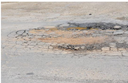
ผิวทางหลุดล่อนเป็นหลุมขนาดใหญ่
