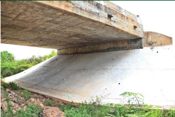
โครงสร้างอยู่ในสภาพดี
