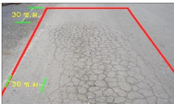
รูปที่ ๑ ตัวอย่างการกำหนดขอบเขตพื้นที่ความเสียหาย เพื่อวัดปริมาณงาน
