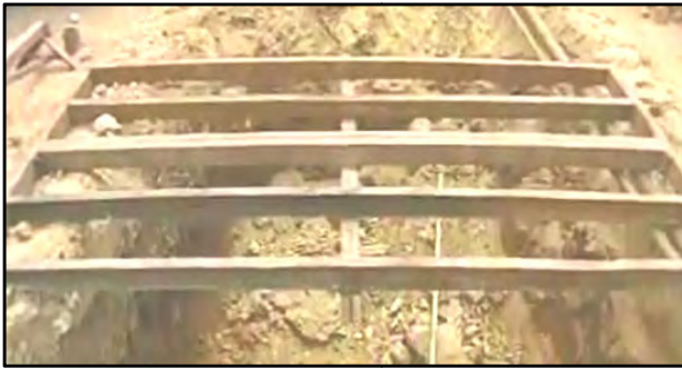
แคร่บรรทุกน้ำหนัก (loading platform)
