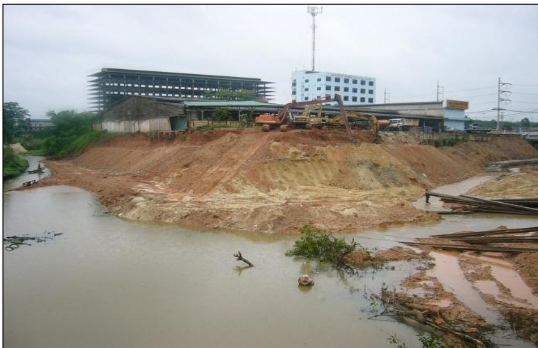
รูปที่ 6 แสดงการขุดดินปรับแต่ง Slope
