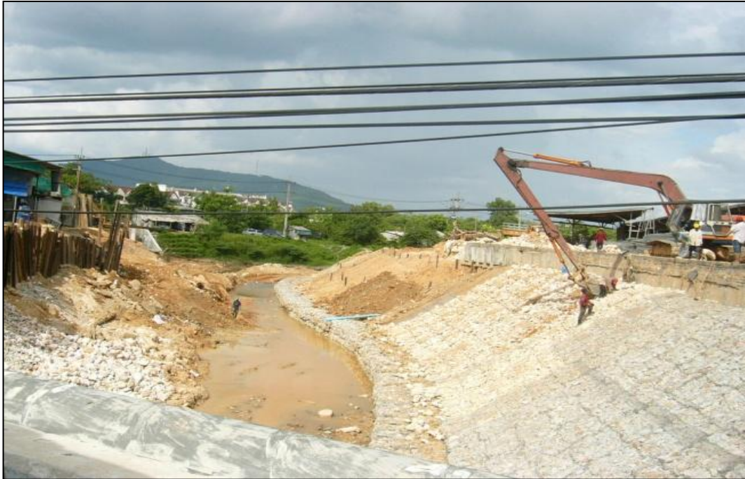
รูปที่ 10 การวางกล่อง Mattress บน Slope
