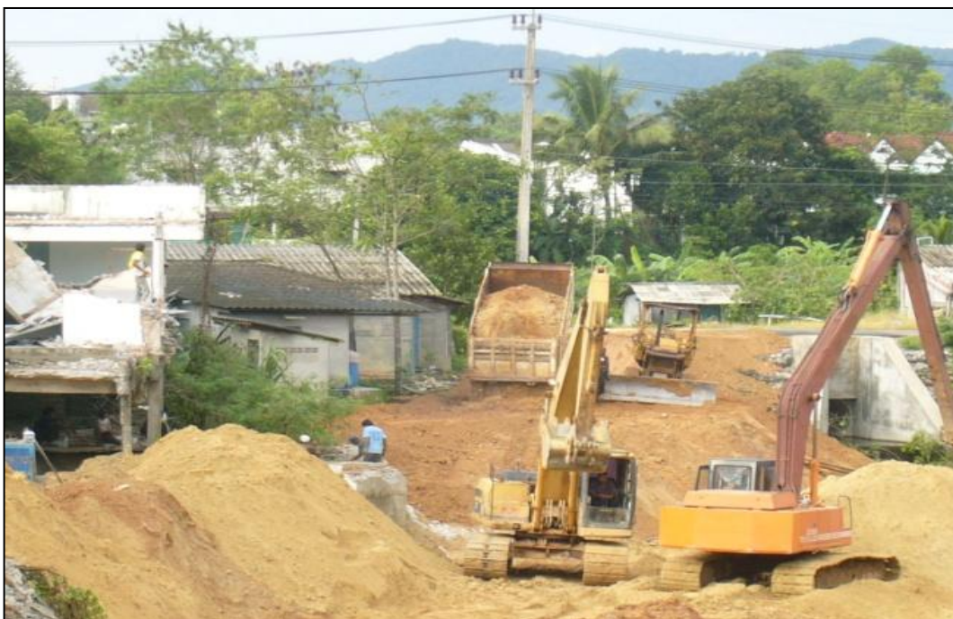
รูปที่ 12 ทางลำเลียงสำหรับรถดินตะขาบติดตั้งหัวตอกแผ่นเหล็ก
