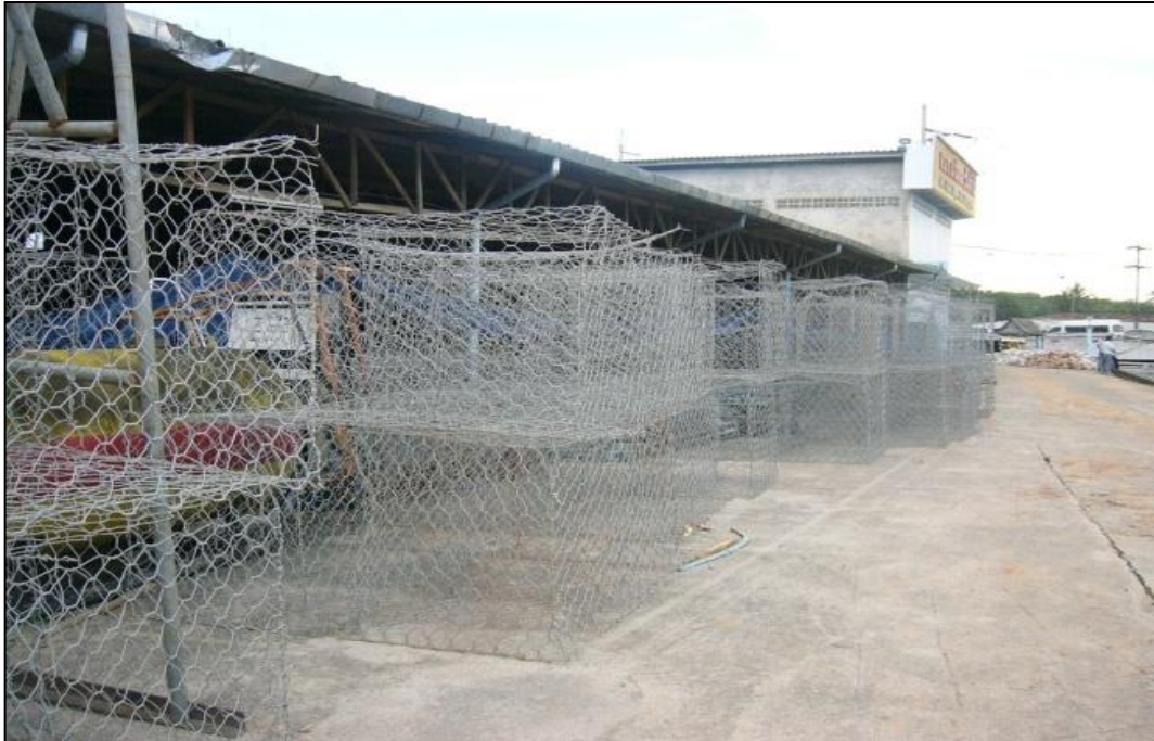
รูปที่ 8 กล่อง Gabions ที่ผูกขึ้นรูปไว้
