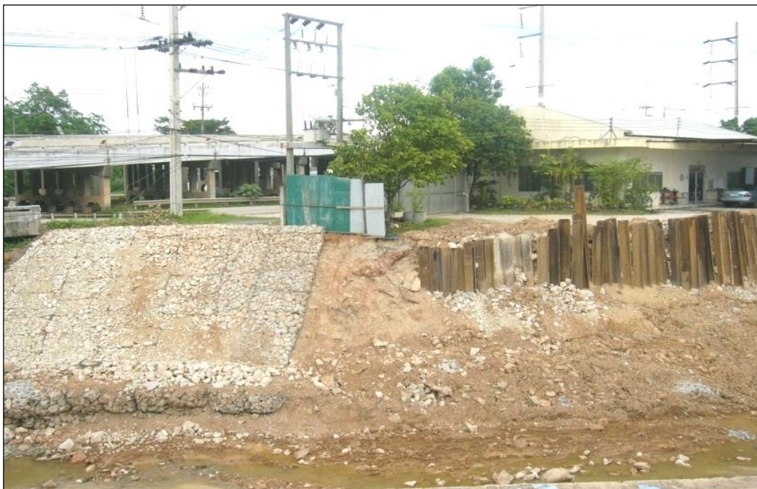
รูปที่ 19 Gabions ป้องกันตลิ่งคลองหวัะ กม.3+170 กม.3+185 ฝั่งขวา
