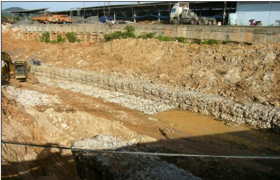
รูปที่ 9 แสดงการวางกล่อง Gabions และกล่อง Mattress
