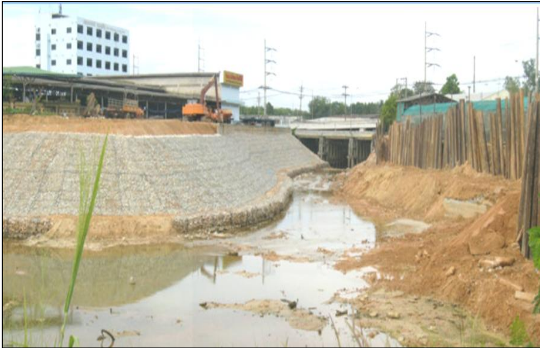
รูปที่ 16 Gabions ป้องกันตลิ่งคลองหวัะ กม.3+170 กม.3+250 ฝั่งซ้าย
