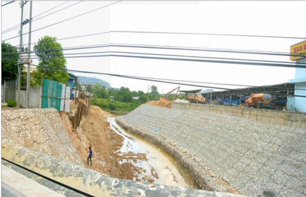
รูปที่ 18 Gabions ป้องกันตลิ่งคลองหวัะ กม.3+170 กม.3+325 ฝั่งซ้าย และ กม.3+170 กม.3+185 ฝั่งขวา
