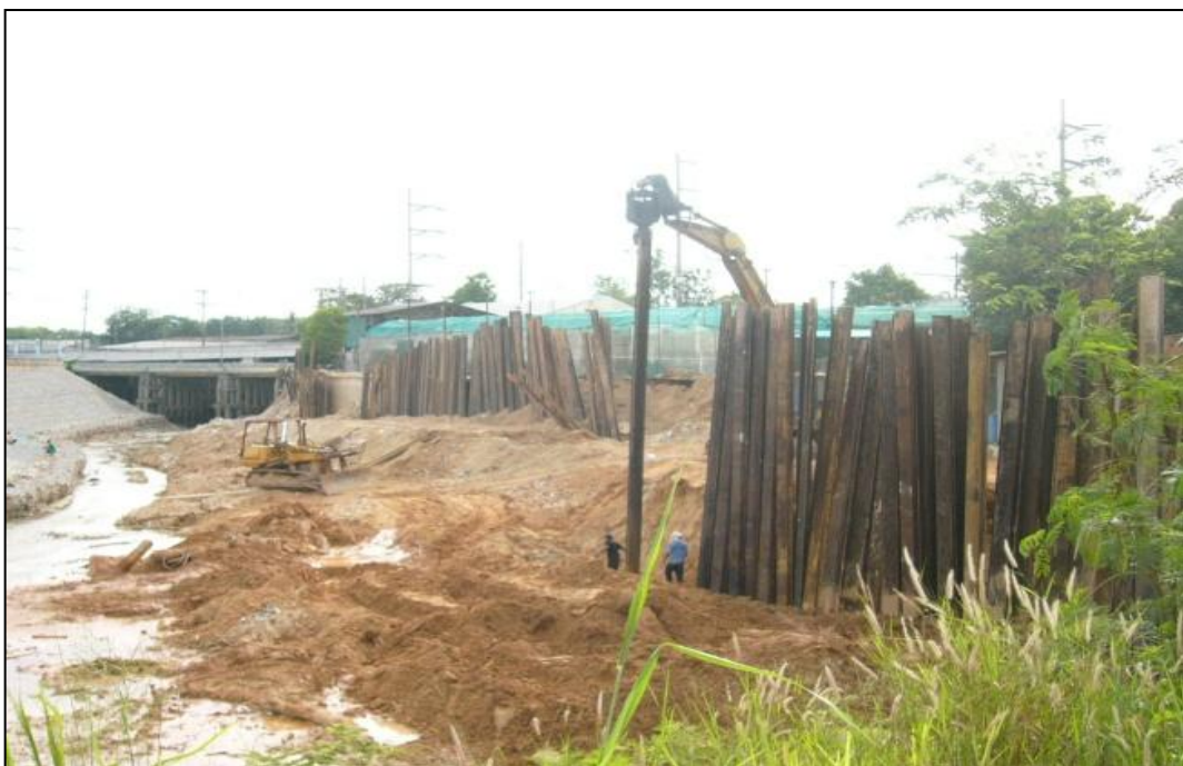
รูปที่ 14 แสดงการตอกแผ่นเหล็ก
