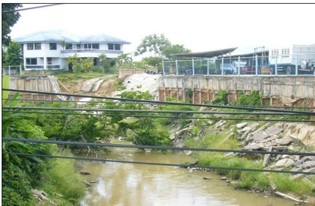
รูปที่ 1 ภาพแสดงสภาพพื้นที่สร้างก่อนเข้าดำเนินการ
