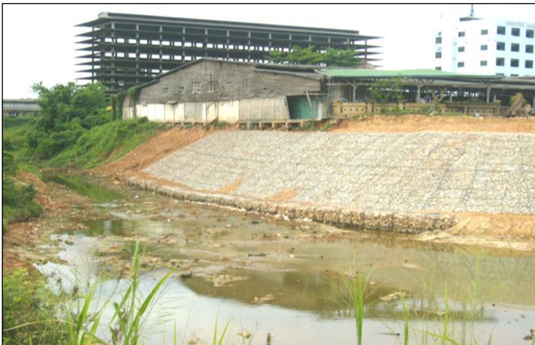
รูปที่ 17 Gabions ป้องกันตลิ่งคลองหวัะ กม.3+250 กม.3+325 ฝั่งซ้าย
