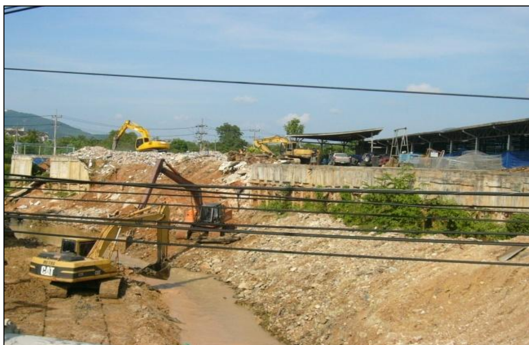
รูปที่ 3 ภาพแสดงรื้อทุบอาคาร และการขุดเปิดบ่อก่อสร้างกำแพงคอนกรีต
