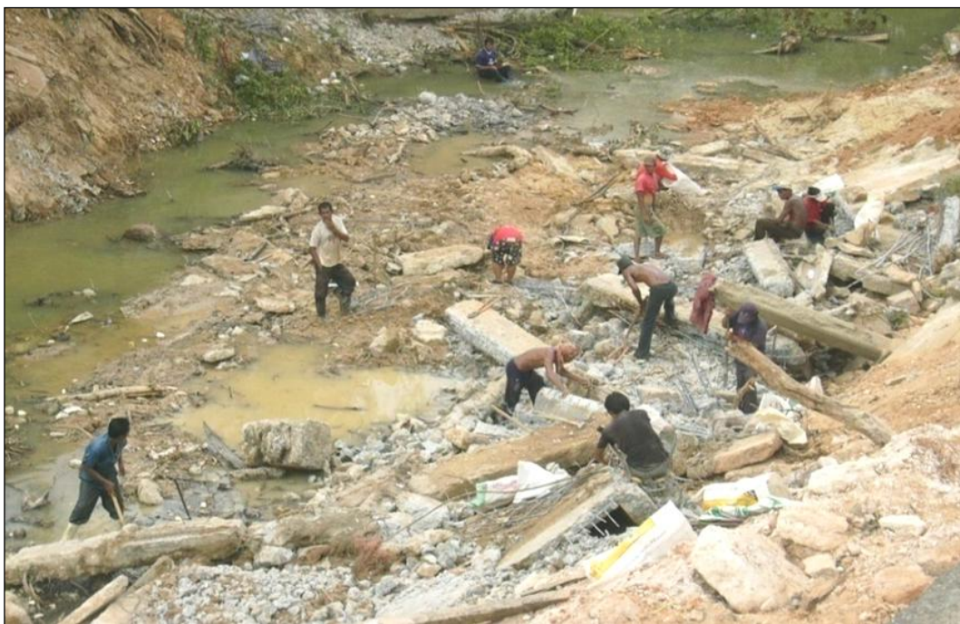
รูปที่ 2 งานรื้อโครงสร้าง คสล. และผนังก่ออิฐฉาบปูน
