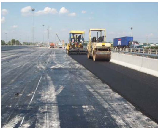
แสดงการปูแอสฟัลต์คอนกรีตบนพื้นสะพาน
