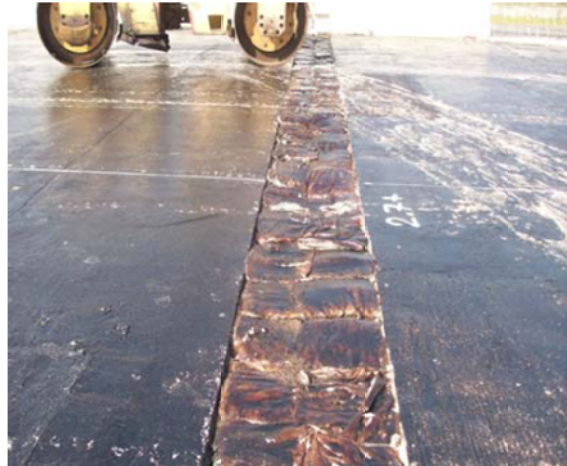
แสดงการใส่กระสอบหิน คลุกจนเต็ม Block Out
