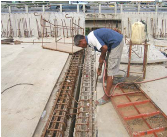
แสดง Block Out ที่ End Segment
