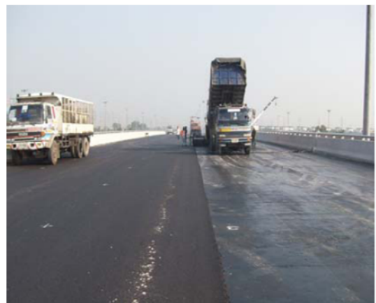
แสดงการปูแอสฟัลต์คอนกรีตบนพื้นสะพาน
