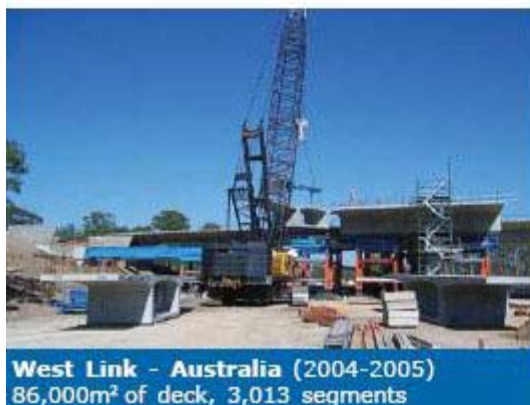
รูปที่ 50: ตัวอย่างสะพานที่ใช้รูปแบบการก่อสร้างแบบ Balanced Cantilever โดยใช้ Crane
