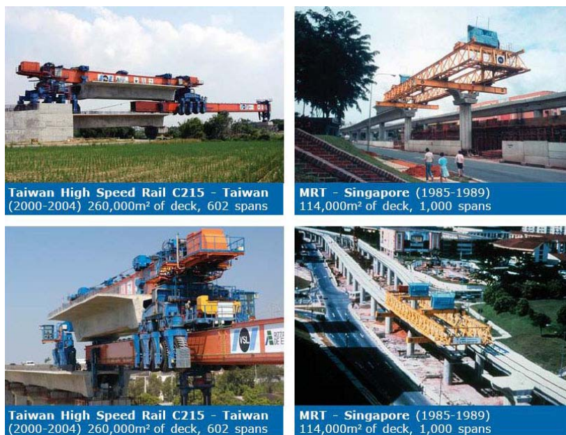
รูปที่ 41: ตัวอย่างสะพานที่ใช้รูปแบบ Full span Precast
