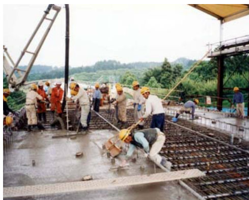
รูปที่ 58: การก่อสร้างโดยวิธี Incremental Launching
