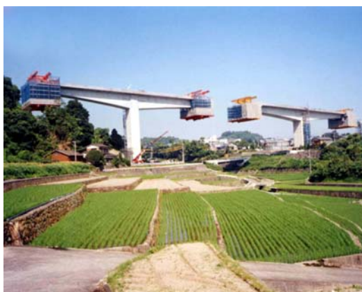
รูปที่ 42: การก่อสร้างสะพานด้วยวิธี Balanced cantilever
