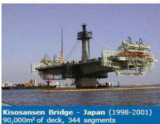
รูปที่ 49: ตัวอย่างสะพานที่ใช้รูปแบบการก่อสร้างแบบ Balanced Cantilever โดยใช้ Lifting Frame
