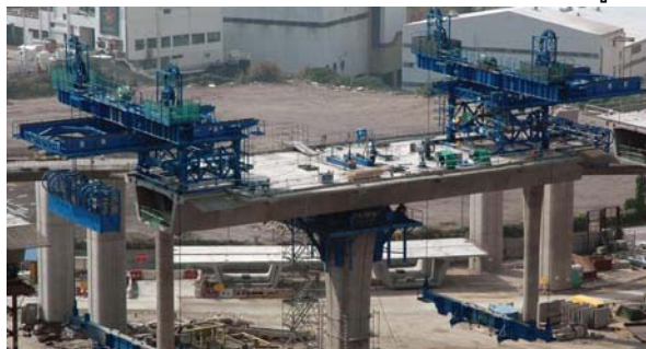
รูปที่ 47: การก่อสร้างวิธี Balanced Cantilever โดยใช้ Lifting Frames
