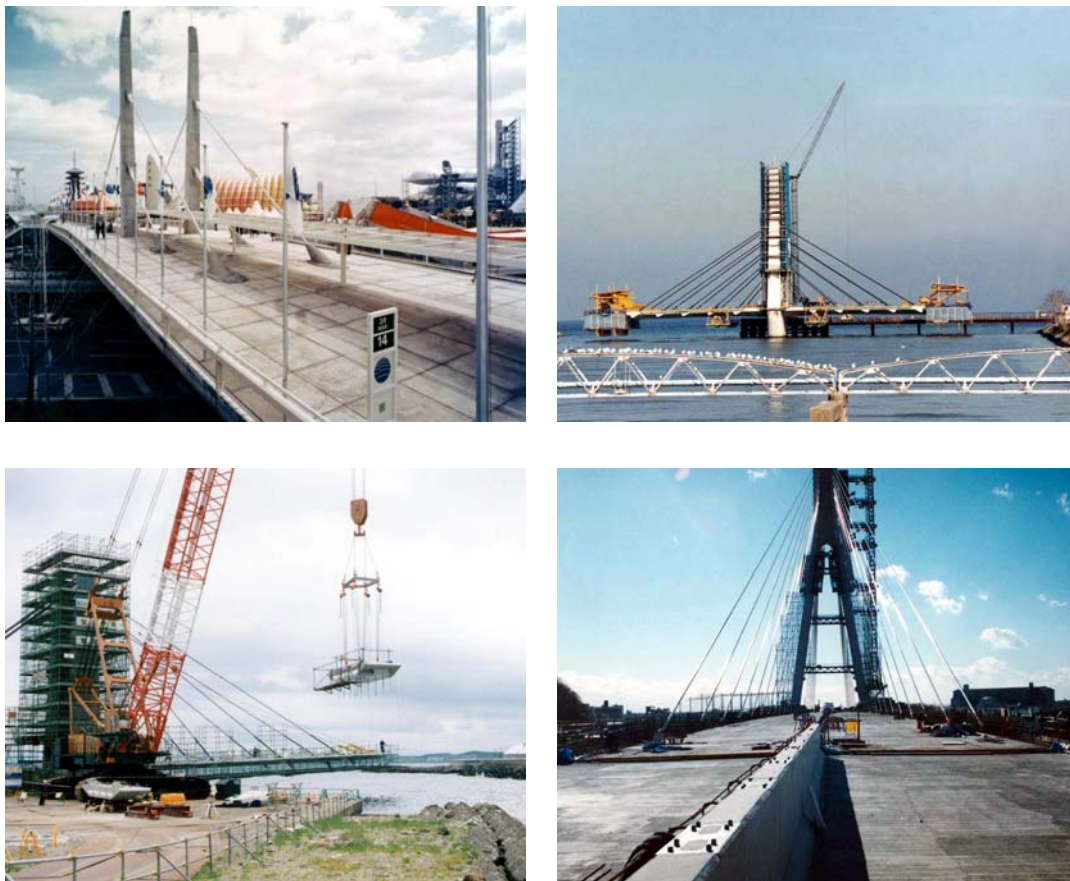
รูปที่ 52: การก่อสร้างสะพานขึง Cable-stayed bridge โดยวิธี Balanced cantilever
