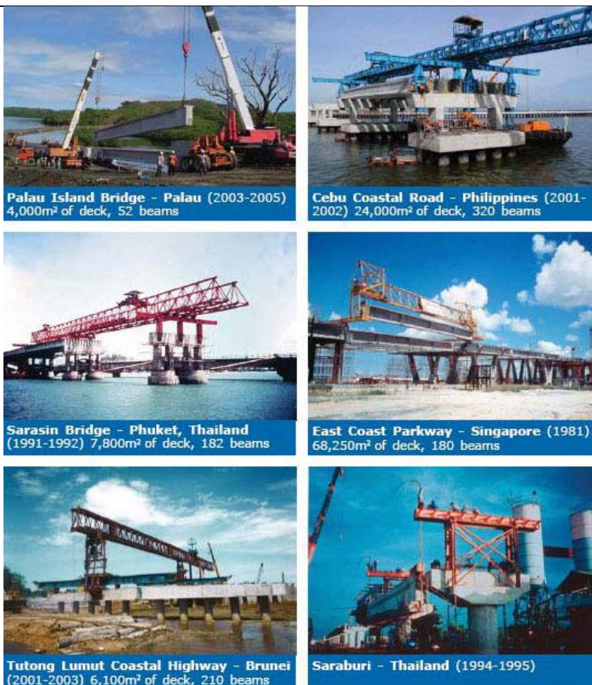
รูปที่ 39: ตัวอย่างสะพานที่ใช้รูปแบบ Precast Beam
