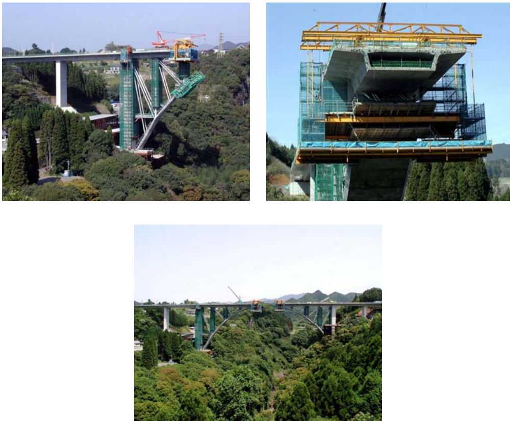
รูปที่ 44: การใช้ Movable Formwork ในการก่อสร้างสะพานโค้ง
