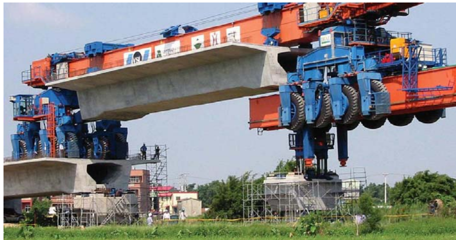
รูปที่ 40: วิธีการก่อสร้างด้วยการติดตั้งชิ้นส่วน Full span Precast
