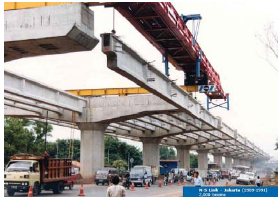
รูปที่ 38: วิธีการก่อสร้างด้วยการติดตั้งชิ้นส่วน Precast Beam
