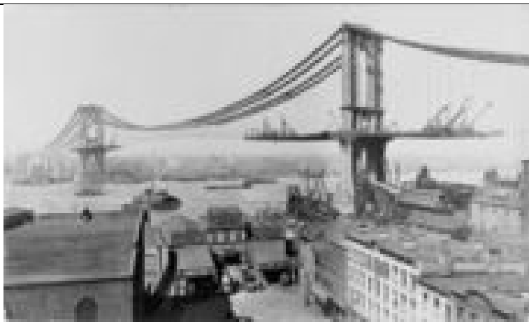
รูปที่ 65: การก่อสร้างสะพานแขวน
