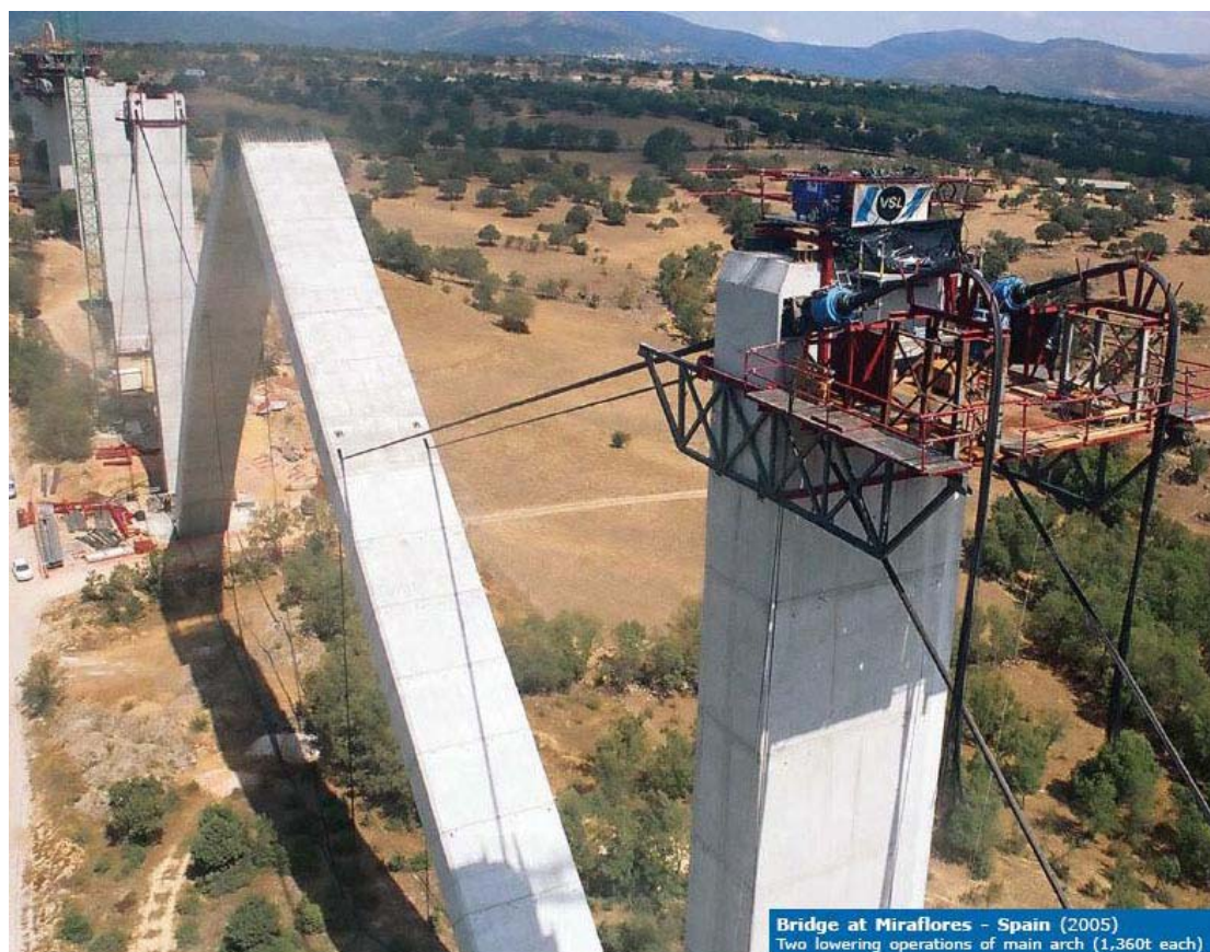
รูปที่ 64: การใช้อุปกรณ์ยกชิ้นส่วนขนาดใหญ่พิเศษ
