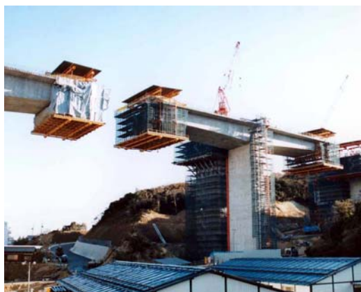
รูปที่ 43: การก่อสร้างสะพานโดยใช้ Movable Formwork (Form Traveler)
