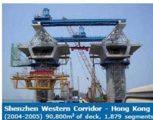
รูปที่ 49: ตัวอย่างสะพานที่ใช้รูปแบบการก่อสร้างแบบ Balanced Cantilever โดยใช้ Lifting Frame
