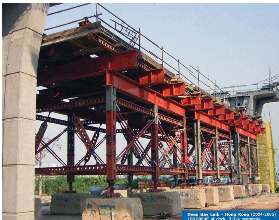
รูปที่ 54: การก่อสร้างแบบ Span-by-span โดยการตั้งนั่งร้าน
