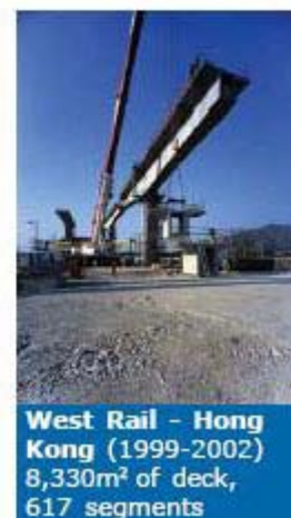
รูปที่ 50: ตัวอย่างสะพานที่ใช้รูปแบบการก่อสร้างแบบ Balanced Cantilever โดยใช้ Crane
