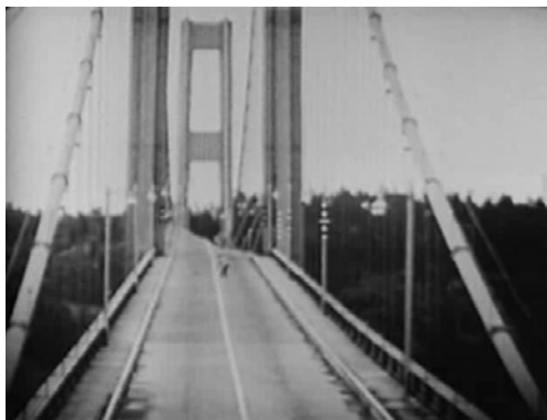
รูปที่ 13: สะพานแขวนที่เกิดการสั่นอย่างรุนแรงและวิบัติ (Tacoma Narrows Bridge, USA)
