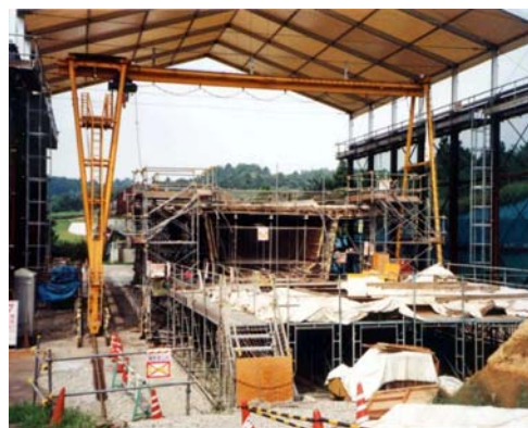
รูปที่ 58: การก่อสร้างโดยวิธี Incremental Launching
