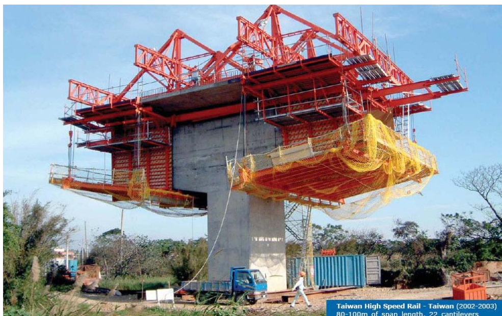
รูปที่ 61: การใช้ Form Traveler ในการก่อสร้างสะพาน
