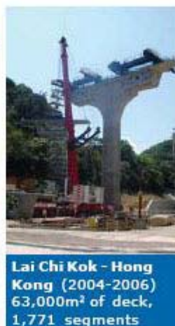
รูปที่ 50: ตัวอย่างสะพานที่ใช้รูปแบบการก่อสร้างแบบ Balanced Cantilever โดยใช้ Crane
