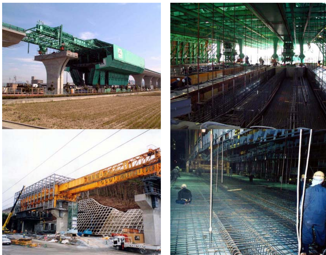
รูปที่ 53: Movable Formwork หรือ Form Traveler ในการก่อสร้างแบบ Span-by-span
