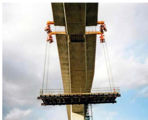
รูปที่ 42: การก่อสร้างสะพานด้วยวิธี Balanced cantilever
