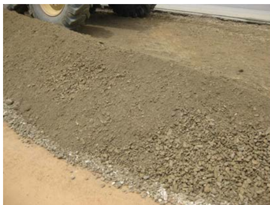
รูปที่ 97 การแยกตัว (Segregation) ของวัสดุส่วนหยาบและส่วนละเอียด
