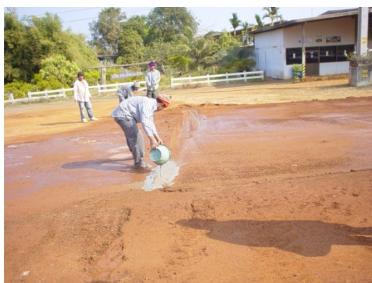
รูปที่ 103 การใช้น้ำผสมปูนซีเมนต์ราดบริเวณรอยต่อ
