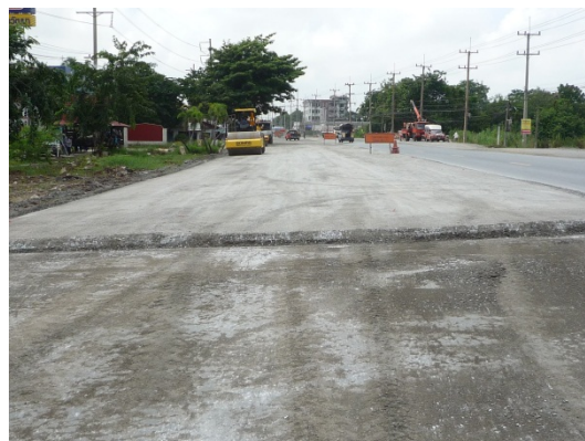
รูปที่ 102 การตัดแต่งรอยต่อตามขวางโดยใช้ใบมีดของรถเกลี่ยผสมกดลงไปบนชั้นทางแปลงที่ติดกัน
