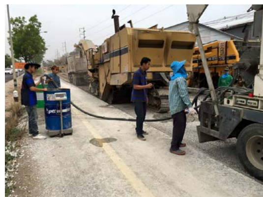
รูปที่ 80 การจับเวลาเพื่อหาอัตราการไหลของน้ำ
