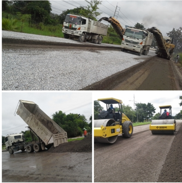
รูปที่ 42 กระบวนการก่อสร้างชั้นทาง
