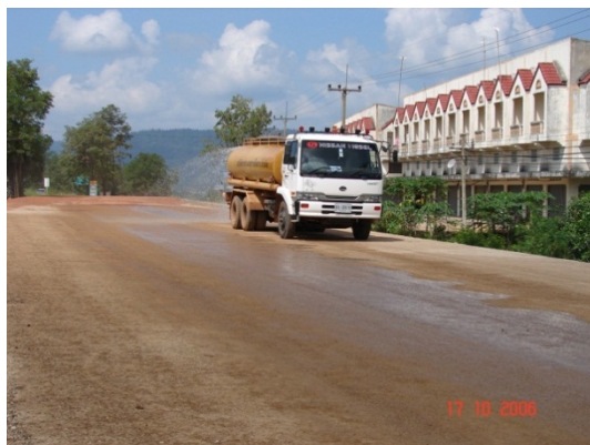
รูปที่ 106 การบ่มชั้นทางที่ปรับปรุงคุณภาพด้วยปูนซีเมนต์และรอยแตกเนื่องจากการหดตัว
