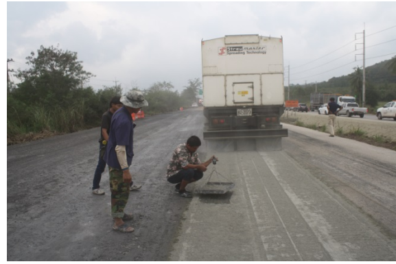
รูปที่ 30 การสุ่มตรวจสอบปริมาณปูนซีเมนต์โดยใช้ถาดรอง
