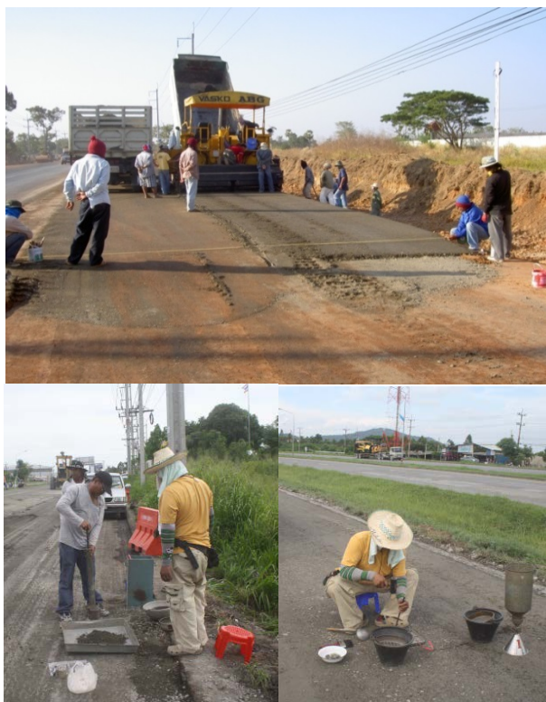
รูปที่ 84 การก่อสร้างแปลงทดลองพร้อมทั้งเก็บตัวอย่างและทดสอบความแน่น
