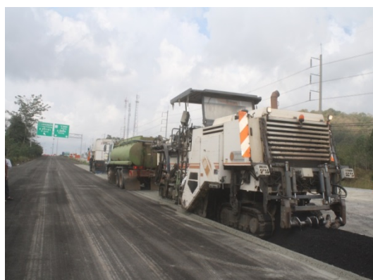
รูปที่ 29 การทำงานของชุดรถชุดตัดผสมและรถน้ำขณะทำงานตามหลังรถโรยปูนซีเมนต์
