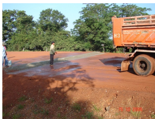
รูปที่ 103 การใช้น้ำผสมปูนซีเมนต์ราดบริเวณรอยต่อ
