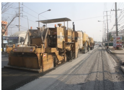
รูปที่ 21 เครื่องจักรสำหรับ Recycling CMI รุ่น PR-800-7
