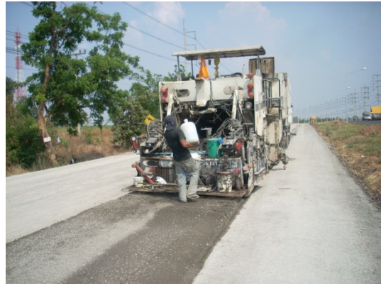
รูปที่ 95 การผสมคลุกเคล้าวัสดุผสมปูนซีเมนต์ไม่สม่ำเสมอควรตรวจสอบอุปกรณ์และห้องผสม
