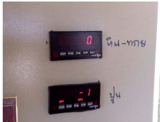
รูปที่ 46 การตรวจสอบจอแสดงผลค่าน้ำหนักเริ่มต้นของเครื่องชั่งปูนซีเมนต์
