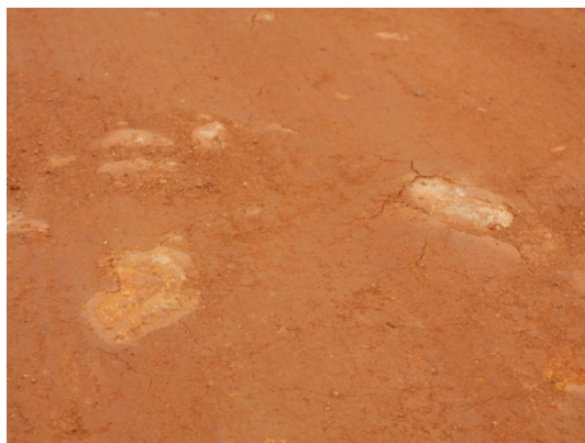
รูปที่ 93 วัสดุโตเกินขนาดที่อยู่ในชั้นทางที่ปรับปรุงคุณภาพด้วยปูนซีเมนต์ที่ได้ก่อสร้างไว้แล้ว
