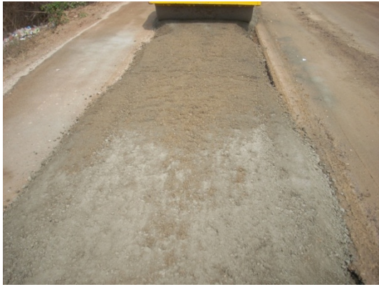
รูปที่ 95 การผสมคลุกเคล้าวัสดุผสมปูนซีเมนต์ไม่สม่ำเสมอควรตรวจสอบอุปกรณ์และห้องผสม
