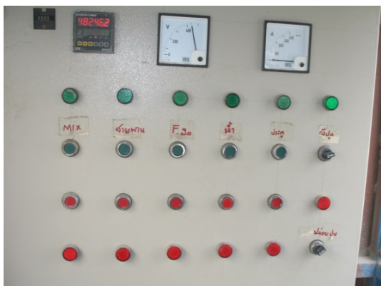
รูปที่ 13 ห้องควบคุมหรือตู้ควบคุม ใช้สำหรับควบคุมการเปิดปิดส่วนต่างๆของโรงผสม
