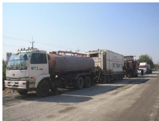
รูปที่ 32 ชุดเครื่องจักรประกอบด้วย รถบรรทุกน้ำใช้ลากจูง รถปูนซีเมนต์ และเครื่องจักรชุดตัดผสม
