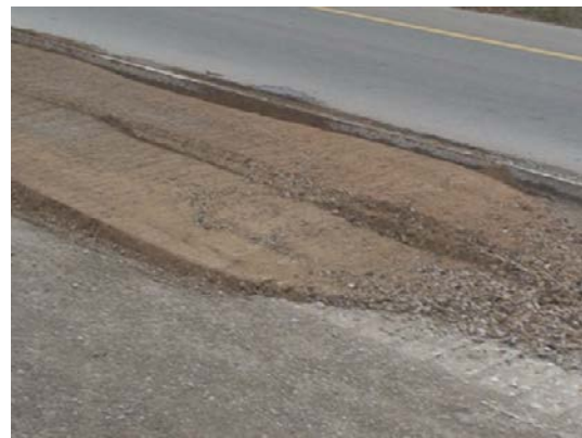
รูปที่ 105 การชุดตัดเหลื่อมทับรอยต่อเข้าไปในชั้นทางที่ปรับปรุงแล้ว
