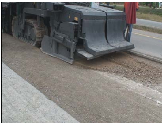
รูปที่ 105 การชุดตัดเหลื่อมทับรอยต่อเข้าไปในชั้นทางที่ปรับปรุงแล้ว
