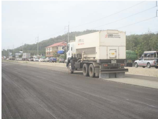
รูปที่ 28 การทำงานของรถโรยปูนซีเมนต์ลงบนผิวทางก่อนทำการชุดตัดผสม
