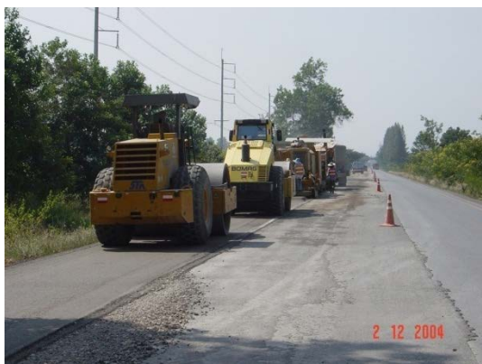
รูปที่ 101 การบดทับชั้นวัสดุผสมปูนซีเมนต์
