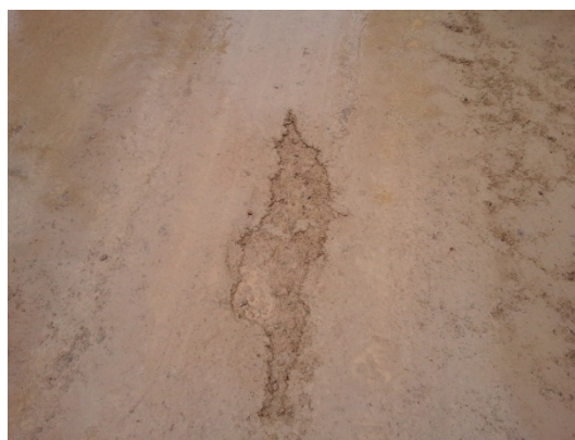
รูปที่ 100 การเสริมวัสดุผสมปูนซีเมนต์เป็นชั้นบางๆ ทำให้เกิดการหลุดร่อน
