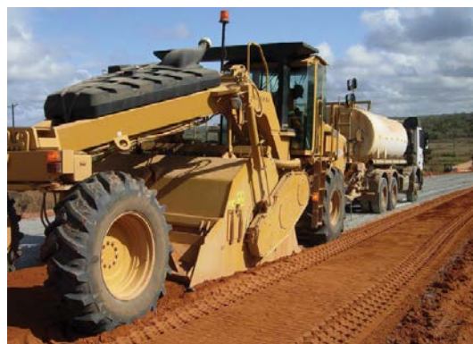
รูปที่ 20 เครื่องจักรสำหรับ Recycling CAT รุ่น RM500 ทำงานในลักษณะการปรับปรุงคุณภาพด้วยปูนซีเมนต์
