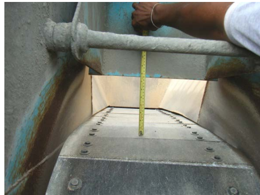
รูปที่ 51 บันทึกกระยะความสูงของการเปิดปากยั้ง
