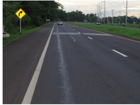
รูปที่ 104 การจัดรอยต่อตามยาวตรงกับแนวล้อรถทำให้เกิดความเสียหายกับชั้นผิวทาง
