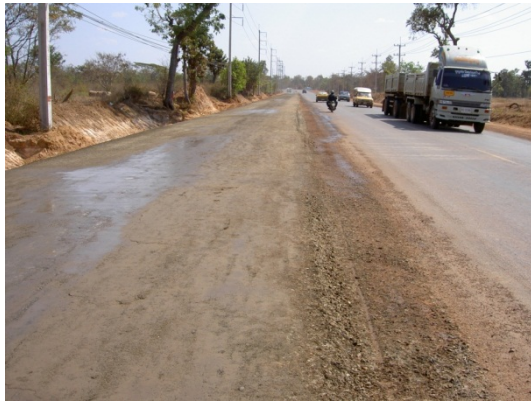
รูปที่ 98 การพ่นน้ำลงบนผิวหน้าของชั้นวัสดุผสมปูนซีเมนต์ที่ได้ก่อสร้างไว้แล้ว
