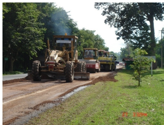
รูปที่ 101 การบดทับชั้นวัสดุผสมปูนซีเมนต์
