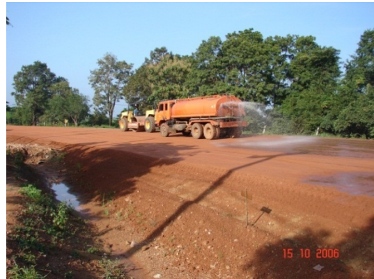
รูปที่ 98 การพ่นน้ำลงบนผิวหน้าของชั้นวัสดุผสมปูนซีเมนต์ที่ได้ก่อสร้างไว้แล้ว
