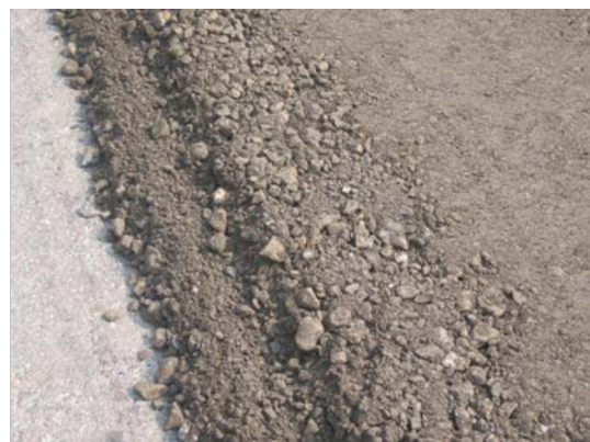
รูปที่ 97 การแยกตัว (Segregation) ของวัสดุส่วนหยาบและส่วนละเอียด
