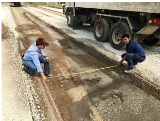
รูปที่ 82 การตรวจสอบความกว้าง ความลึก หลังจากการสอบเทียบ
