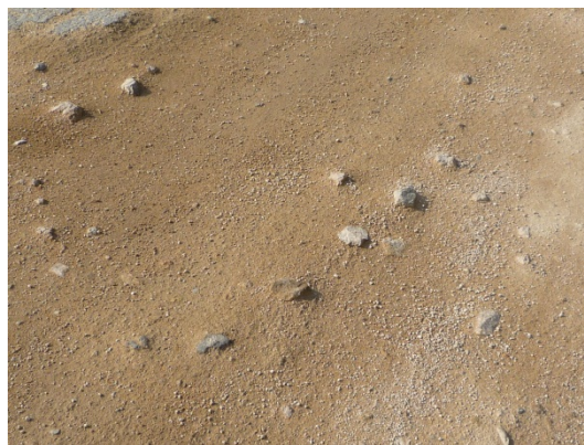
รูปที่ 93 วัสดุโตเกินขนาดที่อยู่ในชั้นทางที่ปรับปรุงคุณภาพด้วยปูนซีเมนต์ที่ได้ก่อสร้างไว้แล้ว
