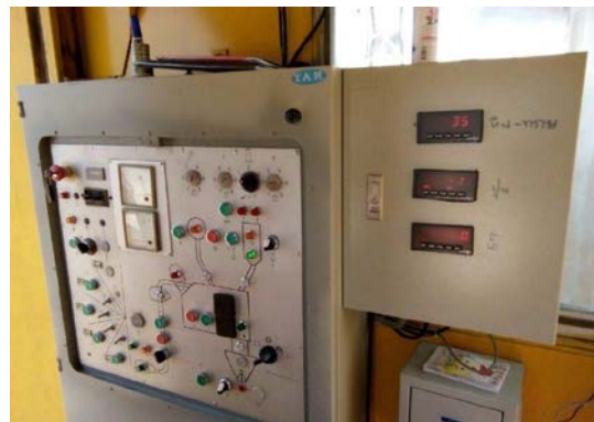
รูปที่ 4 เครื่องชั่งน้ำหนักวัสดุรวม พร้อมสายพานลำเลียง และตู้ควบคุมน้ำหนักของส่วนผสม
