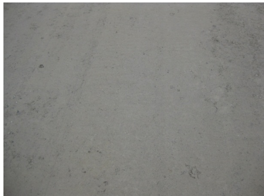
รูปที่ 99 ผิวหน้าของชั้นวัสดุผสมปูนซีเมนต์ที่เรียบเป็นมัน
