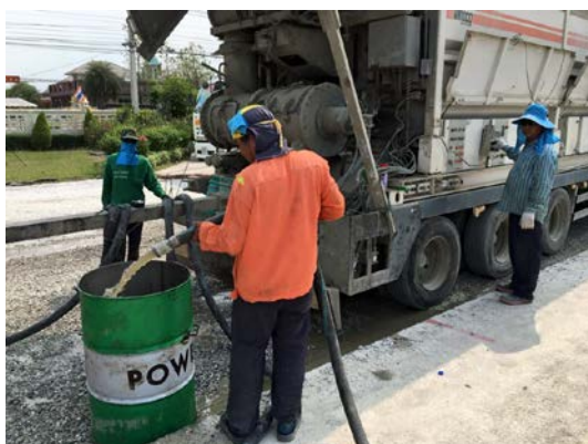
รูปที่ 80 การจับเวลาเพื่อหาอัตราการไหลของน้ำ
