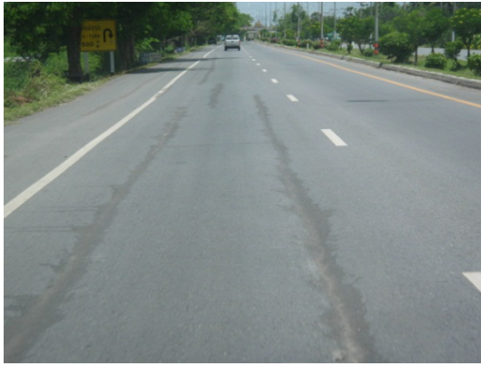
รูปที่ 104 การจัดรอยต่อตามยาวตรงกับแนวล้อรถทำให้เกิดความเสียหายกับชั้นผิวทาง
