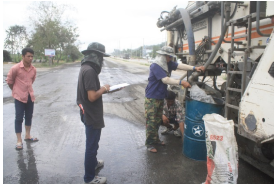
รูปที่ 69 การหาอัตราการไหลของน้ำ
