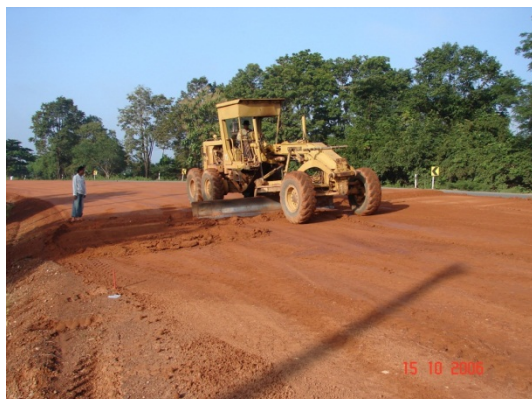
รูปที่ 102 การตัดแต่งรอยต่อตามขวางโดยใช้ใบมีดของรถเกลี่ยผสมกดลงไปบนชั้นทางแปลงที่ติดกัน
