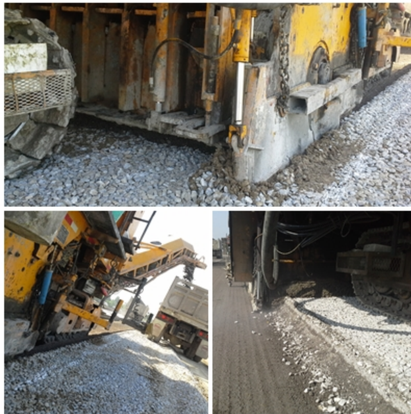
รูปที่ 40 การชุดตัดผสมวัสดุชั้นทาง
