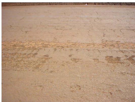
รูปที่ 100 การเสริมวัสดุผสมปูนซีเมนต์เป็นชั้นบางๆ ทำให้เกิดการหลุดร่อน
