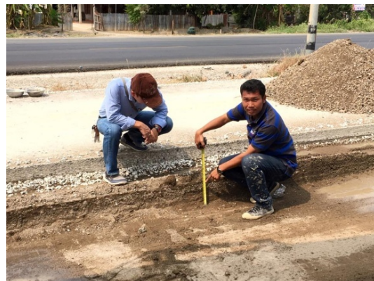
รูปที่ 82 การตรวจสอบความกว้าง ความลึก หลังจากการสอบเทียบ
