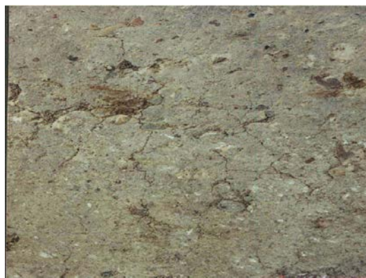
รูปที่ 106 การบ่มชั้นทางที่ปรับปรุงคุณภาพด้วยปูนซีเมนต์และรอยแตกเนื่องจากการหดตัว
