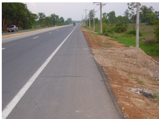
รูปที่ 107 การเกิดรอยแตกสะท้อนบนชั้นผิวทางเนื่องจากการหดตัวของชั้นพื้นทางที่ปรับปรุงคุณภาพด้วยปูนซีเมนต์
