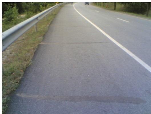
รูปที่ 107 การเกิดรอยแตกสะท้อนบนชั้นผิวทางเนื่องจากการหดตัวของชั้นพื้นทางที่ปรับปรุงคุณภาพด้วยปูนซีเมนต์
