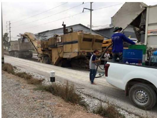
รูปที่ 79 การกำหนดจุดเริ่มต้นเพื่อเตรียมการสอบเทียบ
