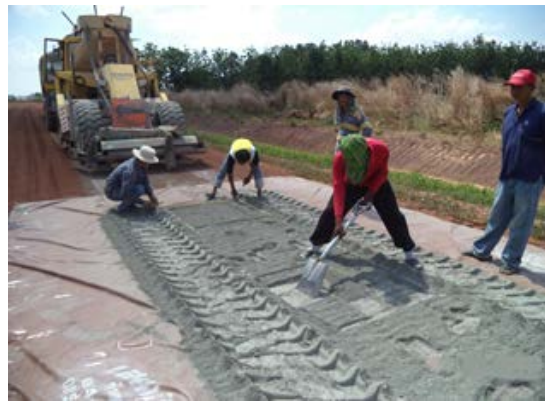
รูปที่ 31 การตรวจสอบปริมาณปูนซีเมนต์โดยใช้ผ้าใบ
