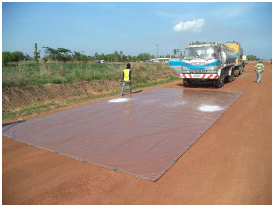
รูปที่ 31 การตรวจสอบปริมาณปูนซีเมนต์โดยใช้ผ้าใบ
