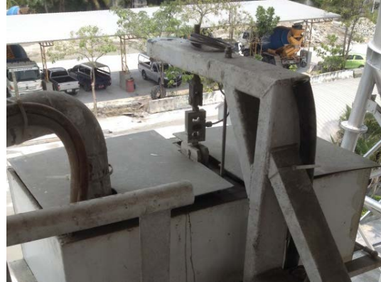
รูปที่ 49 การตรวจสอบหน้าจอและความพร้อมของโหลดเซลล์
