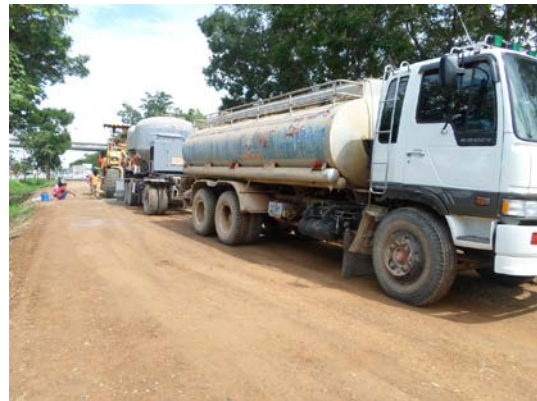
รูปที่ 25 ชุดเครื่องจักรประกอบด้วย รถบรรทุกน้ำใช้ลากจูง รถปูนซีเมนต์และเครื่องจักรชุดติดตั้งผสม
