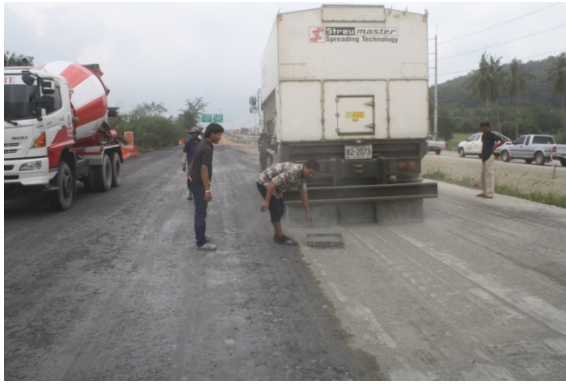
รูปที่ 30 การสุ่มตรวจสอบปริมาณปูนซีเมนต์โดยใช้ถาดรอง
