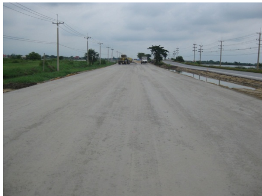
รูปที่ 99 ผิวหน้าของชั้นวัสดุผสมปูนซีเมนต์ที่เรียบเป็นมัน
