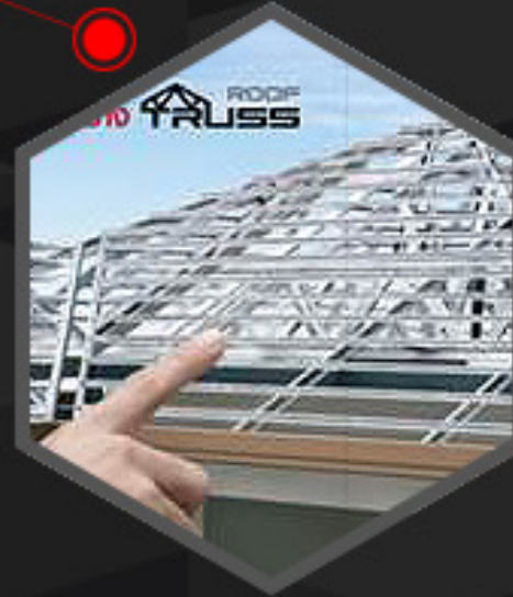
โครงหลังคา
