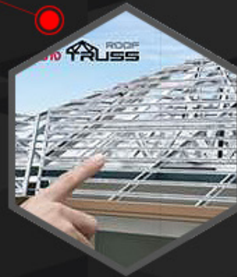
โครงหลังคา
