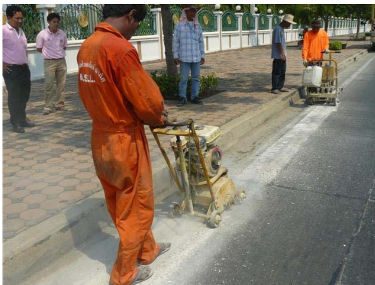
ภาพที่ 31 ภาพแสดงการใช้เครื่องจักรกลลบเครื่องหมายจราจรบนผิวทาง (แบบหยาบและละเอียด)
