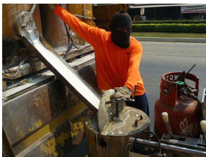
ภาพที่ 35 ภาพแสดงการนำวัสดุเทอร์โมพลาสติกหลอมเหลว เทใส่ในเครื่องตีเส้นจราจร
