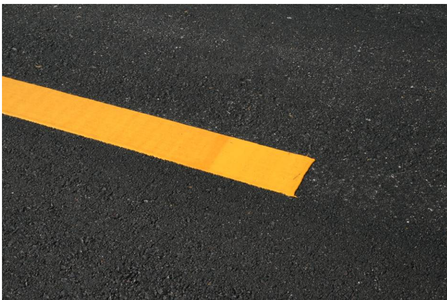
ภาพที่ 44 การตีเส้น สีมีการต้มอุณหภูมิไม่ถึงมาตรฐานที่กำหนดไว้ ทำให้สีมีลักษณะเป็นหลุมลงไป ไม่เรียบ
