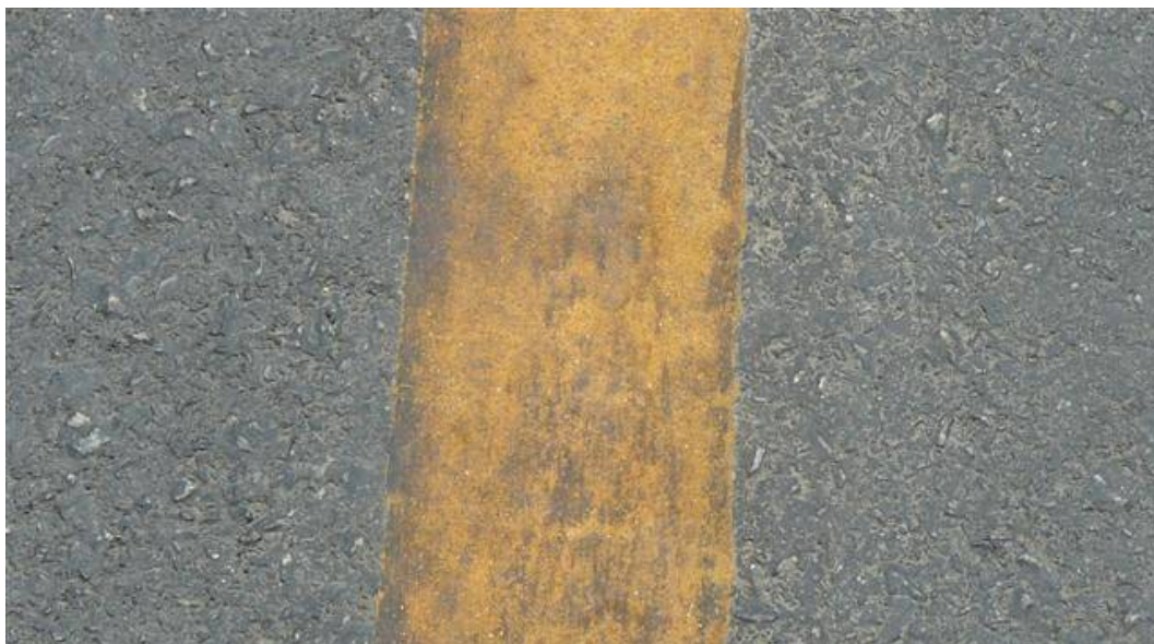
ภาพที่ 46 การตีเส้นจราจรหากเว้นระยะเวลาหลังจากปูผิวไม่น้อยเกินไปจะทำให้สีหมองดำเร็วกว่าปกติ การตีเส้นจราจรที่ดีควรที่จะเว้นระยะเวลาไม่น้อยกว่า 7 วัน หลังจากวันที่ปูผิวแอสฟัลท์แล้วเสร็จ
