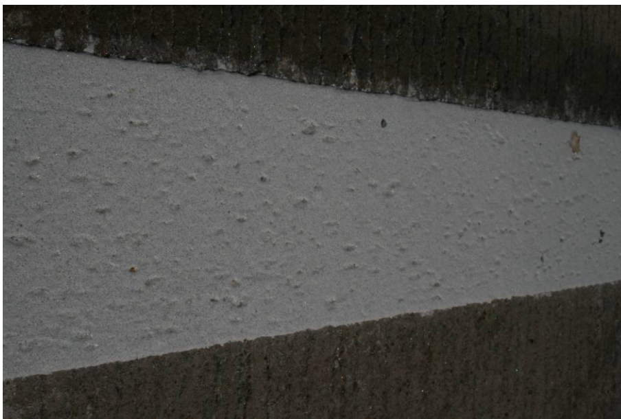
ภาพที่ 44 การตีเส้น สีมีการต้มอุณหภูมิไม่ถึงมาตรฐานที่กำหนดไว้ ทำให้สีมีลักษณะเป็นหลุมลงไป ไม่เรียบ
