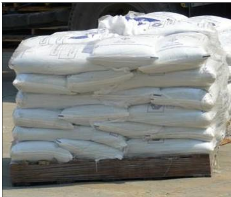
ภาพที่ 7 การกองเก็บวัสดุ ต้องมีหมอนรอง มีโรงเก็บและผ้าใบคลุมให้เรียบร้อย
