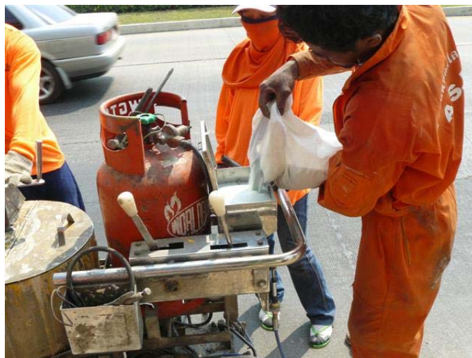
ภาพที่ 36 ภาพแสดงการเทลูกแก้วลงในเครื่องตีเส้นจราจร
