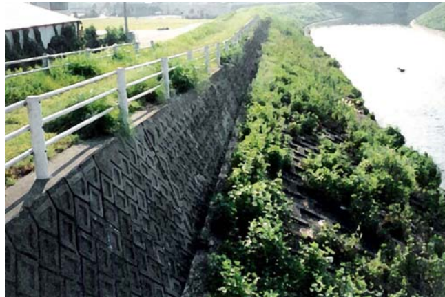
รูปที่ 14: การป้องกันตลิ่งโดยใช้เขื่อนป้องกันตลิ่ง
