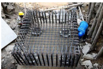
รูปที่ 1.5 การเสริมเหล็กเดียวในเสาเข็ม
