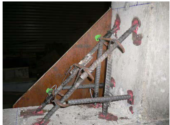
ชั้นที่ 1 เสียบเหล็กโครงในรูเจาะแล้วฝังยึดด้วยกาวอีพอกซี
