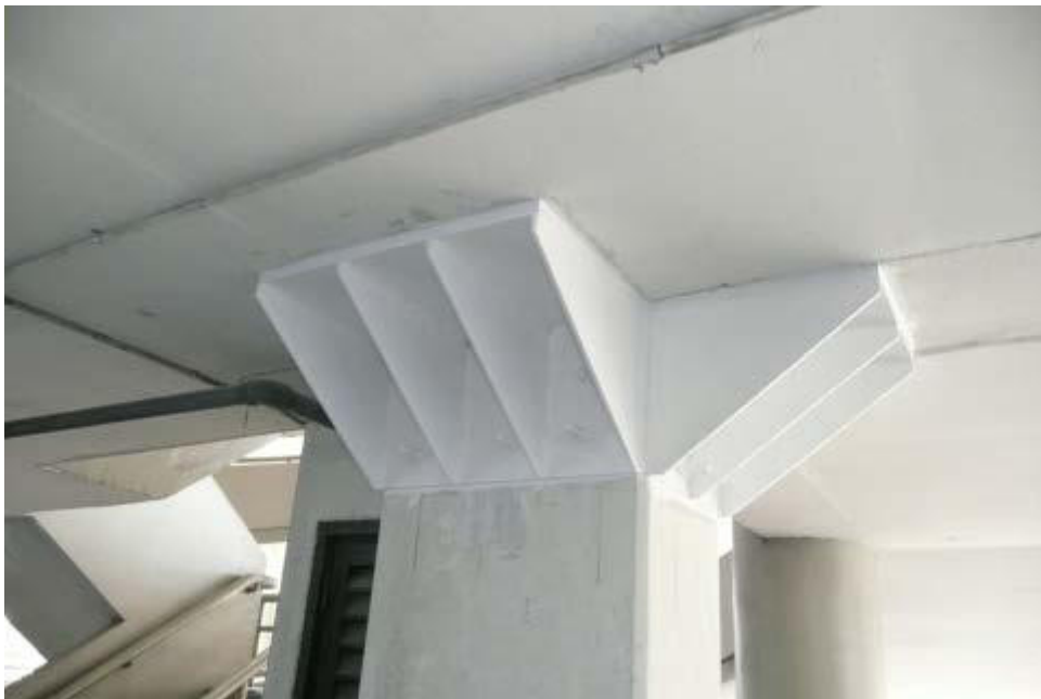
รูปที่ 6.27 ตัวอย่างการติดตั้งบ่าเหล็กเพื่อป้องกันการวิบัติเฉือนทะลุในพื้นไร้คาน
