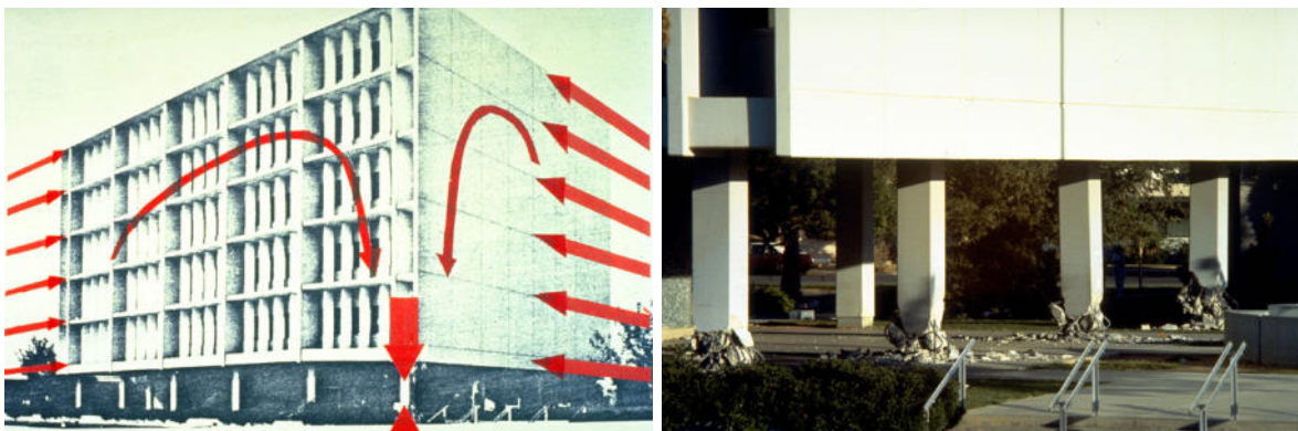
รูปที่ 2.2 (ก) เสวรับแรงอัดเนื่องจากแผ่นดินไหว และอัดระเบิดที่โคนเสว เนื่องจาก 1979 Imperial Valley Earthquake ขนาด 6.4
