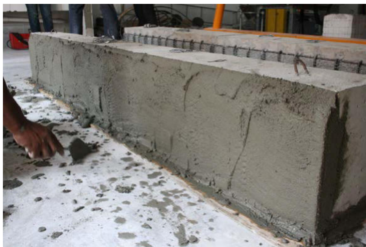
รูปที่ 6.17 การฉาบปูนบนโครงเหล็กลดตาข่าย
