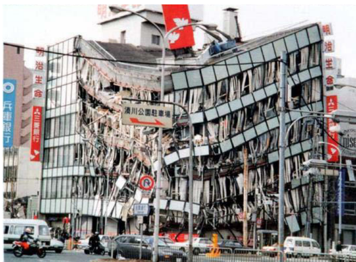
รูปที่ 2.2 (ข) การวิบัติของเสาเนื่องจากการเฉือน จนเหนี่ยวนำให้เกิดการวิบัติของอาคาร สำหรับ 1995 Kobe Earthquake ขนาด 8 เนื่องจากปริมาณเหล็กเสริมตามขวางที่น้อยเกินไป (ที่มา : https://nisee.berkeley.edu/elibrary/index.jsp )
