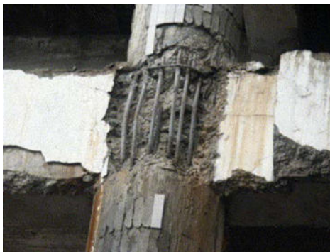
รูปที่ 3.2 การวิบัติของข้อต่อคานเสา
