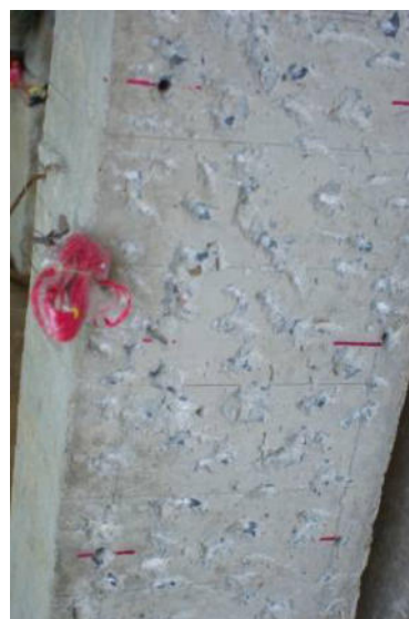
รูปที่ 6.11 (ก) สกัดหยาบผิวคอนกรีตในบริเวณที่จะเสริมเฟอโรซีเมนต์
