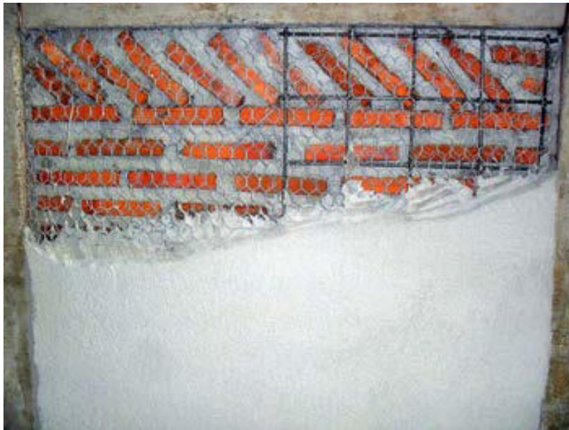
รูปที่ 6.9 การใช้เฟอร์โรซีเมนต์เสริมกำลังผนังอิฐ
