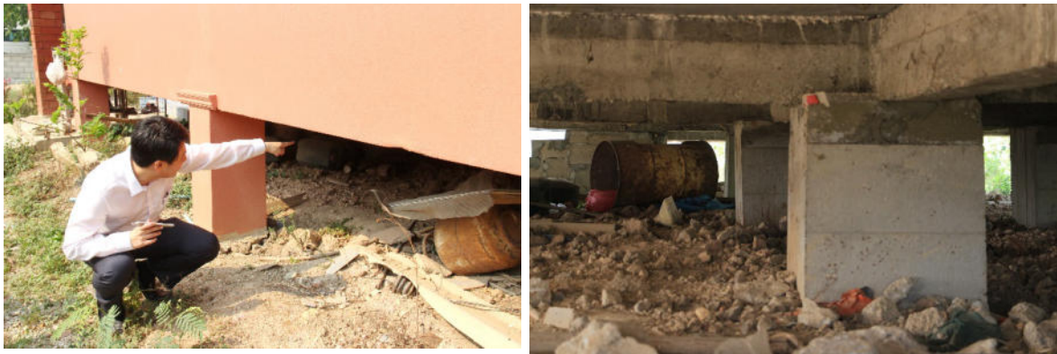
รูปที่ 2.9 (ก) ลักษณะของตอม่อในบ้านเรือนทั่วไปในประเทศไทย โดยในรูปเป็นบ้านที่ได้รับความเสียหายจากเหตุแผ่นดินไหวที่เชียงรายเมื่อ พ.ศ.2557 และได้รับการเสริมกำลังโดยการขยายหน้าตัดแล้ว
