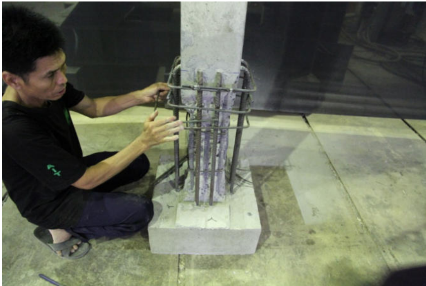
รูปที่ 7.7 (ก) การเสริมกรงเหล็กรอบเสา
