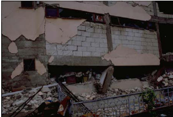
รูปที่ 2.11 (ก) การวิบัติเนื่องจากพฤติกรรมเสาสั้น กรณีนี้มีกำแพงชั้น และสร้างช่องเปิดไว้ ทำให้ความชะลุดของเสาลดลง สำหรับ 1999 Turkey earthquake ขนาด 7.4
