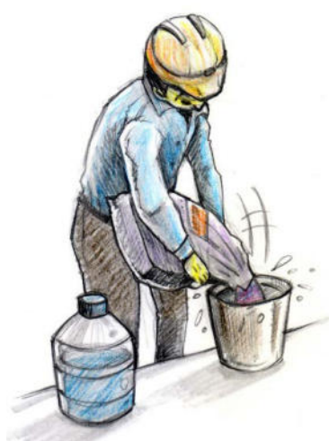
รูปที่ 6.1 (จ) ผสมปูนซีเมนต์หัตถ์น้อย สำหรับเป็นวัสดุเชื่อมประสานแผ่นเหล็ก และเสาคอนกรีต
