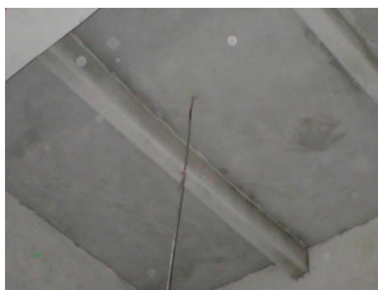
ขั้นที่ 4 คานชอยเฟอโรซีเมนต์เสร็จเรียบร้อยแล้ว
