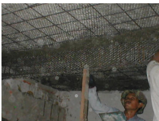
ขั้นที่ 3 การฉาบมอร์ตาร์บนโครงเหล็ก
