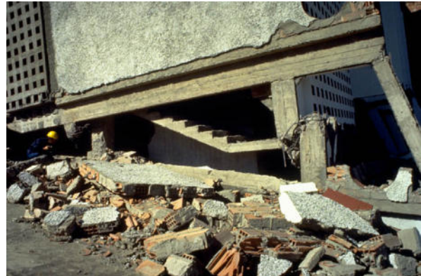
รูปที่ 2.11 (ข) การวิบัติเนื่องจากพฤติกรรมเสาสั้น กรณีนี้มีพื้นบันไดมาเชื่อมต่อที่กลางเสา ทำให้ความชะลุดของเสาลดลง สำหรับ 1980 Algeria Earthquake ขนาด 7.7
