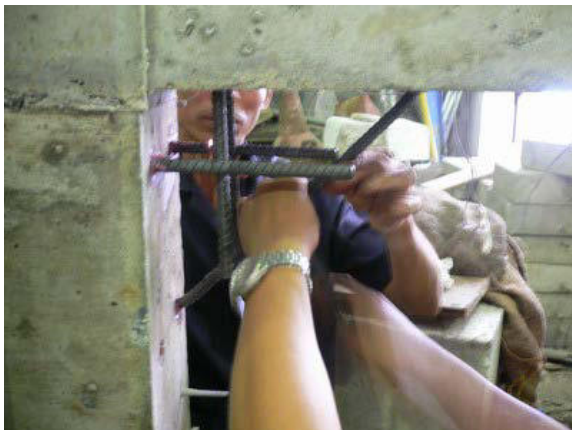
ชั้นที่ 1 เสียบเหล็กโครงในรูเจาะแล้วฝังยึดด้วยกาวอีพอกซี
