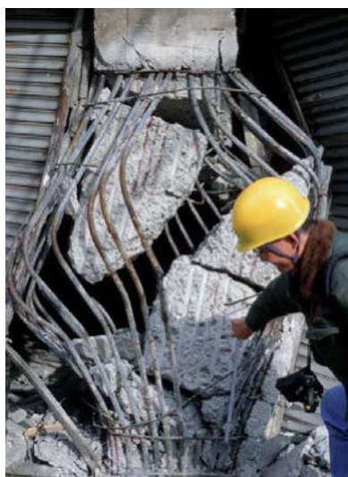
รูปที่ 2.2 (ข) การวิบัติของเสาเนื่องจากการเฉือน จนเหนี่ยวนำให้เกิดการวิบัติของอาคาร สำหรับ 1995 Kobe Earthquake ขนาด 8 เนื่องจากปริมาณเหล็กเสริมตามขวางที่น้อยเกินไป (ที่มา : https://nisee.berkeley.edu/elibrary/index.jsp )
