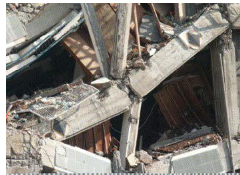
รูปที่ 3.2 การวิบัติของข้อต่อคานเสา
