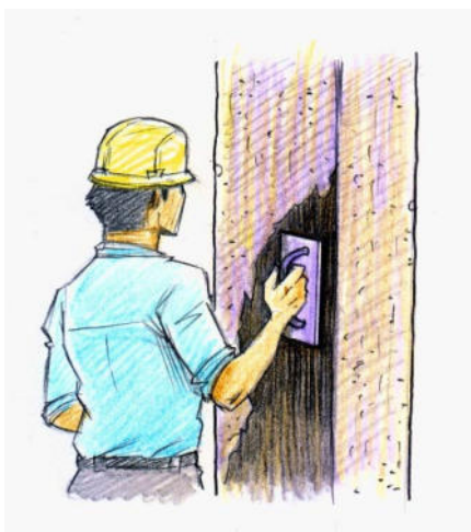
รูปที่ 6.7 (ช) จับเช็ยมและฉาบผิว
