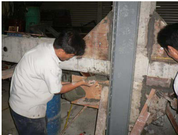
ขั้นที่ 2 เตรียมแบบหล่อแล้วเทปูนเกร้าท์
