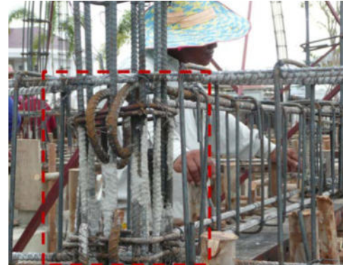
รูปที่ 3.1 ข้อต่อของอาคารคอนกรีตเสริมเหล็กที่ไม่ได้เสริมเหล็กต้านทานแผ่นดินไหว
