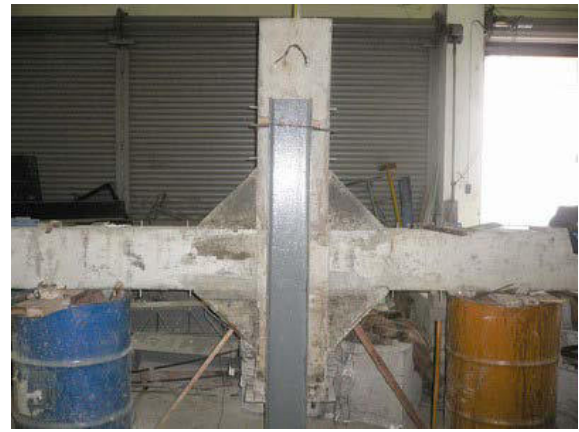
ขั้นที่ 3 รอจนกว่าปูนเกร้าท์จะแข็งตัวจึงถอดแบบหล่อ
