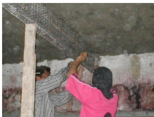
ขั้นที่ 2 การยกติดตั้งใต้พื้น
