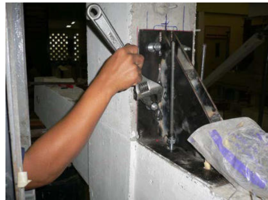
การขันน็อตเพื่อยึดบั้งเหล็กกับเสาคอนกรีต
