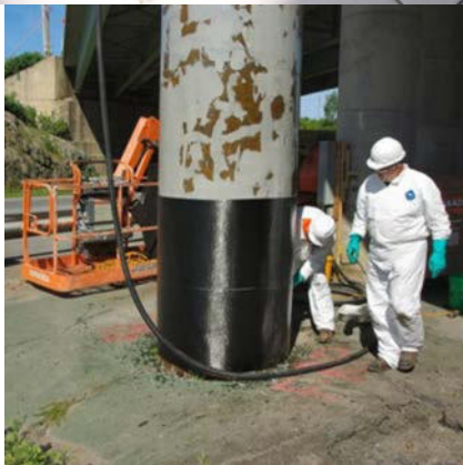
รูปที่ 6.5 การใช้แผ่นคาร์บอนไฟเบอร์เสริมกำลังเสา
