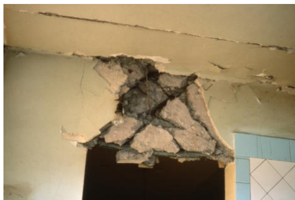
รูปที่ 4.1 (ก) บริเวณปลายคานเป็นบริเวณที่ได้รับความเสียหายมาก
