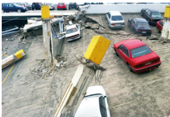
รูปที่ 5.1 (ก) การวิบัติแบบเฉือนทะลุ ในแผ่นพื้นคอนกรีต (ที่มา : http://www.scielo.br และ https://nees.org )
