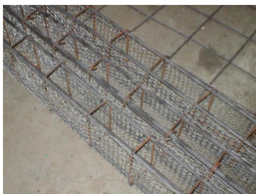
ขั้นที่ 1 การเตรียมโครงเหล็กพร้อมลวดกรงไก่
