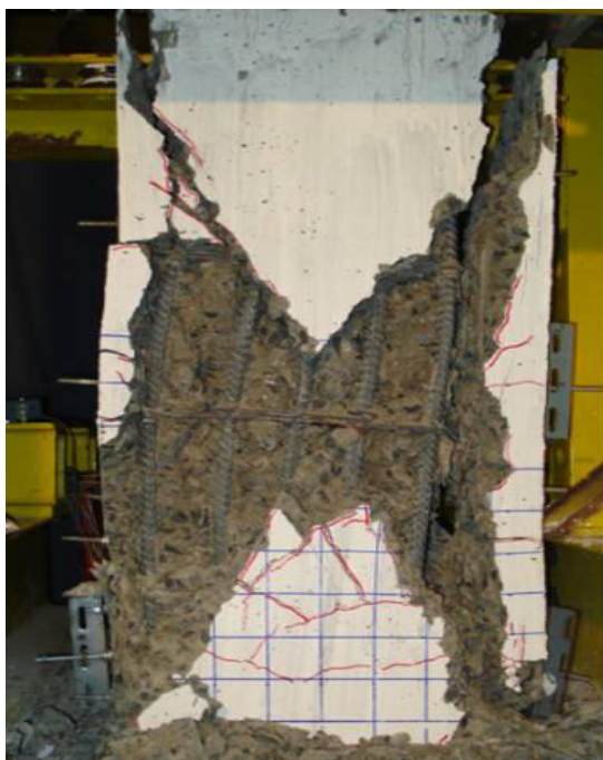
เสาที่ไม่ได้พันแผ่นคาร์บอนไฟเบอร์
