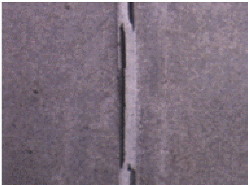
รูปที่ 6: รูปการวิบัติของวัสดุอุดรอยต่อ
