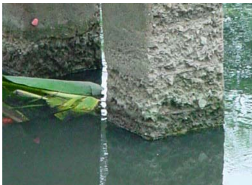
รูปที่ 3: รูปการสลายตัวของคอนกรีต
