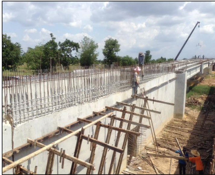
รูปที่ 3.4-2 งานติดตั้งค้ำยันสะพาน
