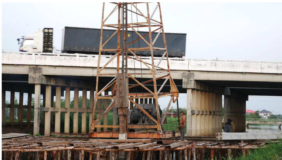
รูปที่ 3.4-3 งานติดตั้งปั้นจั่น
