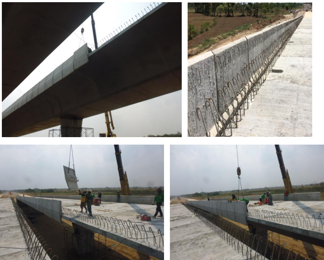
รูปที่ 3.4-6 งานติดตั้งแผ่น Precast ราวสะพาน
