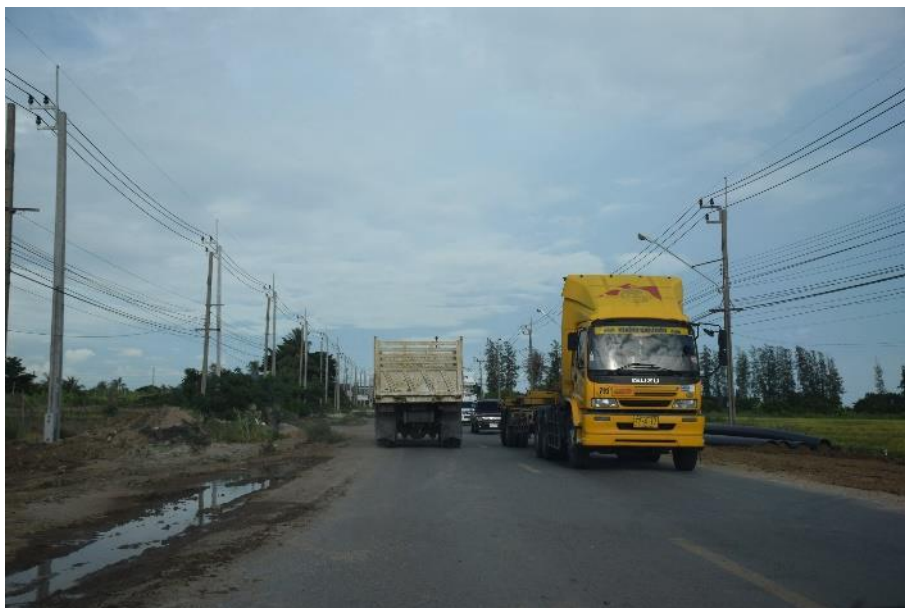
รูปที่ 1.1-10 พื้นผิวถนนที่ต่างระดับและเป็นหลุมบ่ออาจเป็นอันตรายต่อผู้ใช้ทางเวลากลางคืน
