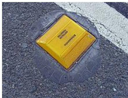
รูปที่ 2.4-12 ปุ่มเครื่องหมายจราจรบนพื้นทาง
