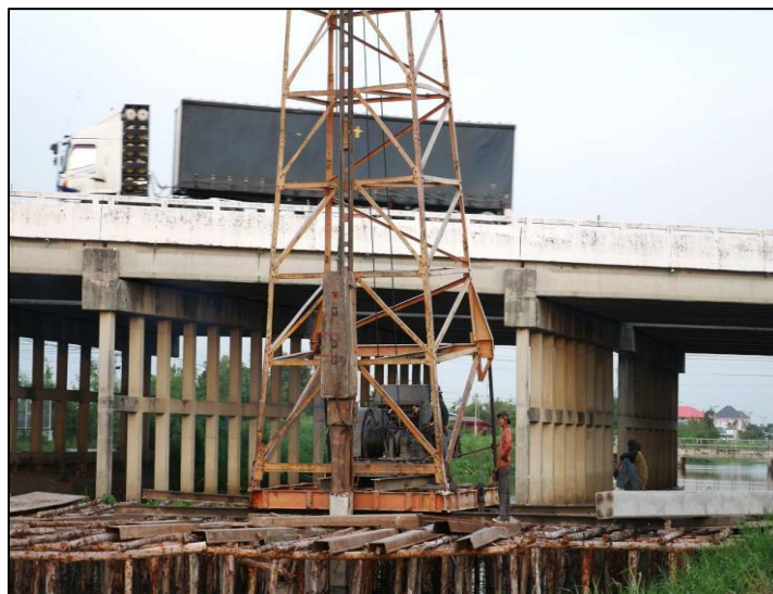
รูปที่ 3.2-6 นั่งร้านไม้สำหรับปั้นจั่นตอกเสาเข็ม
