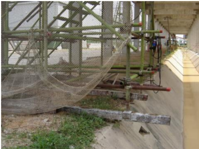
รูปที่ 3.4-5 การติดตั้งนั่งร้านสำหรับพื้นที่ลาดเอียงไม่ได้ระดับ
