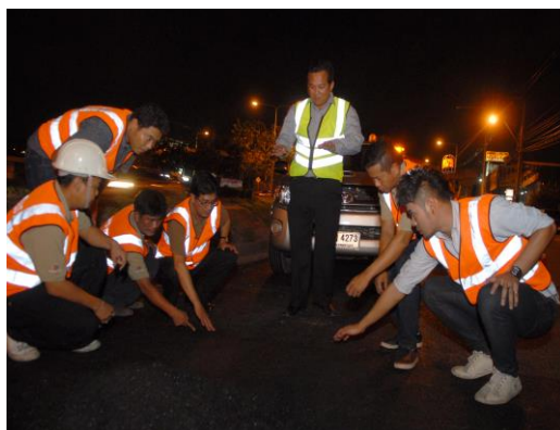
รูปที่ 4.4 ภาพเจ้าหน้าที่ตรวจพบส่วนผสมพาราสเลอรี่ที่เกิดการแยกตัวจำเป็นต้องตักส่วนผสมนี้ออกไป
