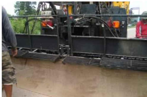
รูปที่ 4.13 เจ้าหน้าที่กำลังติดตั้งกระสอบปาดหลัง
