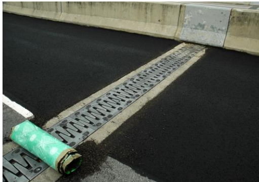
รูปที่ 4.7 ภาพแสดงการใช้แผ่นกระดาษแอสฟัลต์ ป้องกันบริเวณที่ไม่ต้องการฉาบผิว พาราสเลอรีซีล
