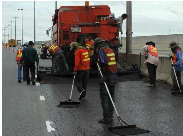
รูปที่ 4.5 ภาพคนงานใช้อุปกรณ์เพื่อลบรอยครูดบนผิวทางที่เกิดจากหินเม็ดใหญ่และทำผิวทางเรียบ
