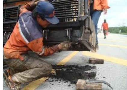
รูปที่ 4.11 ทำความสะอาดคราบของส่วนผสมที่ค้างอยู่ตามขอบยาง และแกนของใบกวบในเครื่องฉาบ (Spreader)
