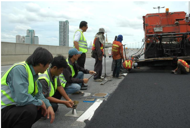
รูปที่ 5.11 เจ้าหน้าที่กำลังตรวจสอบและแก้ไขซ่อมแซมอุปกรณ์ให้พร้อมก่อนอนุญาตให้ดำเนินการก่อสร้างได้
