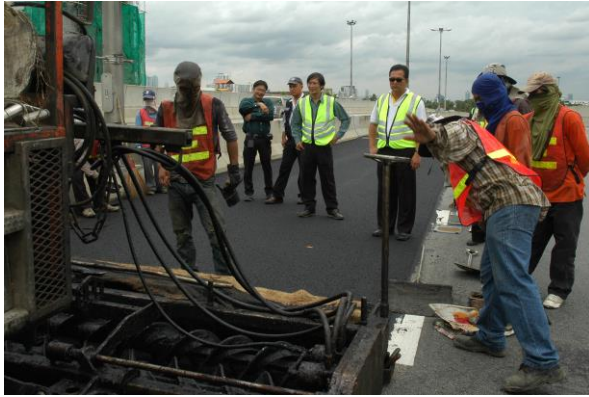
รูปที่ 4.2 ภาพผู้ควบคุมงานกำลังตรวจสอบ เครื่องจักรและเครื่องมือให้พร้อมใช้งาน ทุกครั้งก่อนดำเนินการก่อสร้าง
