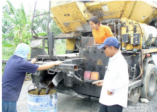
รูปที่ 1 เครื่องจักรงานพาราสลลอรี่ซีลขณะสอบเทียบแอสฟัลต์
