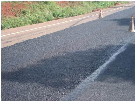
รูปที่ 4.5 ภาพแสดงให้เห็นรอยต่อตามยาวที่ไม่ดี สามารถมองเห็นรอยต่อที่เป็นสันนูน ไม่เรียบชัดเจน
