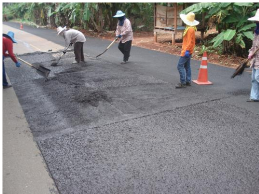
รูปที่ 4.8 ภาพแสดงการแก้ไขรอยต่อตามขวาง โดยการตัดเป็นแนวตรง และเก็บส่วนที่ เกินออกไป
