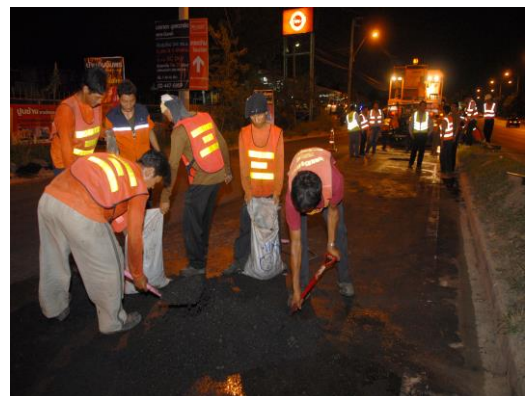
รูปที่ 4.4 ภาพเจ้าหน้าที่ตรวจพบส่วนผสมพาราสเลอรี่ที่เกิดการแยกตัวจำเป็นต้องตักส่วนผสมนี้ออกไป
