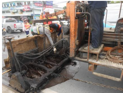
รูปที่ 5.5 ภาพการเก็บตัวอย่างและการทดลองหาความชื้นเหลว (Consistency) ของส่วนผสมพาราสเลอรี่ซีล
