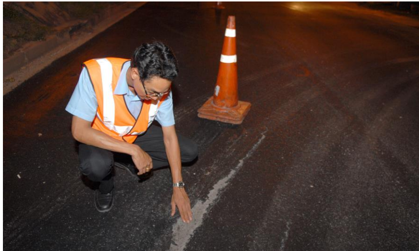
รูปที่ 5.10 ภาพความเสียหายของผิวทางหลังจากเปิดการจราจร
