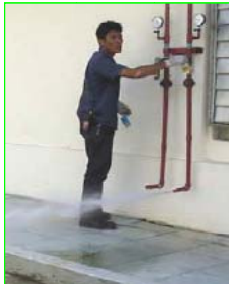
รูปที่ 19.8 แสดงการทดสอบระบบหัวกระจายน้ำดับเพลิง
