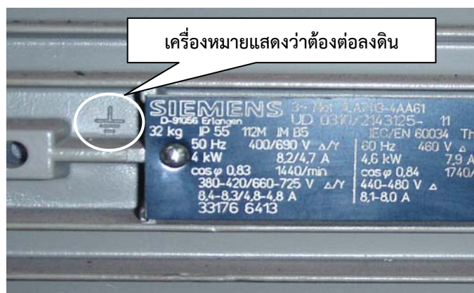
รูปที่ 20.16 การแสดงเครื่องหมายว่าต้องต่อลงดินของอุปกรณ์ไฟฟ้า
