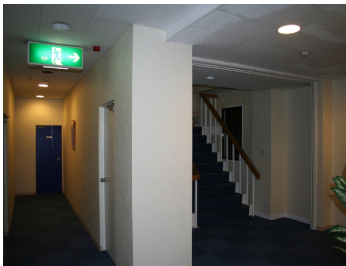
รูปที่ 19.17 แสดงการใช้ม่านทึบไฟแทนผนัง ซึ่งม่านจะเคลื่อนลงมาปิดช่องบันไดได้
