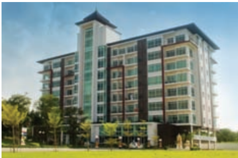
โครงการ Touch Hill Place Condominium
