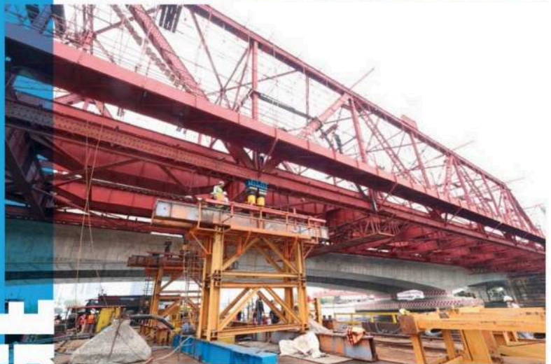
รูปที่ 5 การติดตั้งช่วงแขวนของสะพานพระราม 6 ด้วยเทคนิคสุดท้าย แต่ทรงไว้ซึ่งประสิทธิภาพ
