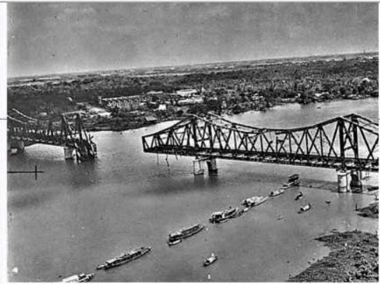
รูปที่ 2 สะพานพระราม 6 ตัวเดิม เมื่อสร้างเสร็จ (รูปด้านซ้าย) และสะพานเมื่อครั้งถูกระเบิดทางอากาศครั้งใหญ่จนวิบัติในสงครามโลกครั้งที่ 2 เมื่อวันที่ 7 กุมภาพันธ์ ค.ศ. 1945 (ที่มา : State Railway of Thailand, 1953)
