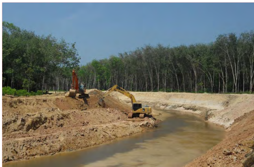
รถขุดไฮดรอลิก ขนาด 200 แรงม้า สามารถขุดลอกได้ 800 ลบ.ม./วัน
