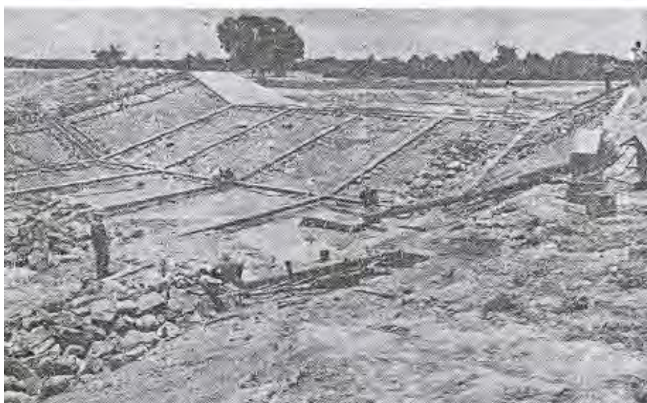
รูป งานก่อสร้างอาคารระบายน้ำล้นแบบรางเท
