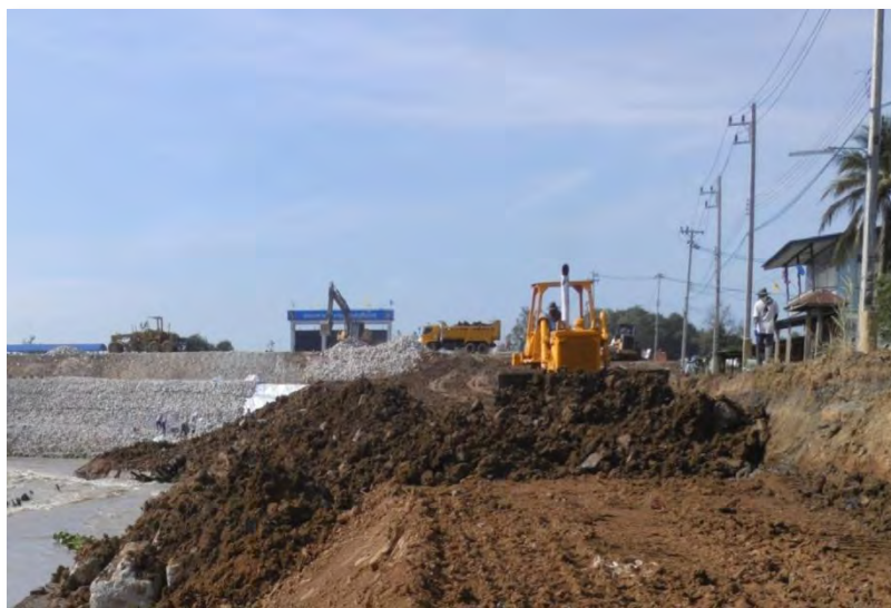
รถดันดินตะขาบ ขนาด 140 แรงม้า สามารถทำงานได้ 560 ลบ.ม./วัน
