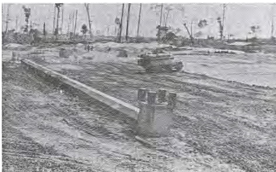
รูป งานก่อสร้างท่อระบายน้ำจากอ่างเก็บน้ำ
