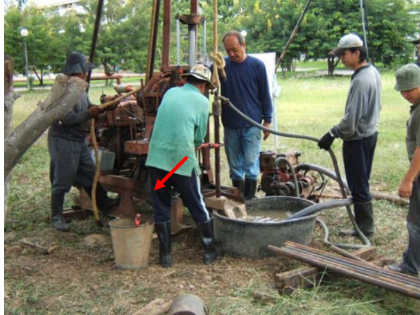
รูปที่ 2 : แสดงเครื่องเจาะสำรวจแบบฉีดล้าง ( Wash Boring )
