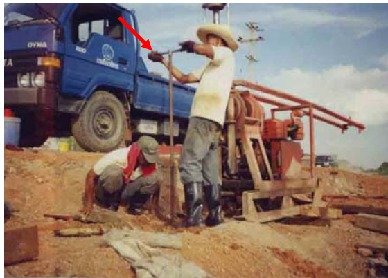
รูปที่ 1 : แสดงการเจาะสำรวจโดยใช้ Hand Auger
