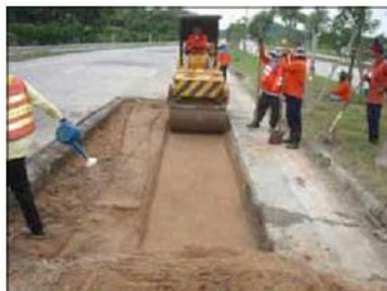
ง) การบดอัดชั้นโครงสร้างทางให้ได้ความแน่นตามมาตรฐาน
