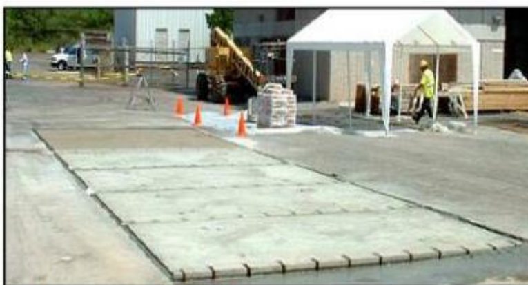
รูปที่ 2.4-8 แผ่นคอนกรีต Kwik Slab ที่ดำเนินการซ่อมเสร็จแล้ว (ที่มา: www.kwikslab.com )
