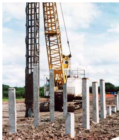
รูปที่ ข-4 ตัวอย่างการก่อสร้างคันทางเสาเข็มตอกปูพรม
