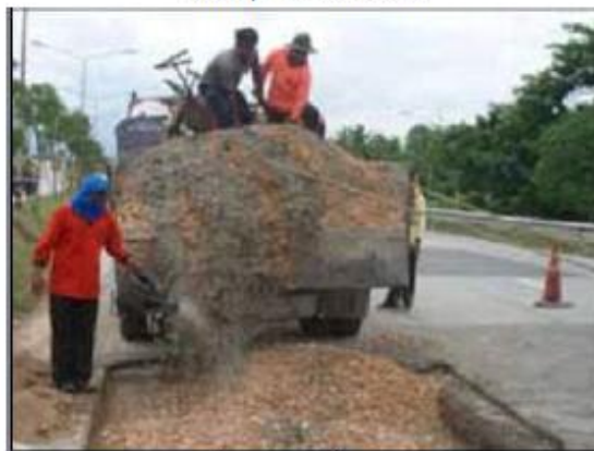
ค) การนำวัสดุที่ได้มาตรฐานขึ้นมาเป็นโครงสร้างทาง
