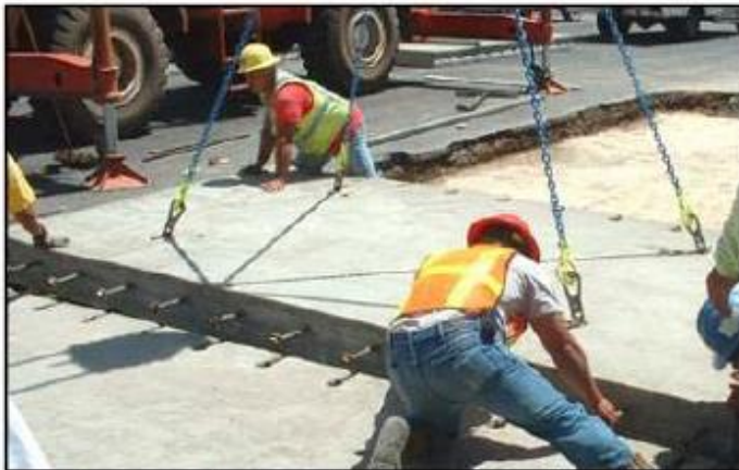
รูปที่ 2.4-3 การติดตั้งแผ่นคอนกรีต Kwik Slab (ที่มา: www.kwikslab.com )
