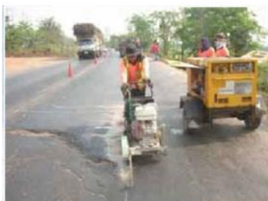
ก) การตัดผิวทางตามแนวที่กำหนดไว้สำหรับการซ่อม
