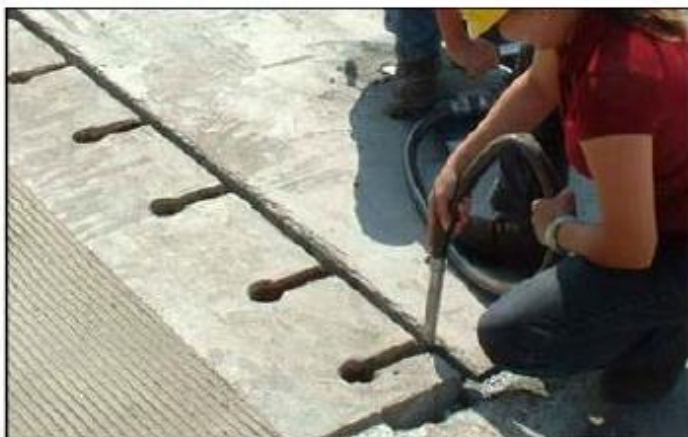
รูปที่ 2.4-6 การฉีดวัสดุเกรทท์กำลังสูงเพื่ออุดรอยต่อ (ที่มา: www.kwikslab.com )
