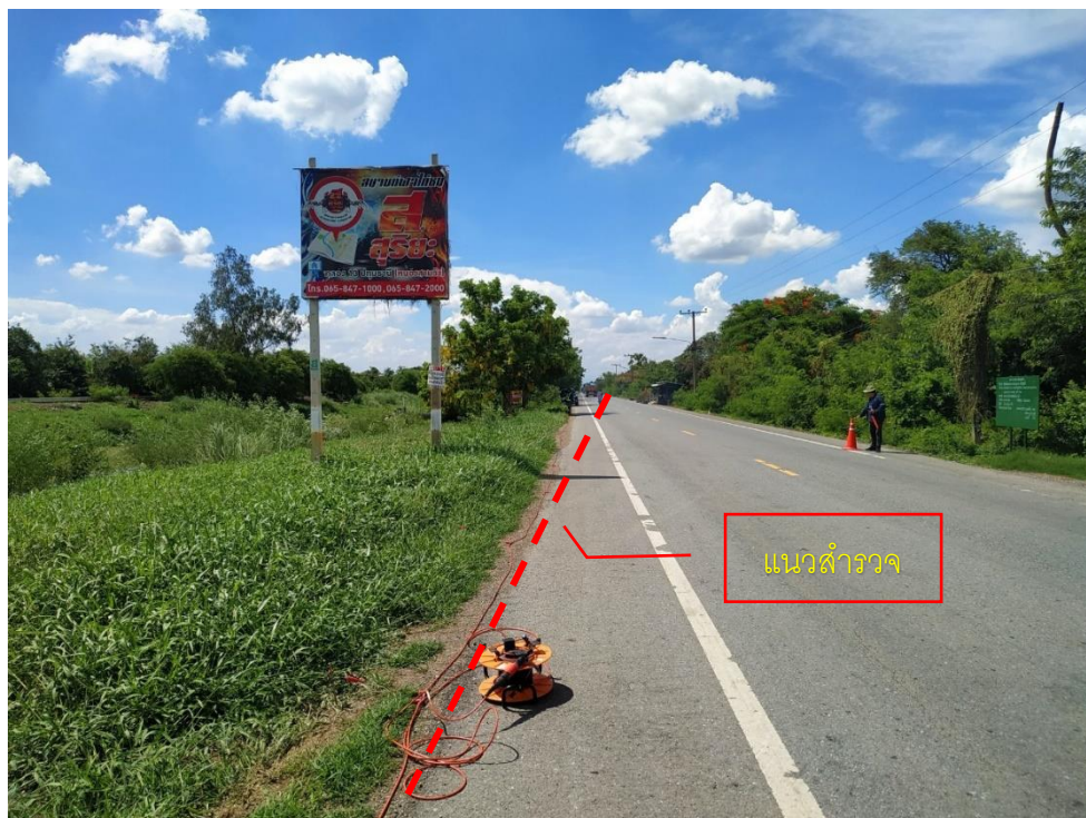
รูปที่ ซ-20 การติดตั้งเครื่องมือสำรวจ กม.3+500
