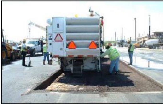
รูปที่ 2.4-2 ภาพเครื่องจักรกำลังทำการบดอัดพื้นที่สำหรับรับแผ่นคอนกรีต (ที่มา: www.kwikslab.com )
