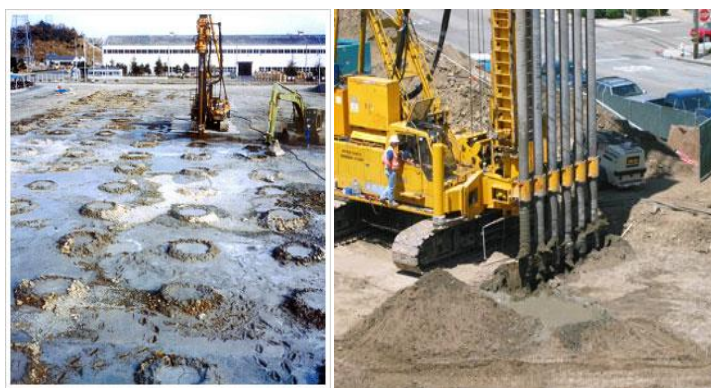
รูปที่ ข-7 ตัวอย่างการก่อสร้างเสาเข็มดินซีเมนต์
