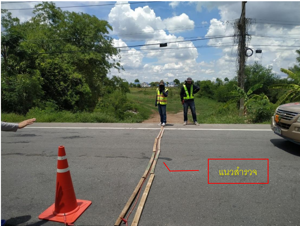
รูปที่ ซ-19 การติดตั้งเครื่องมือสำรวจ กม.1+700 (Cross Section)
