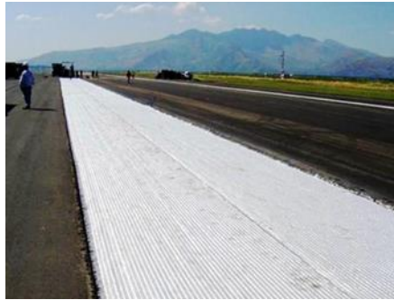
รูปที่ ข-5 ตัวอย่างการใช้วัสดุรับแรงดึง
