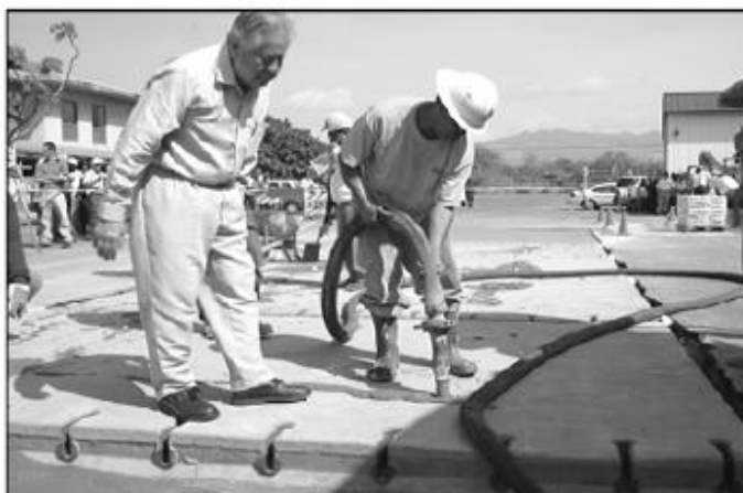
รูปที่ 2.4-5 แสดงการอัดฉีดเกราท์ผ่านรูที่เตรียมไว้ (ที่มา: www.kwikslab.com )
