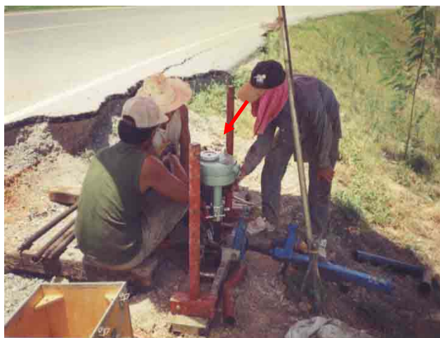
รูปที่ 7.6 การทดสอบกำลังรับแรงเฉือนแบบไม่ระบายน้ำในที่ (In Situ Field Vane Shear Test แบบ Geonor)
