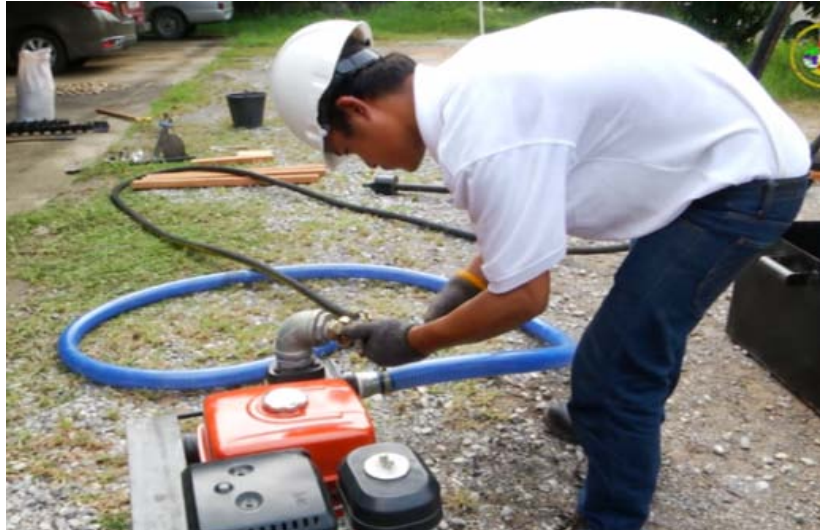
รูปที่ 6.8 การเตรียมปั้มน้ำต่อสายยางทนความดันเข้ากับหัวหมุนน้ำ
