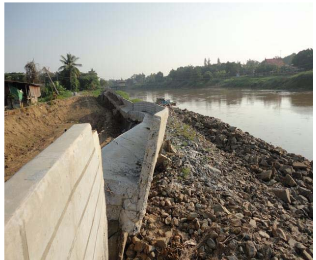
รูปที่ 1.1 และ 1.2 ตัวอย่างความเสียหายของเขื่อนป้องกันตลิ่ง
