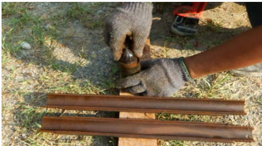
รูปที่ 6.21 การใส่ตะกร้อดักทรายในกระบอกลำ
