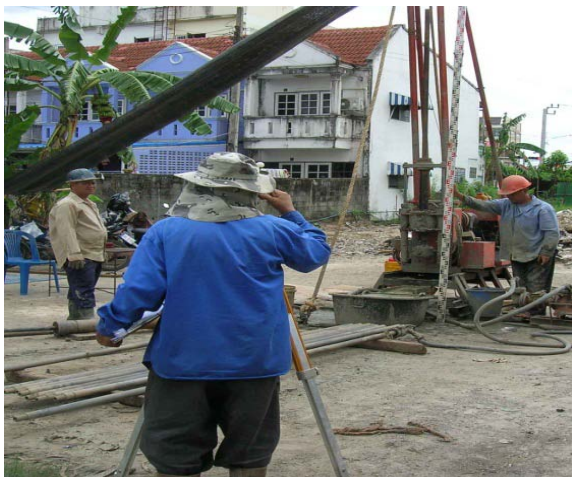
รูปที่ 3.1 เก็บค่าระดับปากหลุมเจาะ
