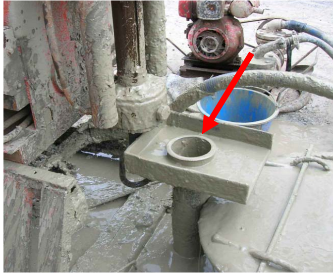
ท่อปลูกเหล็กกันดินพัง (Casing)
