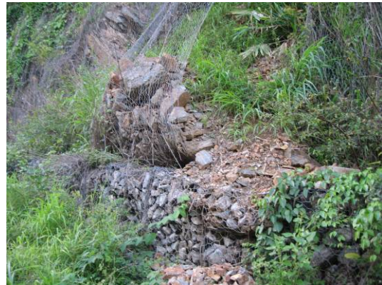
(ง) การฉีกขาดบริเวณ Toe ของระบบ Rock Fall Netting อันเนื่องมาจากการบำรุงรักษา(ไม่เอาก้อนหินที่ร่วงมากองทับถมออก)
