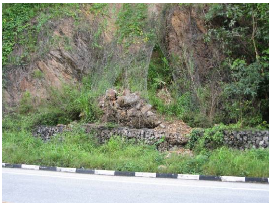
(ค) การฉีกขาดบริเวณ Toe ของระบบ Rock Fall Netting อันเนื่องมาจากการบำรุงรักษา(ไม่เอาก้อนหินที่ร่วงมากองทับถมออก)
