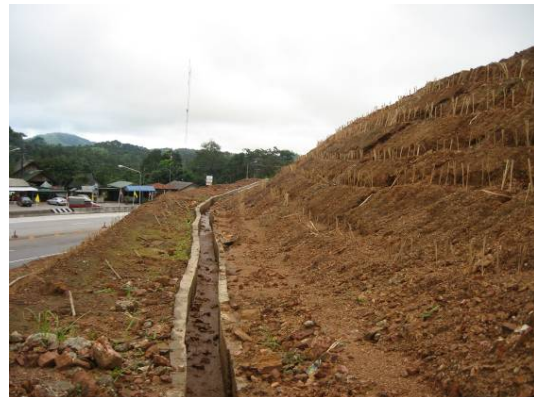
(ง) ตะกอนดินลงมาทับถมเต็มราง Interceptor
