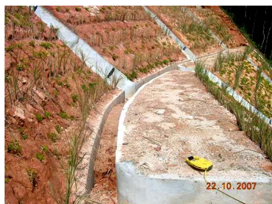
(ฉ) ตะกอนดินใน Interceptor
