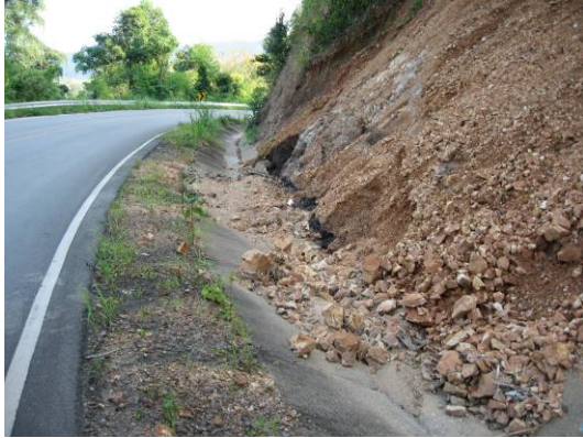
(ก) การร่วงหล่นของก้อนหินอันเกิดจาก การชะล้างของ Back Slope
