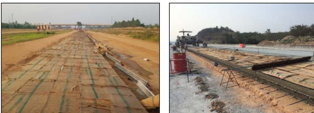
รูปที่ 95 การคลุมผิวคอนกรีตด้วยกระสอบที่เปียกชื้น
