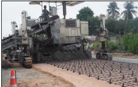
เครื่องปูคอนกรีตแบบเลื่อน
