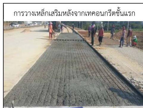
รูปที่ 130 การวางเหล็กเสริม
