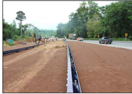
รูปที่ 115 แบบหล่อคอนกรีตที่เหมาะสม
