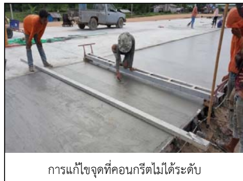
การวัดสอบความเรียบตามแนวขวาง
