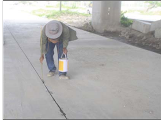
รูปที่ 89 การทำความสะอาดรอยต่อ และการใช้วัสดุทารอยต่อ (Joint Primer)
