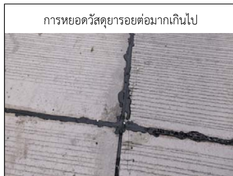
รูปที่ 161 การหยอดวัสดุรอยต่อ
