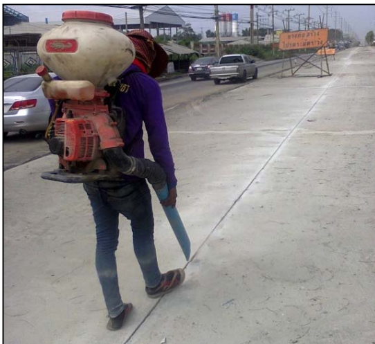
รูปที่ 88 การทำความสะอาดรอยต่อ และการใช้วัสดุทารอยต่อ (Joint Primer)
