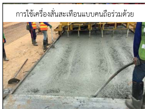
รูปที่ 133 เครื่องสั่นสะเทือน (Vibrator Machine)
