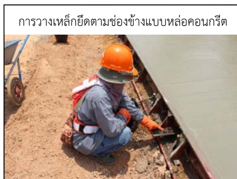
รูปที่ 128 การวางเหล็กยึด (Tie bar)
