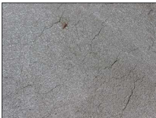
รูปที่ 141 รอยแตกที่เกิดจากการสูญเสียน้ำในสภาพอากาศร้อน
