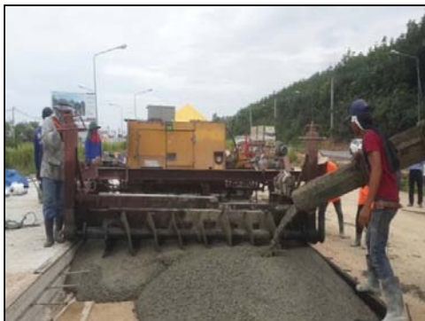
รูปที่ 143 การเทคอนกรีตโดยใช้เครื่องปูแบบหล่อคอนกรีต
