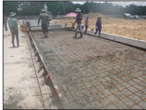
รูปที่ 131 ห้ามคนงานขึ้นไปเหยียบบนเหล็กเสริม
