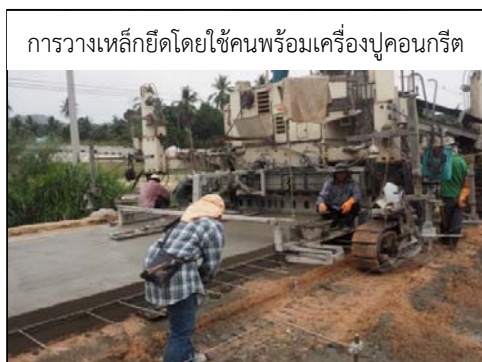
รูปที่ 128 การวางเหล็กยึด (Tie bar)
