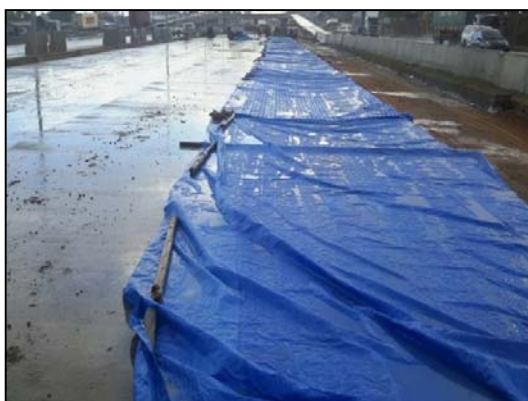
รูปที่ 142 การใช้ผ้าใบคลุมกันฝน
