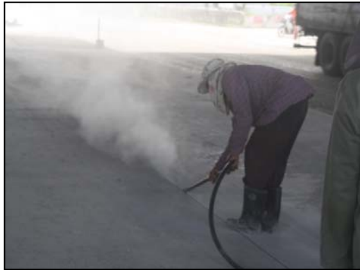
รูปที่ 158 การทำความสะอาดรอยต่อก่อนยารอยต่อ
