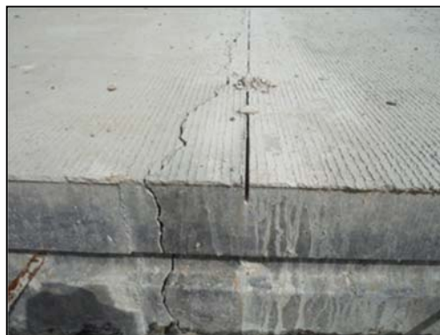
รูปที่ 157 คอนกรีตแตกไม่ตรงรอยตัด
