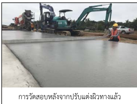
รูปที่ 150 การตรวจสอบความเรียบของผิวคอนกรีตระหว่างการก่อสร้าง
