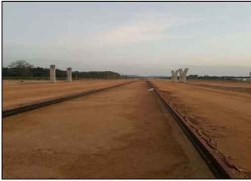
รูปที่ 115 แบบหล่อคอนกรีตที่เหมาะสม
