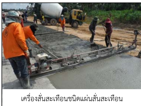
รูปที่ 134 (ต่อ) เครื่องสั่นสะเทือน (Vibrator Machine)
