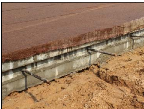
รูปที่ 124 เหล็กยึดรอยต่อเพื่อหดตามยาว
