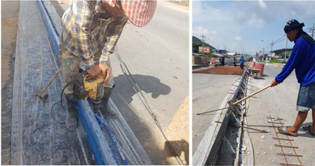
รูปที่ 15 การตั้งแบบคอนกรีต ทางหลวงหมายเลข 3 ศรีราชา – อ่าวอุดม, การเจาะนำด้วยสว่าน (ซ้าย) การตอกหมุดยึดแบบคอนกรีต (ขวา)
