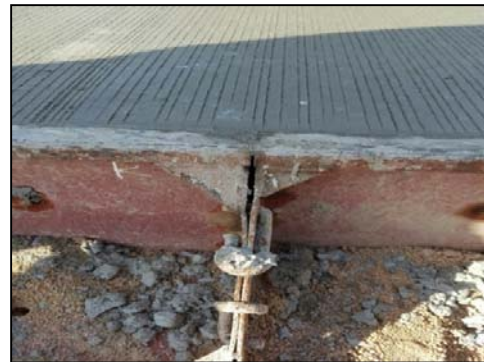
รูปที่ 116 หมุดยึดแบบและส่วนประกอบสำหรับยึดปลายแบบ
