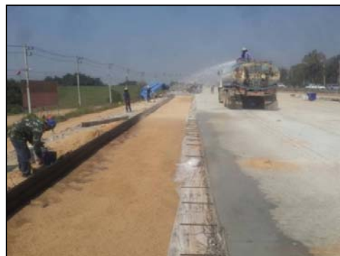
รูปที่ 118 การใช้เหล็กเกลี่ยทรายเพื่อให้ได้ระดับและการพ่นน้ำให้ทรายชุ่ม
