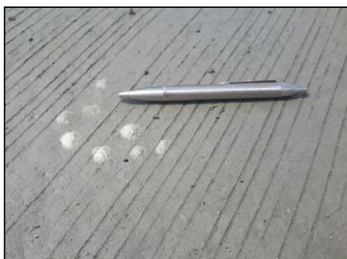
รูปที่ 97 ลักษณะของสารเคลือบคอนกรีตที่พ่นเป็นเยื่อบาง ๆ คลุมผิวคอนกรีต
