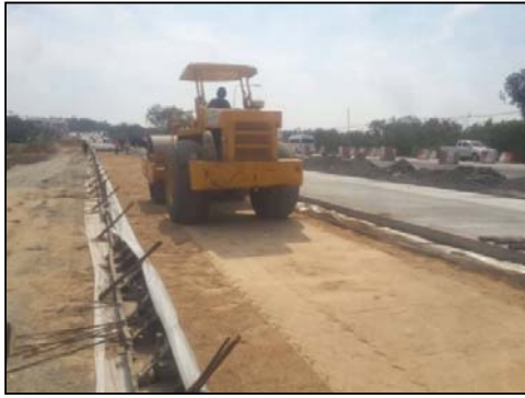
รูปที่ 119 การบดอัดโดยใช้เครื่องจักร
