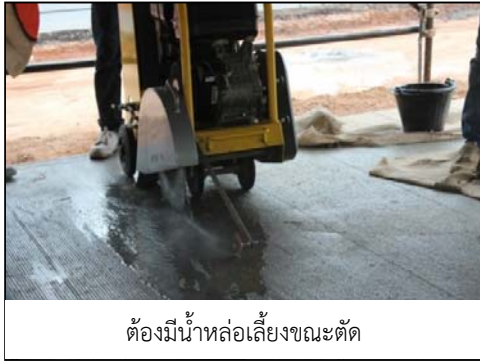
รูปที่ 153 การตัดรอยต่อด้วยเครื่องตัดคอนกรีต
