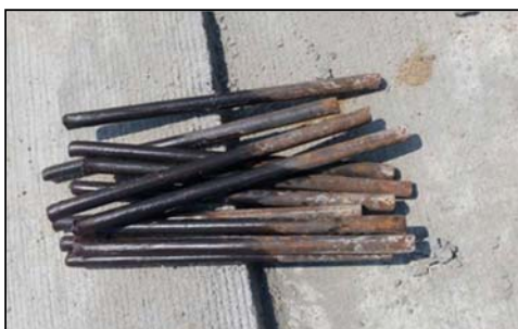
เหล็กเดือยที่ควรแก้ไขก่อนนำมาใช้
