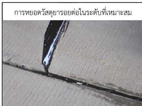
รูปที่ 161 การหยอดวัสดุรอยต่อ
