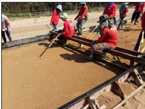
รูปที่ 118 การใช้เหล็กเกลี่ยทรายเพื่อให้ได้ระดับและการพ่นน้ำให้ทรายชุ่ม
