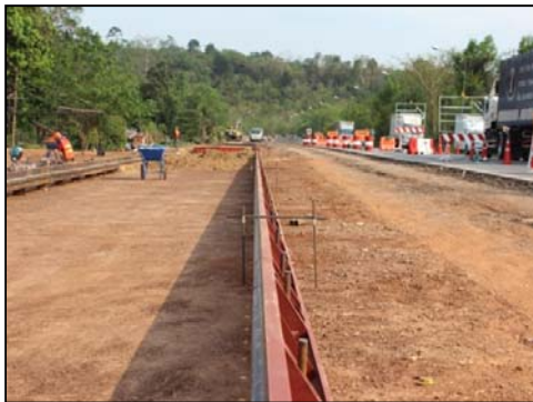
รูปที่ 116 หมุดยึดแบบและส่วนประกอบสำหรับยึดปลายแบบ
