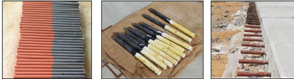
รูปที่ 72 ตัวอย่างเหล็กเดือย (Dowel Bar)
