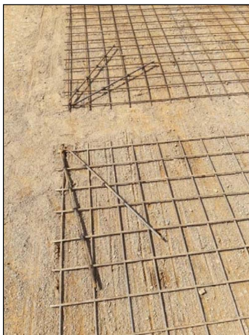
รูปที่ 70 ตัวอย่างเหล็กเสริมมุม
