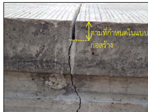
รูปที่ 156 ขนาดของรอยตัด
