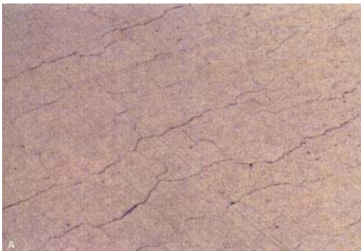
รูปที่ 55 DESTRUCTIVE ALKALI-SILICA REACTION IN PAVEMENT.
