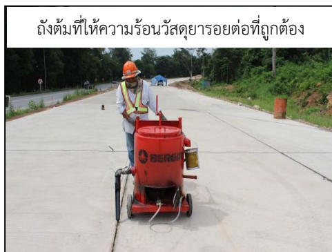
รูปที่ 160 ถังต้มที่ให้ความร้อนวัสดุรอยต่อ
