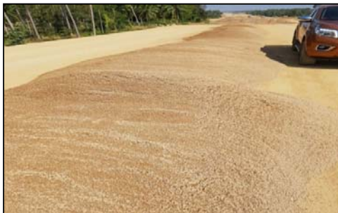
วัสดุทรายรองถนนคอนกรีตที่ดี
