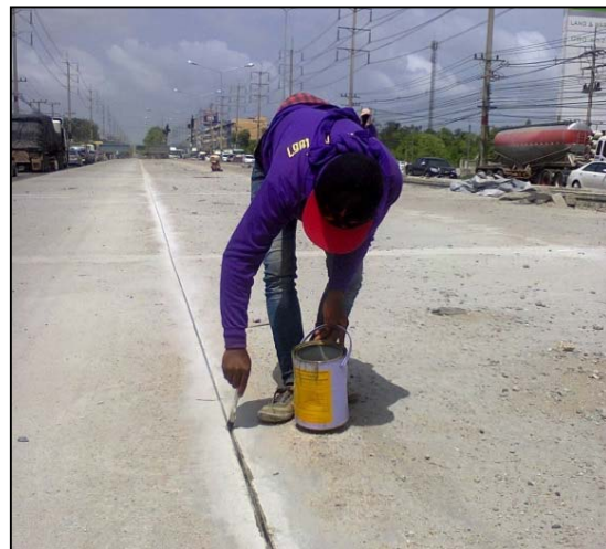
รูปที่ 88 การทำความสะอาดรอยต่อ และการใช้วัสดุทารอยต่อ (Joint Primer)
