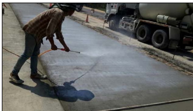
รูปที่ 96 การฉีดยาสารเคลือบคอนกรีตเป็นเยื่อบาง ๆ คลุมผิวคอนกรีต
