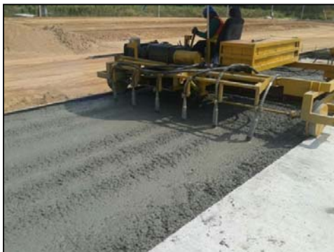
รูปที่ 145 การใช้เครื่องสั่นสะเทือนอัดแต่งคอนกรีต
