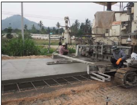
รูปที่ 135 เครื่องแต่งผิวคอนกรีตที่ติดตั้งพร้อมเครื่องปูคอนกรีต
