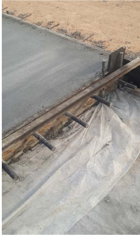
รูปที่ 12 การวางแผนโยสั้งเคราะห์ได้ผิวทางถนนคอนกรีต
