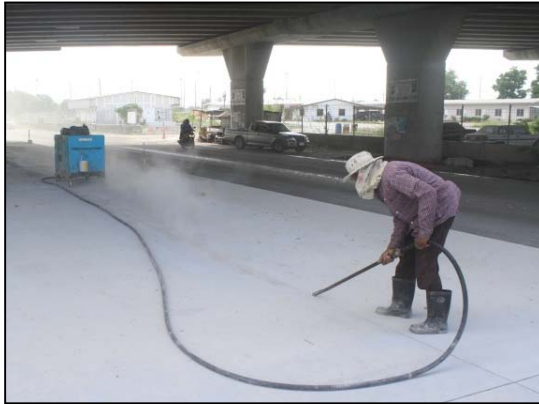
รูปที่ 89 การทำความสะอาดรอยต่อ และการใช้วัสดุทารอยต่อ (Joint Primer)
