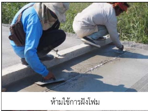
รูปที่ 154 การทำรอยต่อที่ไม่ถูกต้อง
