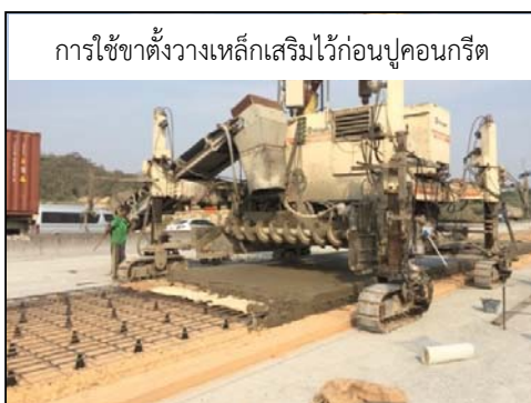
รูปที่ 130 การวางเหล็กเสริม
