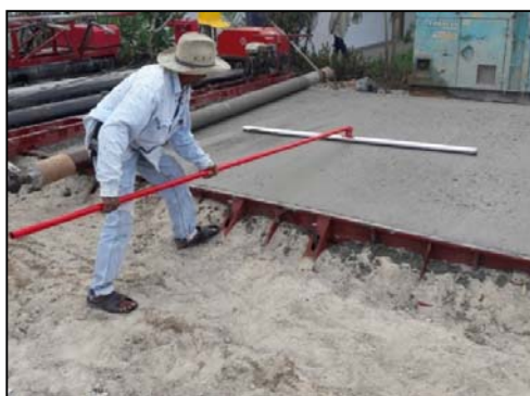
รูปที่ 147 การแต่งผิวคอนกรีตโดยใช้ไม้ปาดแต่ง
