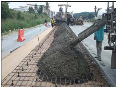
รูปที่ 144 การเทคอนกรีตโดยใช้เครื่องปูคอนกรีตแบบเลื่อน
