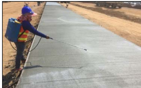
การใช้สารประกอบอย่างเหลวเคลือบคอนกรีต
