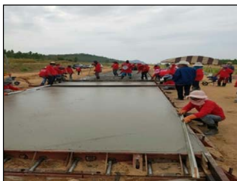
รูปที่ 147 การแต่งผิวคอนกรีตโดยใช้ไม้ปาดแต่ง
