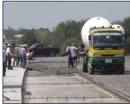
รูปที่ 79 ตัวอย่างเหล็กยึด (Tie Bar) ใส่ตามแนวรอยต่อตามยาว
