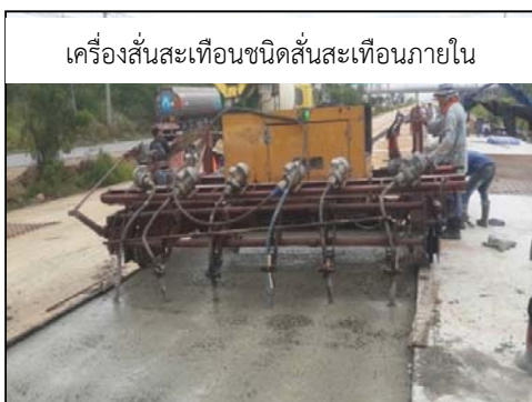
รูปที่ 133 เครื่องสั่นสะเทือน (Vibrator Machine)
