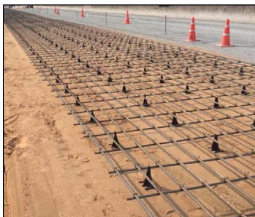
รูปที่ 69 ตัวอย่างตะแกรงเหล็กเส้น
