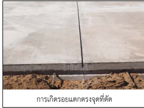
รูปที่ 153 การตัดรอยต่อด้วยเครื่องตัดคอนกรีต
