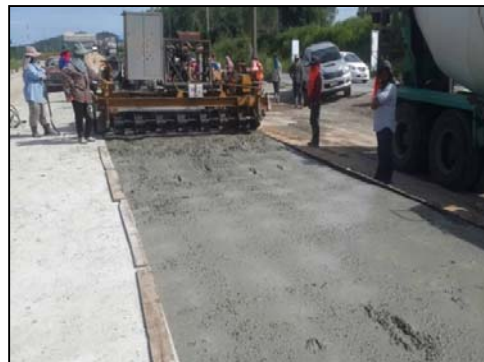
รูปที่ 143 การเทคอนกรีตโดยใช้เครื่องปูแบบหล่อคอนกรีต
