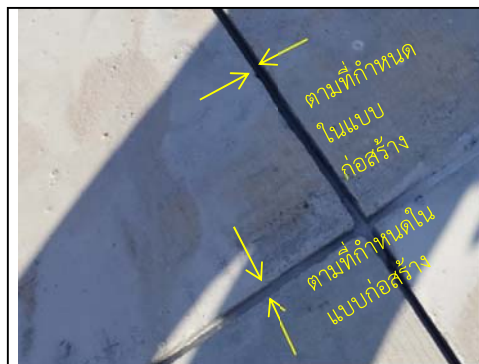
รูปที่ 156 ขนาดของรอยตัด
