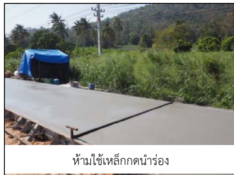
รูปที่ 154 การทำรอยต่อที่ไม่ถูกต้อง
