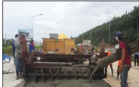
เครื่องปูคอนกรีตบนแบบหล่อคอนกรีต
