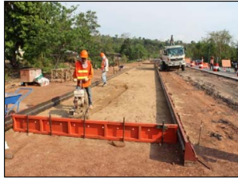
รูปที่ 119 การบดอัดโดยใช้เครื่องจักร
