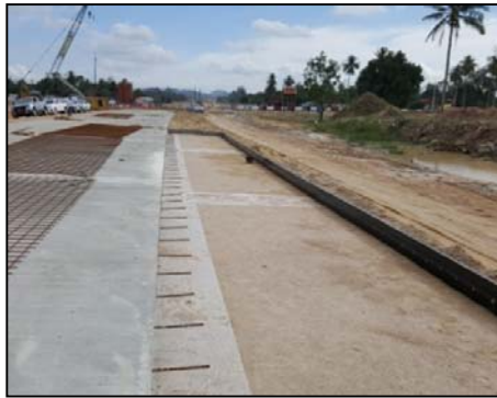
รูปที่ 79 ตัวอย่างเหล็กยึด (Tie Bar) ใส่ตามแนวรอยต่อตามยาว
