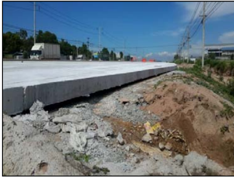
รูปที่ 121 การเกิดโพรงใต้ถนนคอนกรีต
