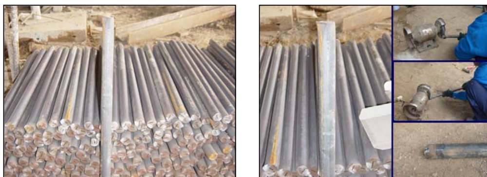
รูปที่ 71 ตัวอย่างเหล็กเดือย (Dowel Bar)
