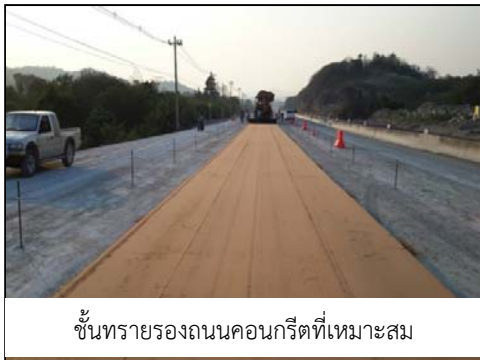
รูปที่ 120 ชั้นทรายรองถนนคอนกรีต
