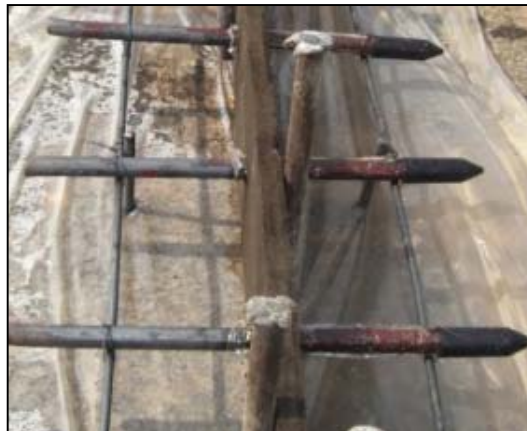
รูปที่ 82 ตัวอย่างการใส่ปลอกเหล็กเดี่ยว
