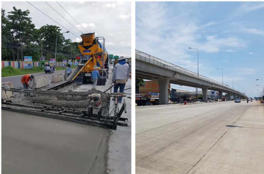
รูปที่ 16 การก่อสร้าง ทางหลวงหมายเลข 3 ศรีราชา – อ่าวอุดม, การเทคอนกรีต (ซ้าย) ผิวทางคอนกรีตหลัง ดำเนินการแล้วเสร็จ (ขวา)
