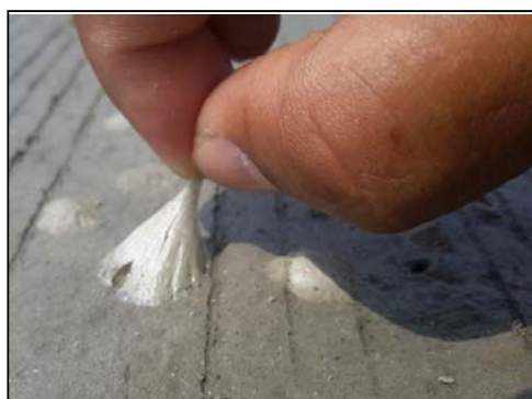
รูปที่ 97 ลักษณะของสารเคลือบคอนกรีตที่พ่นเป็นเยื่อบาง ๆ คลุมผิวคอนกรีต
