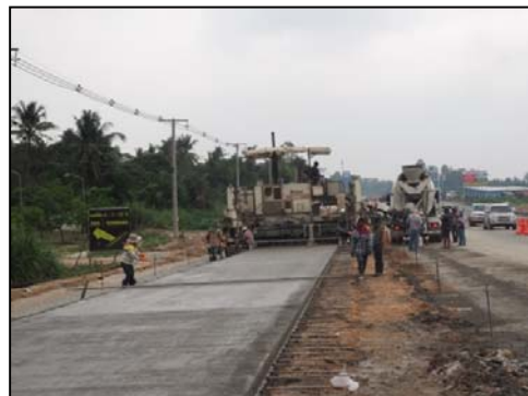
รูปที่ 144 การเทคอนกรีตโดยใช้เครื่องปูคอนกรีตแบบเลื่อน
