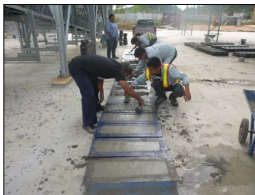
รูปที่ 101 การทดลองผสมคอนกรีตตามรายการคำนวณ (Trial Mixed)
