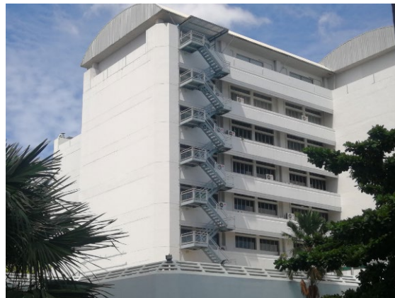
รูปที่ 2.5 บันไดหนีไฟภายนอกอาคาร
