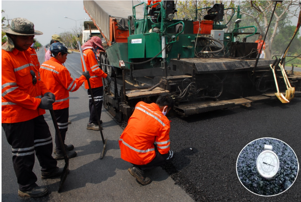
รูปที่ 5.3 การตรวจสอบอุณหภูมิส่วนผสมแอสฟัลต์คอนกรีตขณะปูผิว
