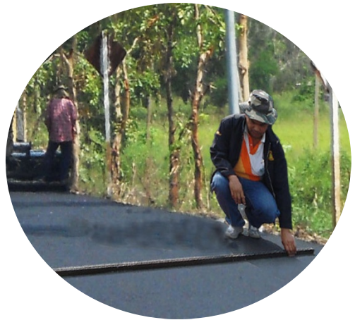
รูปที่ 6.1 การตรวจสอบความเรียบตรงของผิวทาง (Surface Tolerance)
