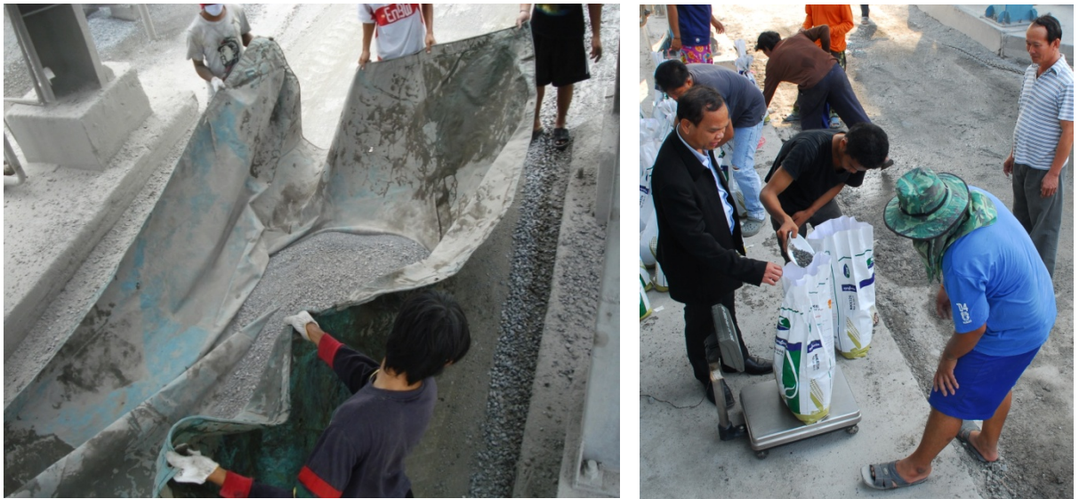
รูปที่ 2.22 การนำวัสดุที่ทดลองปล่อยลงหม้อผสมมาชั่งตรวจสอบค่าน้ำหนักอีกครั้ง
