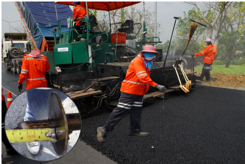
รูปที่ 5.4 การตรวจสอบความหนาเบื้องต้นก่อนทำการบดทับ
