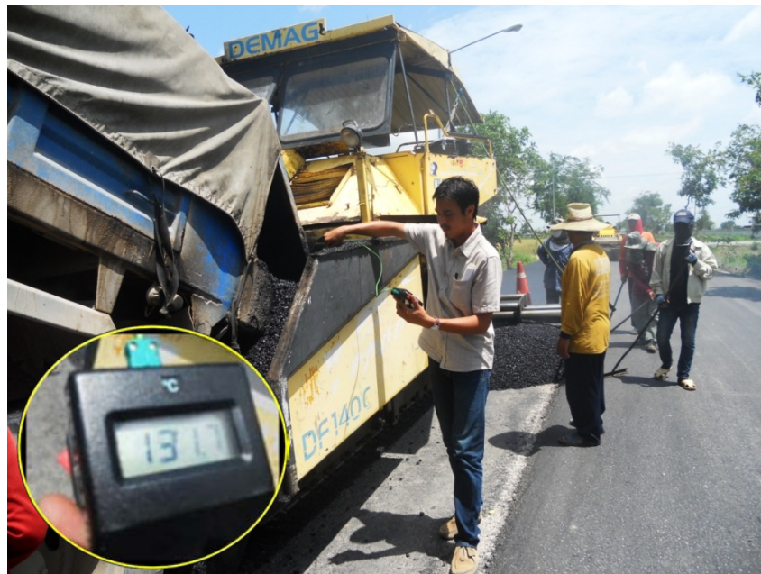
รูปที่ 6.6 การตรวจสอบอุณหภูมิส่วนผสมมวลบรรทุกในสถานที่ก่อสร้างก่อนปู
