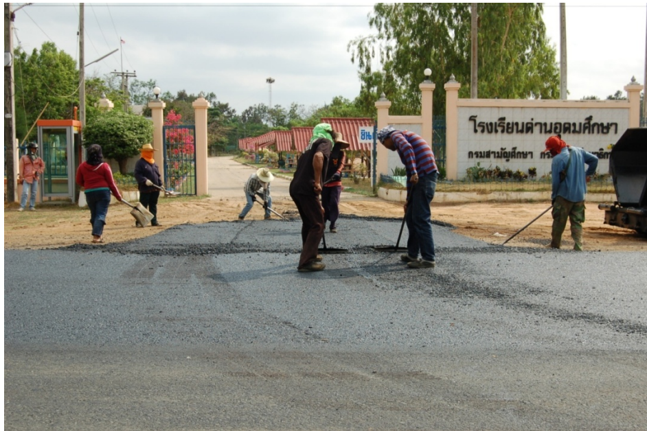
รูปที่ 5.6 การปูส่วนผสมแอสฟัลต์คอนกรีตบริเวณทางแยก ทางเชื่อม
