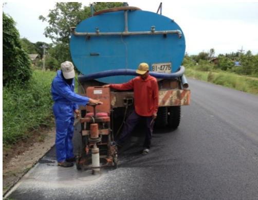
รูปที่ 6.7 การเจาะเก็บก้อนตัวอย่างหลังจากปูและบดอัดแล้วเสร็จ
