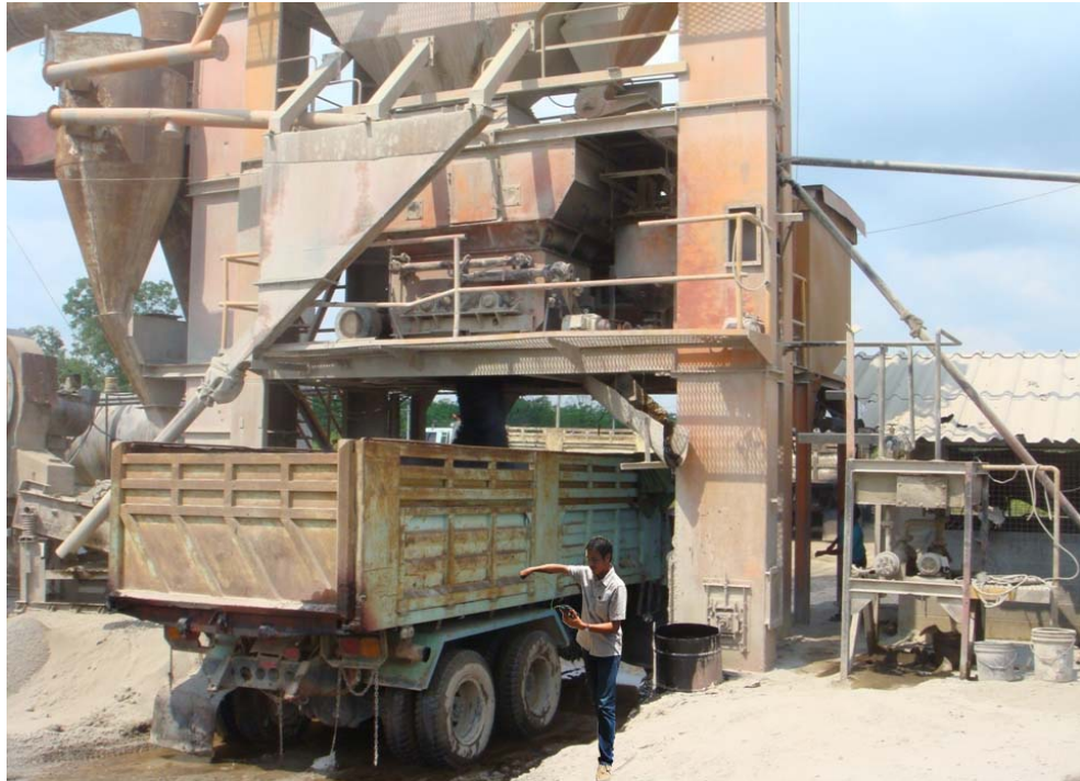
รูปที่ 5.1 การตรวจสอบอุณหภูมิส่วนผสมแอสฟัลต์คอนกรีตก่อนออกจากโรงงาน
