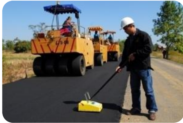
รูปที่ 6.2 การตรวจสอบความแน่นบดทับของงานแอสฟัลต์คอนกรีตในสนาม ด้วยเครื่องมือ Pave Tacker
