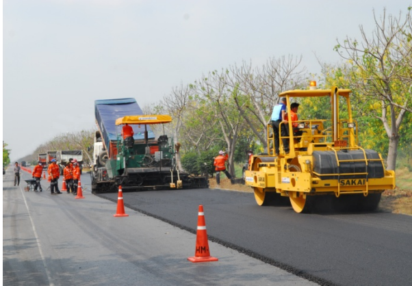
รูปที่ 5.11 การบดทับส่วนผสมแอสฟัลต์คอนกรีตทันทีที่ปูออกจาก Paver
