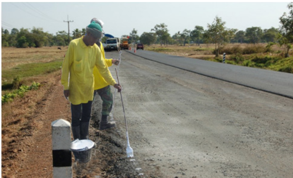
รูปที่ 4.3 การวางแนวขอบเขตที่จะปูส่วนผสมแอสฟัลต์คอนกรีต
