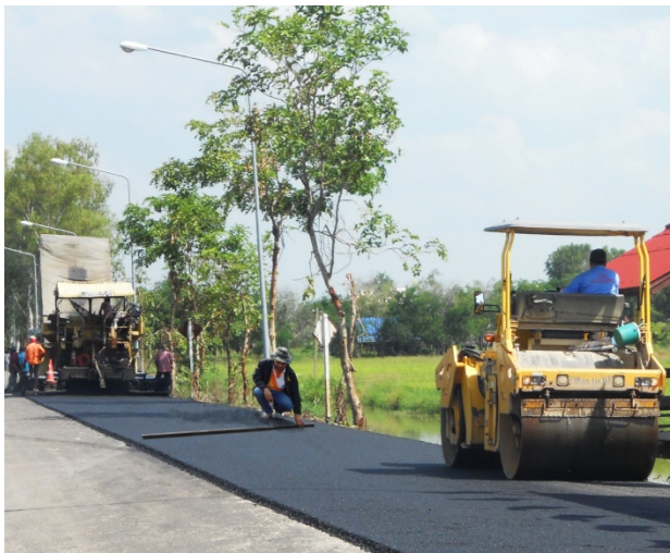
รูปที่ 6.1 การตรวจสอบความเรียบตรงของผิวทาง (Surface Tolerance)
