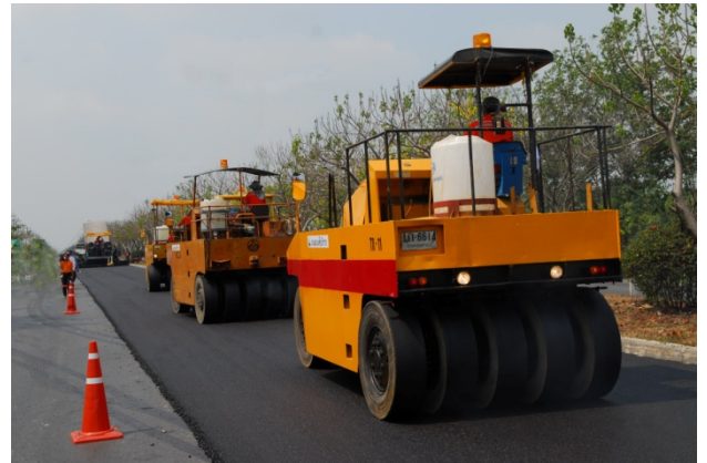
รูปที่ 5.11 การบดทับส่วนผสมแอสฟัลต์คอนกรีตทันทีที่ปูออกจาก Paver
