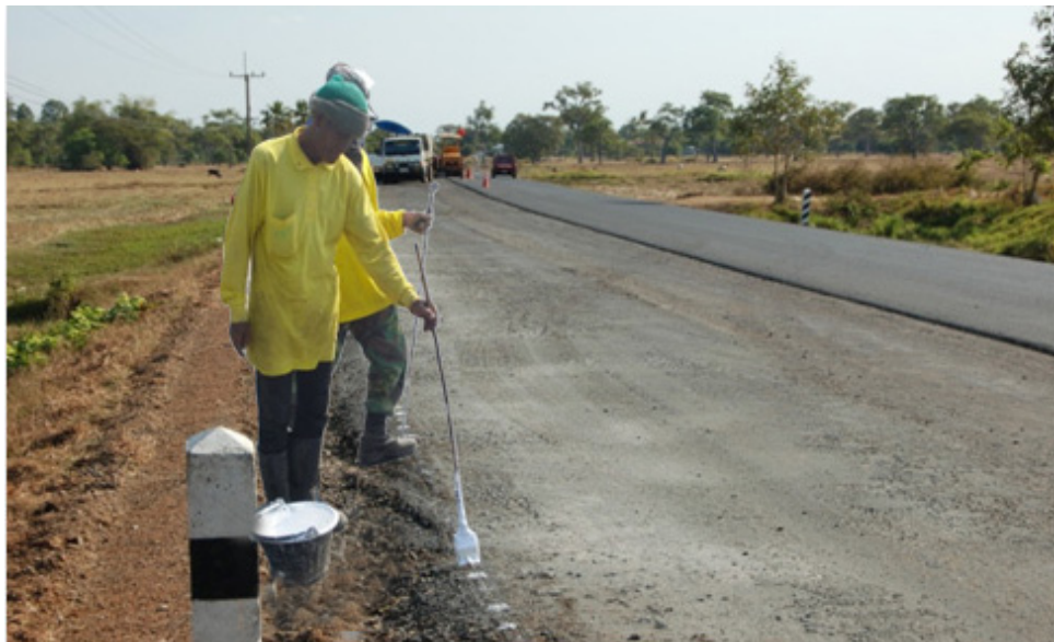
รูปที่ 5.5 การวางแผนขอบเขตที่จะปูส่วนผสมแอสฟัลต์คอนกรีต
