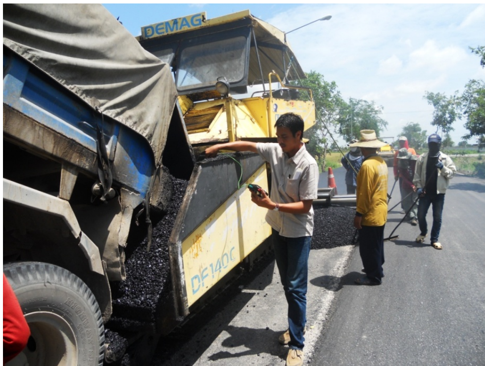
รูปที่ 5.2 การตรวจสอบอุณหภูมิส่วนผสมแอสฟัลต์คอนกรีตก่อนปูผิว
