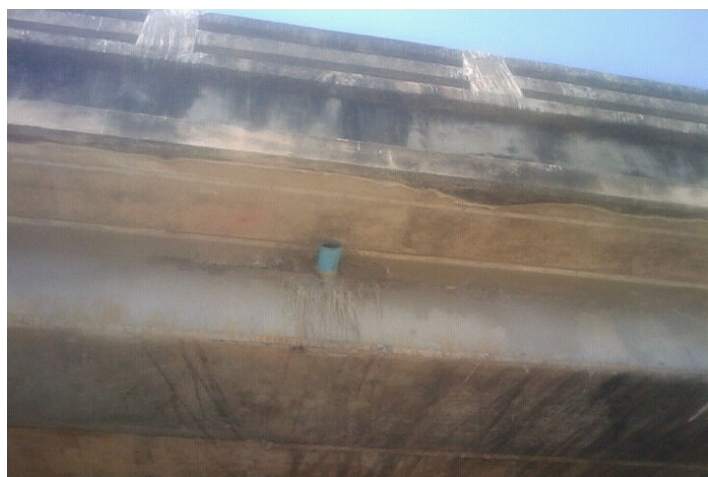
รูปที่ 1.14 แสดงท่อ PVC ในสะพานประเภท Box Beam
