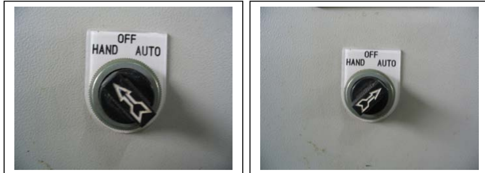
รูปที่ 55 บิดสวิตช์ลูกศรไปที่ตำแหน่ง “HAND” หรือ “AUTO”
