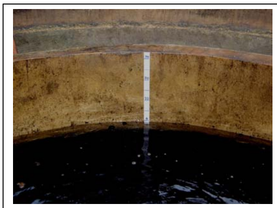
รูปที่ 20 การขีดระดับเพื่อวัดปริมาณน้ำดิบ
