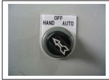
รูปที่ 12 สวิตช์ลูกศรที่ตำแหน่ง “HAND”
