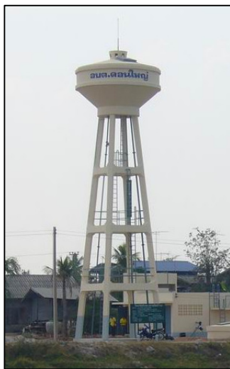
รูปที่ 53 หอถังสูง
