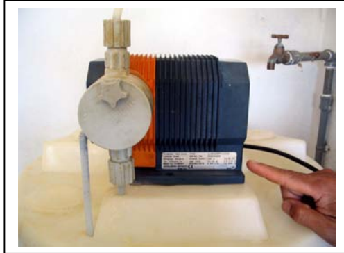
รูปที่ 30 รายละเอียดของเครื่องจ่ายสารละลายคลอรีน
