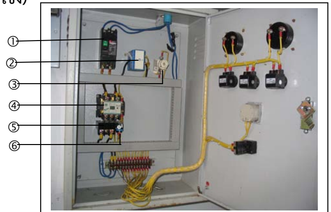
ลักษณะภายในตู้ควบคุม เครื่องสูบน้ำดี (แบบหอยโข่ง)
