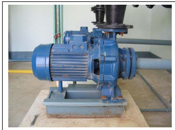
รูปที่ 36 เครื่องสูบน้ำแบบหอยโข่ง
