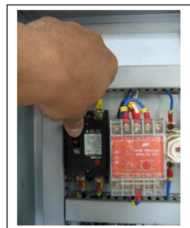
รูปที่ 54 ดันเบรกเกอร์ ที่ตู้ควบคุมไปที่ตำแหน่ง “ON”
