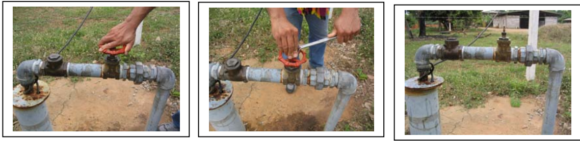
รูปที่ 21 การปรับประตุน้ำเข้าสู่ระบบกรองและประตุน้ำที่ถอดพวงมาลัยแล้ว
