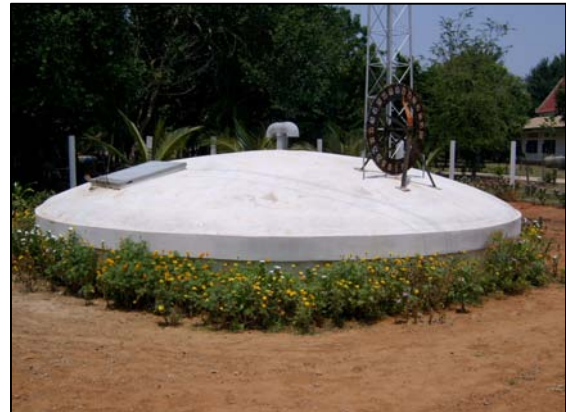
รูปที่ 29 ถังน้ำไฮดรอลิก 20 ลบ.ม./100 ลบ.ม.
