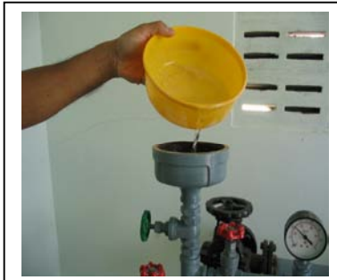
รูปที่ 40 การกรอน้ำเพื่อไล่อากาศในท่อดูด
