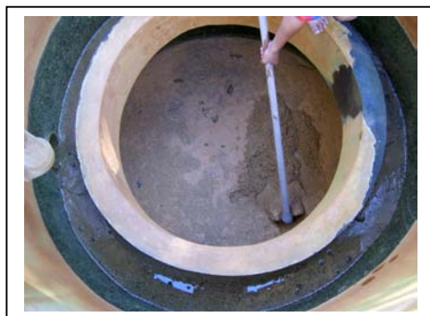
รูปที่ 67 การใช้จอบคุ้ยหน้าทรายกรอง
