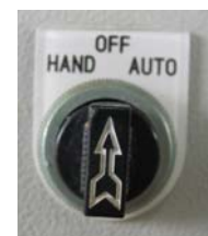
รูปที่ 48 สวิตช์ลูกศรที่ตำแหน่ง “OFF”
