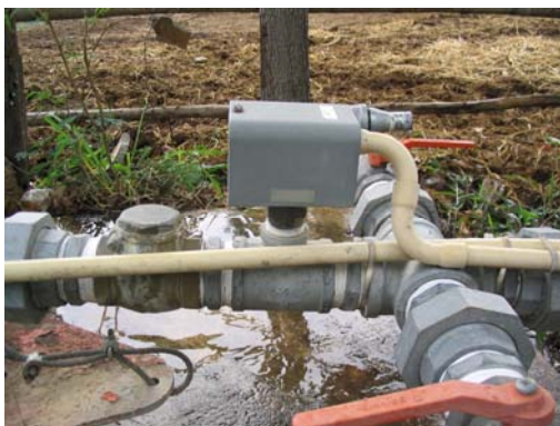
รูปที่ 20 การติดตั้งสวิตช์ใบพายที่ปากบ่อบาดาล
