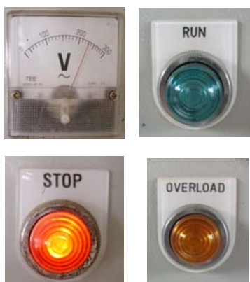
รูปที่ 44 โวลท์มิเตอร์ และหลอดไฟสีแดง, สีเขียว และสีเหลือง
