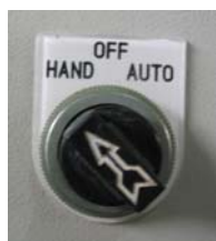
รูปที่ 56 กดสวิตช์ลูกศรไปที่ตำแหน่ง “HAND” หรือ “AUTO” และกดปุ่ม “START”
