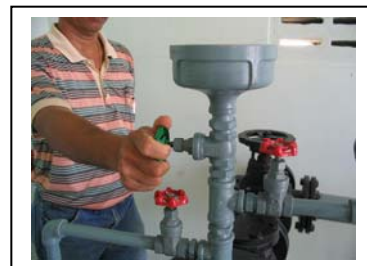
รูปที่ 39 การเติมน้ำเข้าเครื่องสูบน้ำโดยใช้น้ำจากท่อถังสูง
