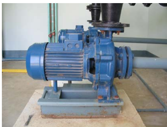
รูปที่ 34 เครื่องสูบน้ำแบบหอยโข่ง
