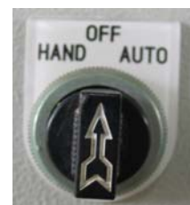
รูปที่ 15 สวิตช์ลูกศรที่ตำแหน่ง “OFF”
