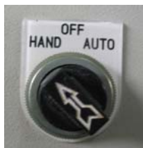
รูปที่ 45 สวิตช์ลูกศรที่ตำแหน่ง “HAND”
