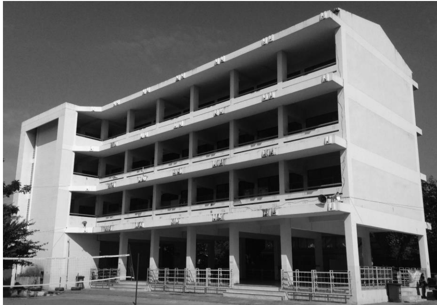
รูปที่ 4.2-1 ตัวอย่างภาพอาคารเรียนซึ่งกำหนดให้เป็นอาคารต้นแบบหลังที่ 2
