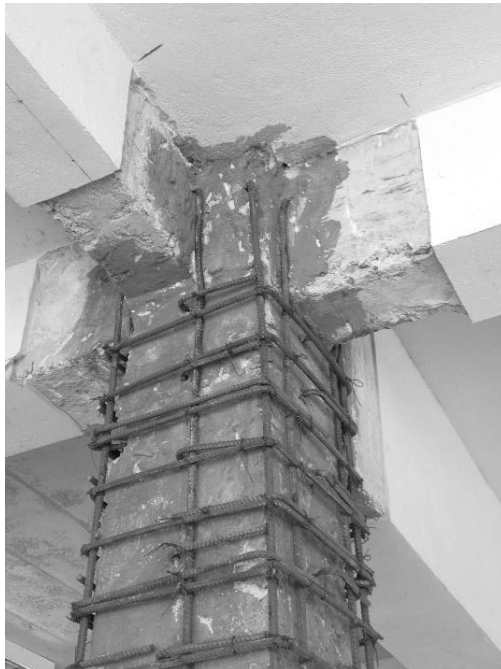
รูปที่ 3.3-2 ตัวอย่างและรายละเอียดการเสริมกำลังเสาด้วยการพอก (Concrete Jacketing)
