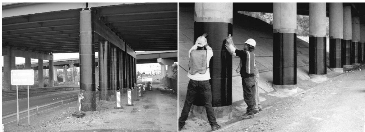
รูปที่ 3.3-4 ลักษณะการพัน FRP รอบเสาสะพาน [16]
