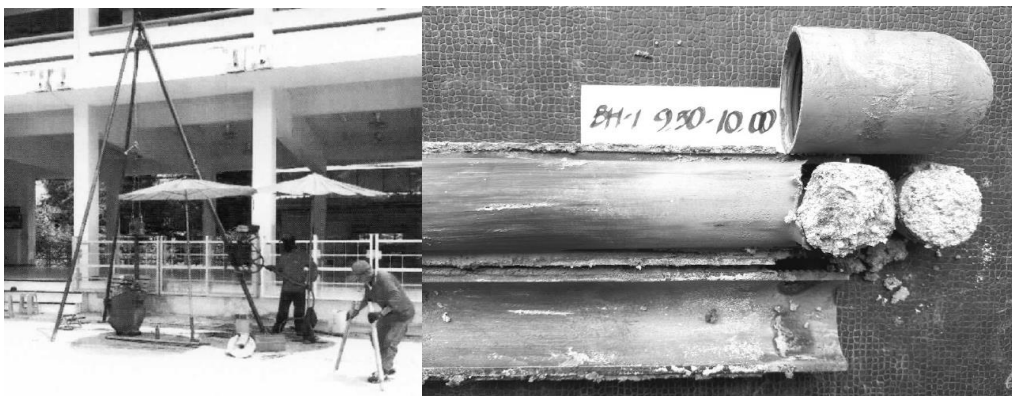
รูปที่ 2.2-3 การเจาะสำรวจในสนามและตัวอย่างดิน
