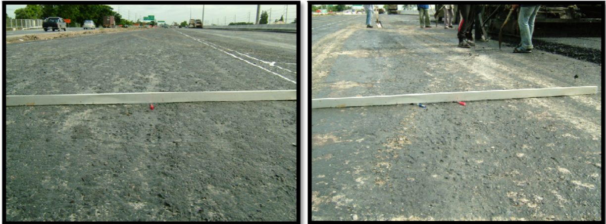
รูปที่ การใช้ Straight Edge เพื่อตรวจสอบความเรียบของผิวพื้นสะพานคอนกรีต
