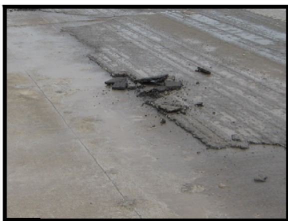
รูปที่ ผิวทางที่ทำการ Milling แล้วมีการหลุดร่อนของผิวทาง
