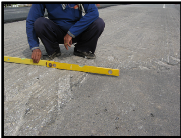
รูปที่ การใช้ Straight Edge เพื่อตรวจสอบระดับ Crown Slope
