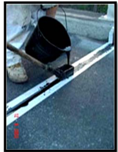
รูปที่ การเซาะร่องบริเวณรอยต่อ และการอุดร่องด้วยวัสดุ Mastic Joint Filler
