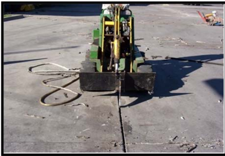
รูปที่ การเซาะร่องบริเวณรอยต่อ และการอุดร่องด้วยวัสดุ Mastic Joint Filler
