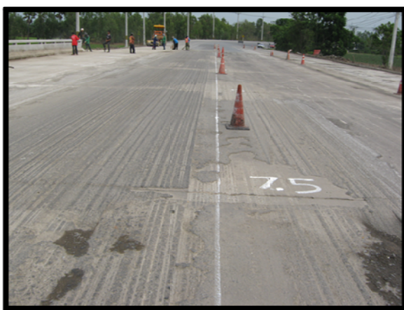
รูปที่ ผิวทางที่ทำการ Milling แล้วมีการหลุดร่อนของผิวทาง
