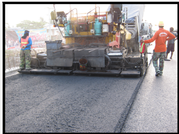
รูปที่ การตรวจสอบระดับ เพื่อกำหนดปริมาณงานปรับระดับ และรูปการปรับระดับ
