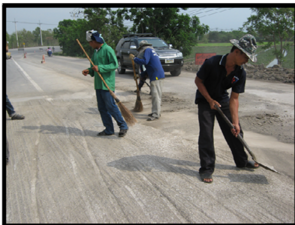
รูปที่ การทำความสะอาด จีดล้าง นำส่วนที่ไม่ยึดเกาะออก
