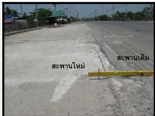
รูปที่ การใช้ Straight Edge เพื่อตรวจสอบระดับ Crown Slope
