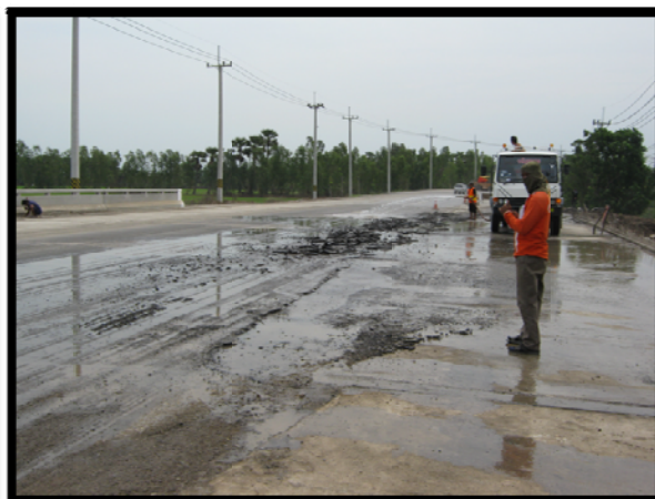
รูปที่ การทำความสะอาด จีดล้าง นำส่วนที่ไม่ยึดเกาะออก
