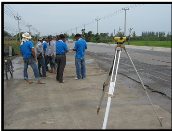
รูปที่ การตรวจสอบระดับ เพื่อกำหนดปริมาณงานปรับระดับ และรูปการปรับระดับ
