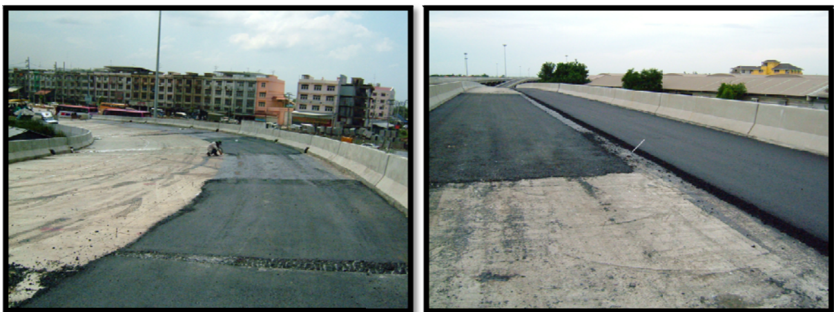
รูปที่ การปรับระดับผิวพื้นสะพานคอนกรีตด้วยแอสฟัลต์คอนกรีต
